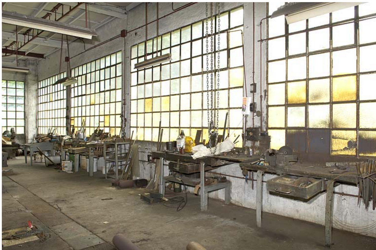
Atelier de mécanique. Etablis contre le mur sud.
