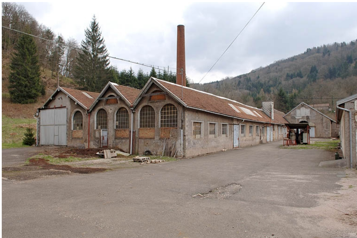
Ateliers de fabrication et cour de l'usine depuis le nord-ouest.
