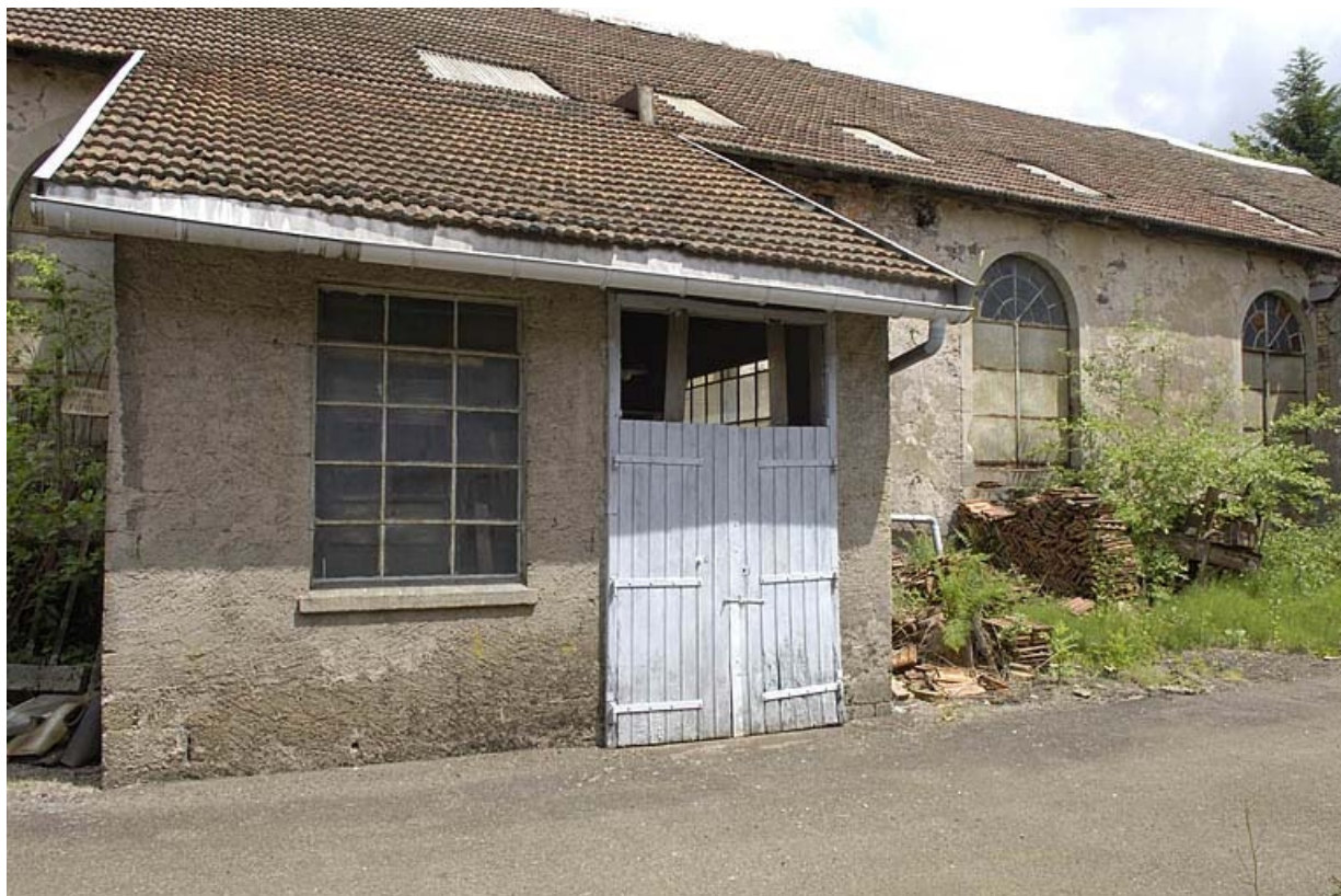
Local de stockage des ébauches et façade sud-ouest de la forge du Bas.
