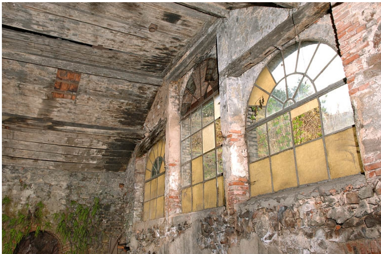
Mur sud de l'ancienne chaufferie et salle des machines.
