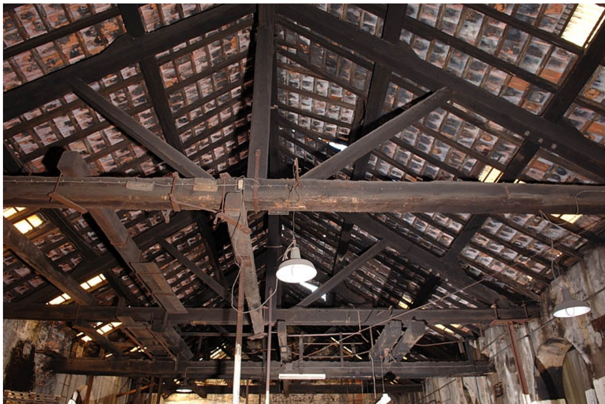
Charpente de la forge du Bas depuis le nord. 70, Corravillers R.D. 6, lieudit : Champs Fauvey
