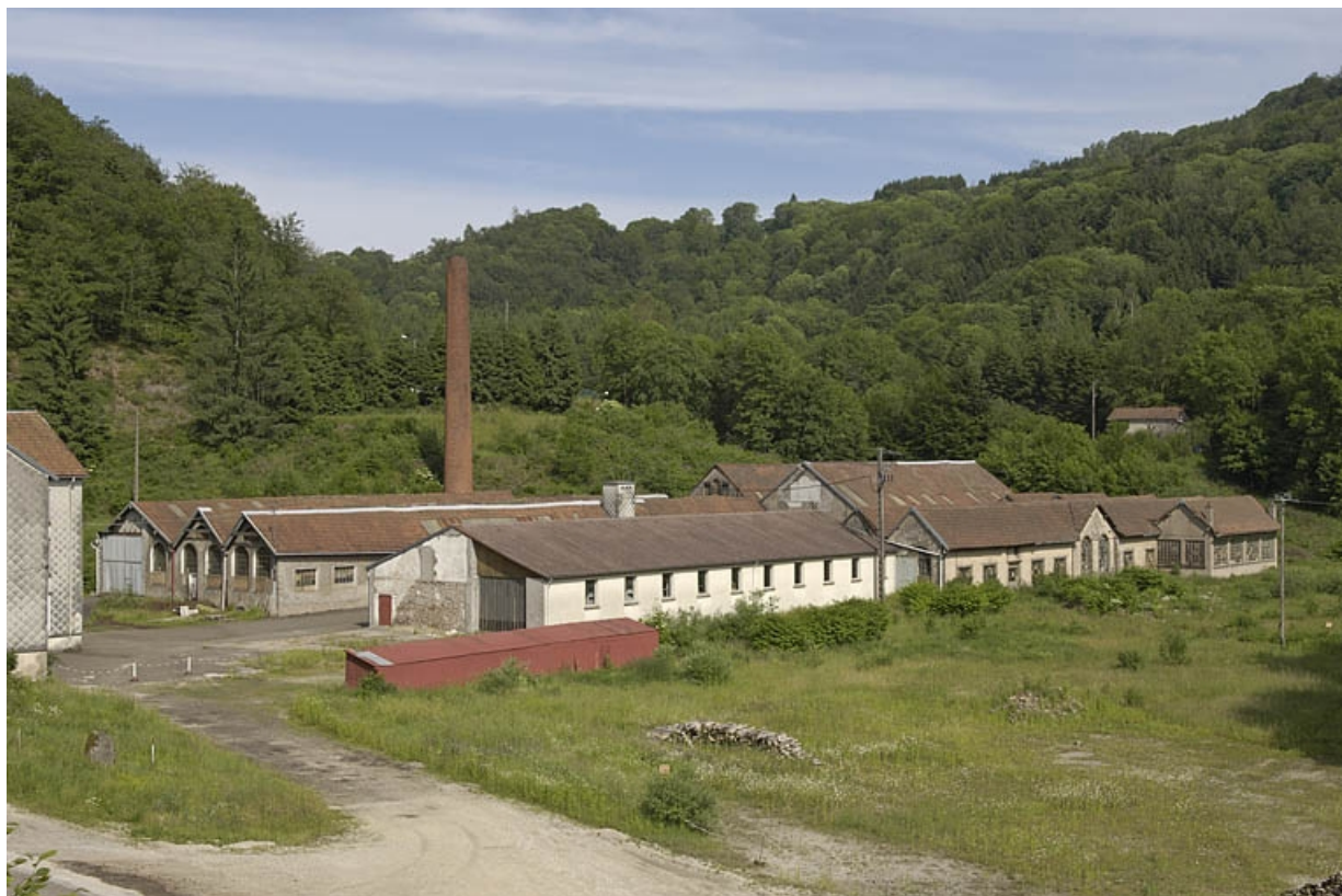
Les bâtiments de production vus depuis l'ouest.
