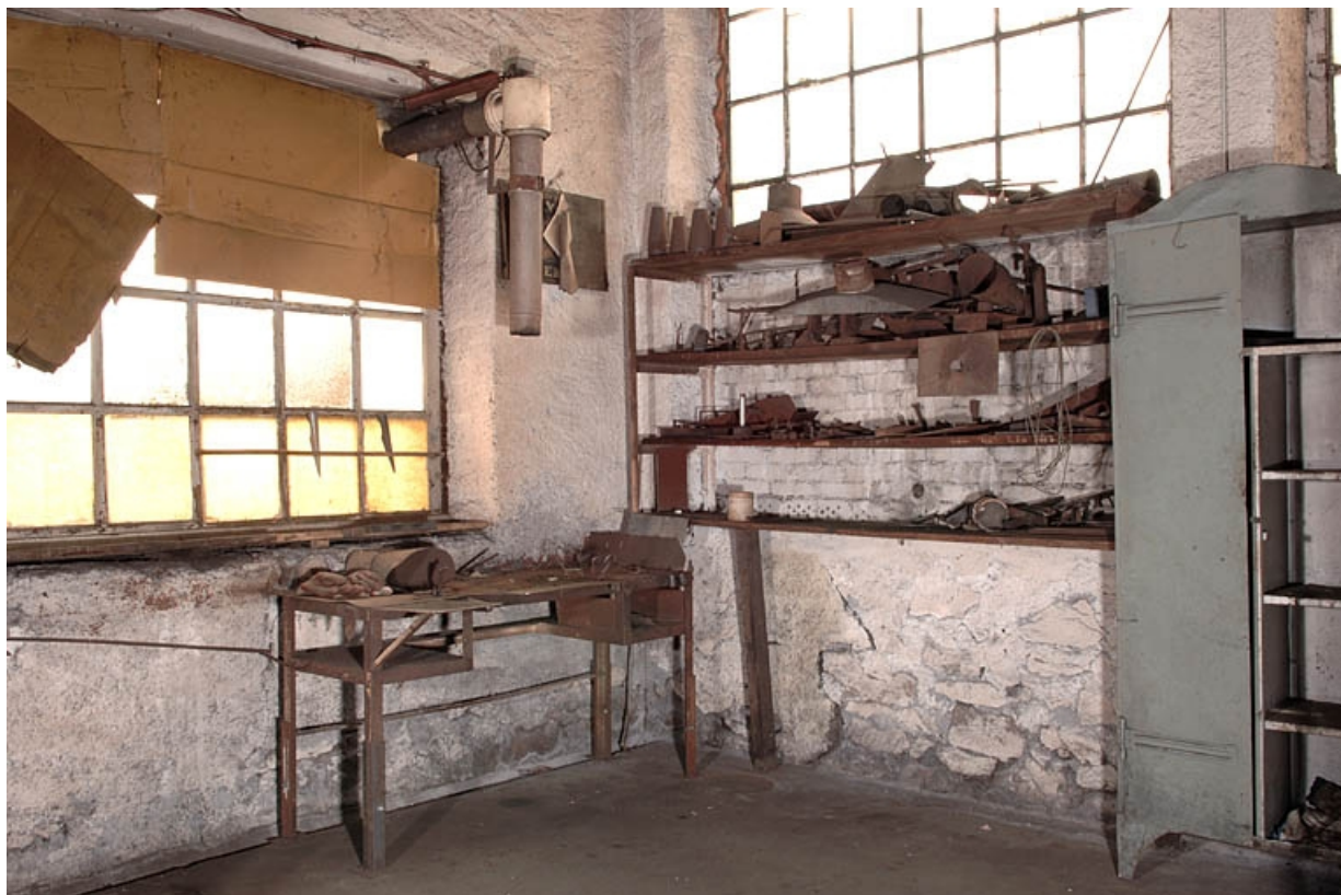
Atelier dit des Presses. Poste de soudure.
