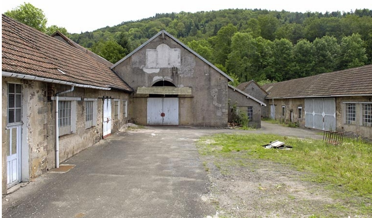
Atelier de polissage et forge du Bas depuis le nord-ouest.
