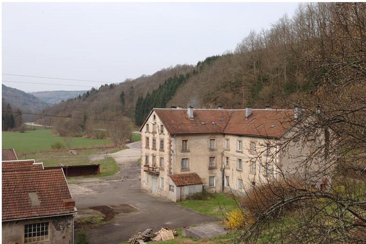
Vue plongeante, depuis le nord-est, sur le bâtiment des logements et bureaux.
