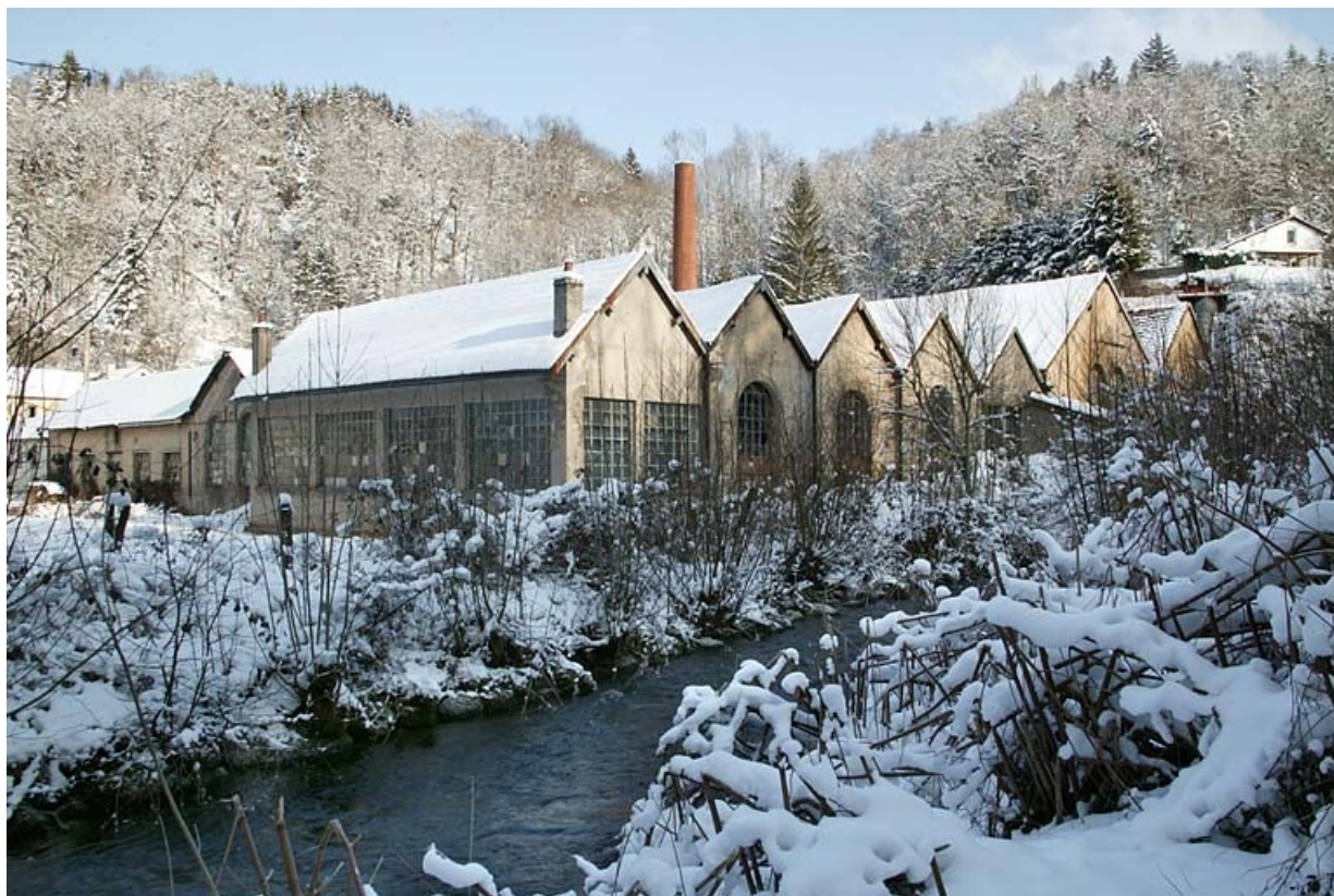
Vue des ateliers, depuis le sud, sous la neige.
