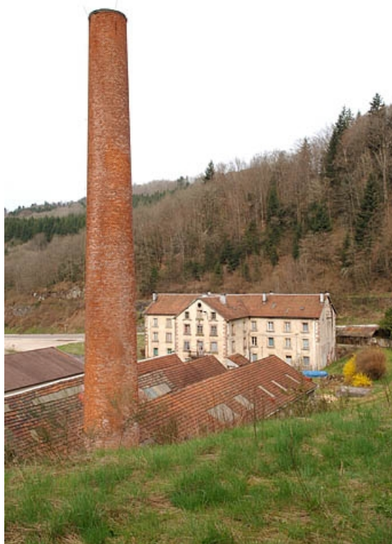
Vue plongeante depuis le nord-est (cadrage vertical).
