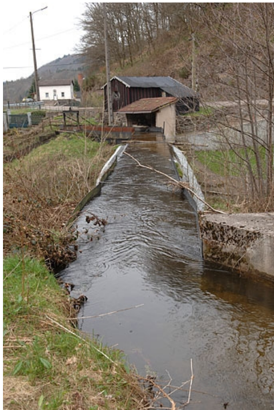
Le canal d'amenée du bassin de retenue enjambant le Breuchin.
