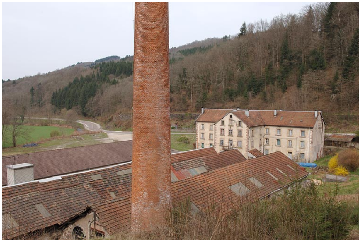
Vue plongeante depuis le nord-est.
