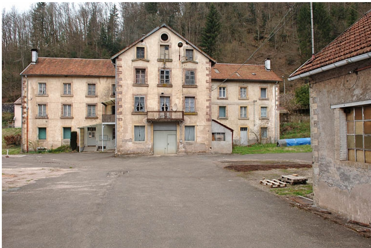
Le bâtiment des logements et bureaux depuis le sud-est.
