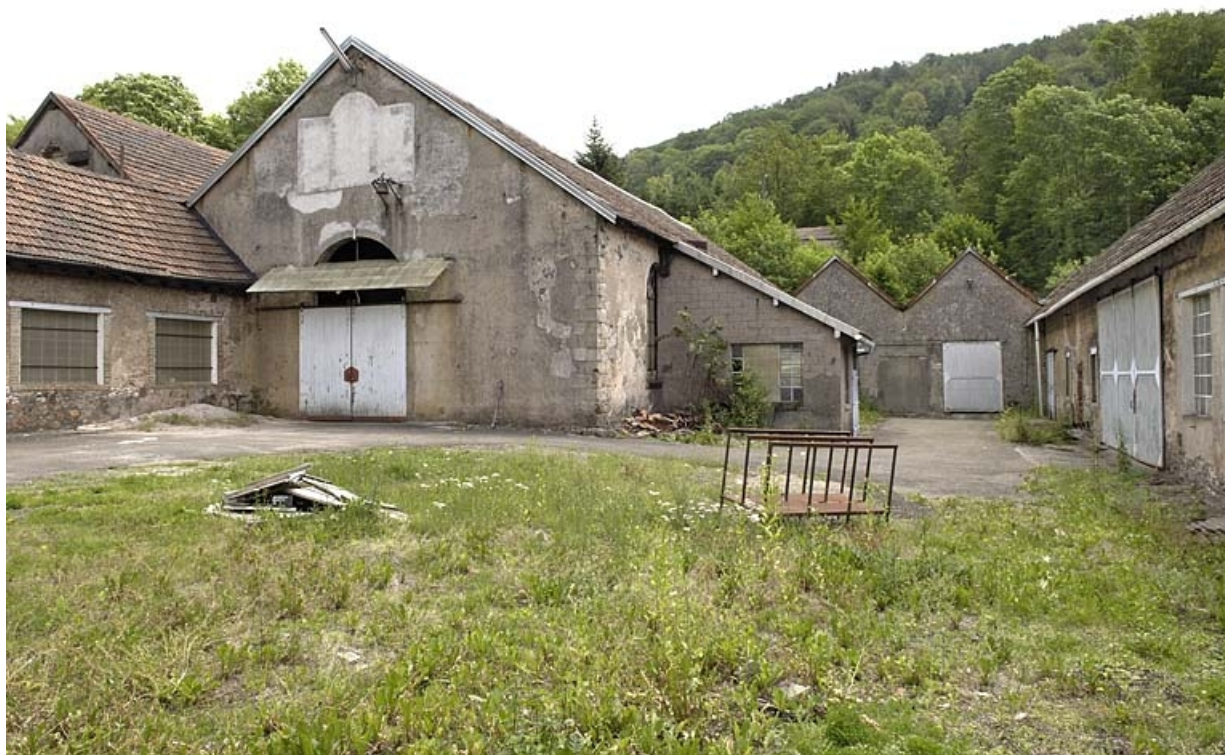
Pignon de la forge du Bas et atelier de réparation depuis l'ouest.
