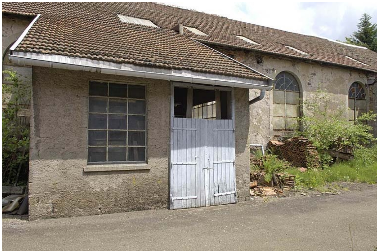
Local de stockage des ébauches et façade sud-ouest de la forge du Bas.
