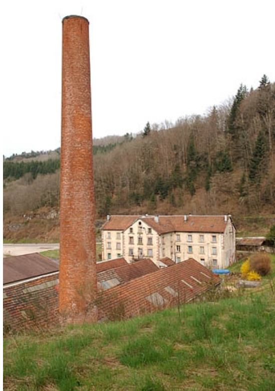
Vue plongeante depuis le nord-est (cadrage vertical).
