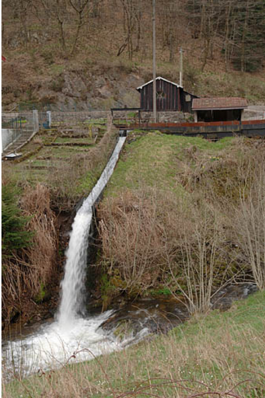
Le déversoir du bassin de retenue.
