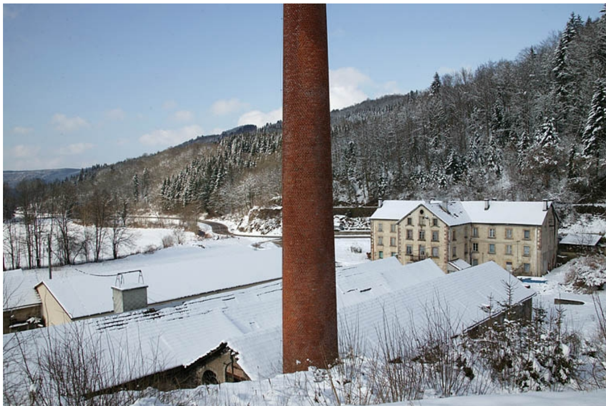
Vue plongeante, depuis le nord-est, sous la neige.
