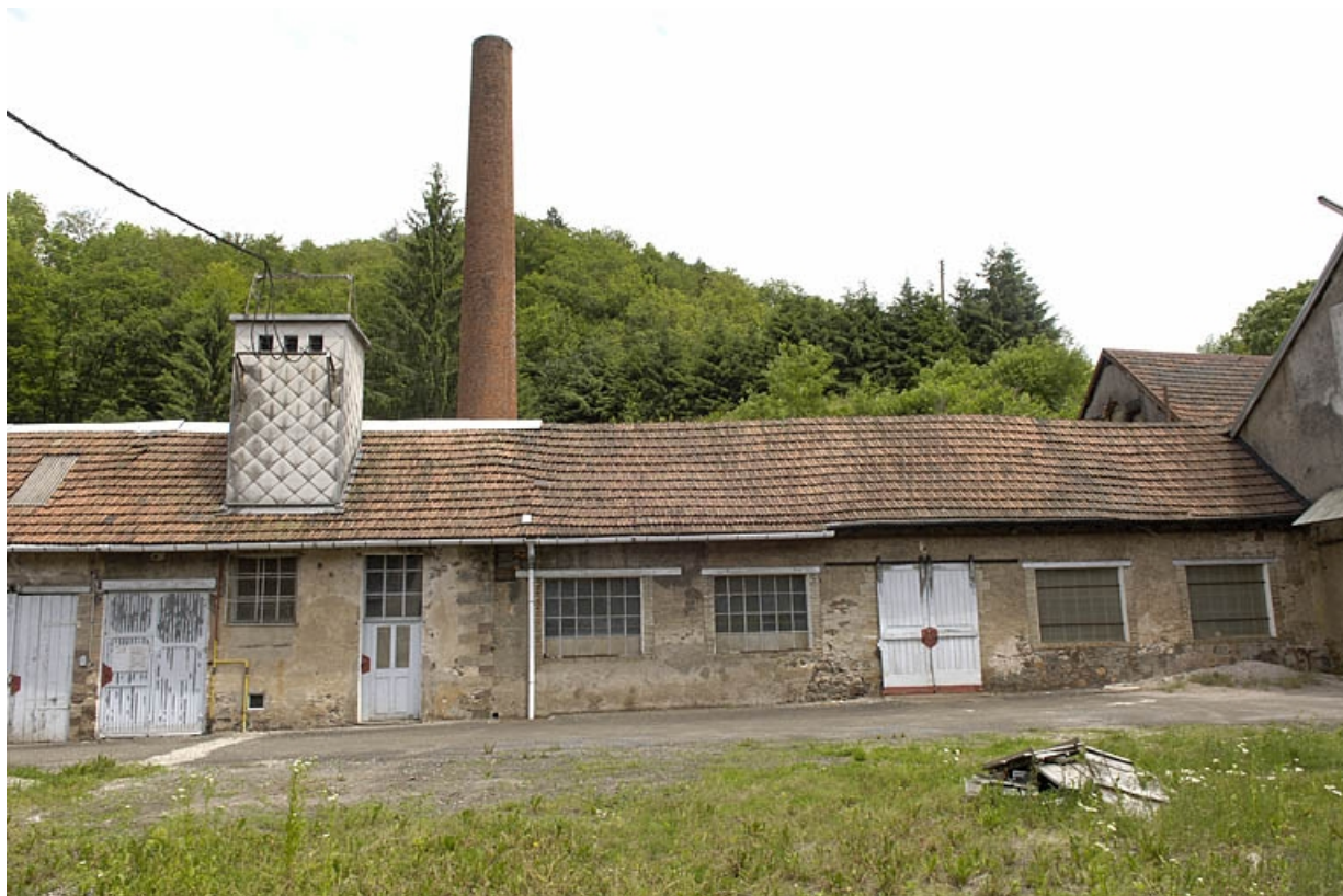
Façade sud-ouest de l'atelier de polissage.
