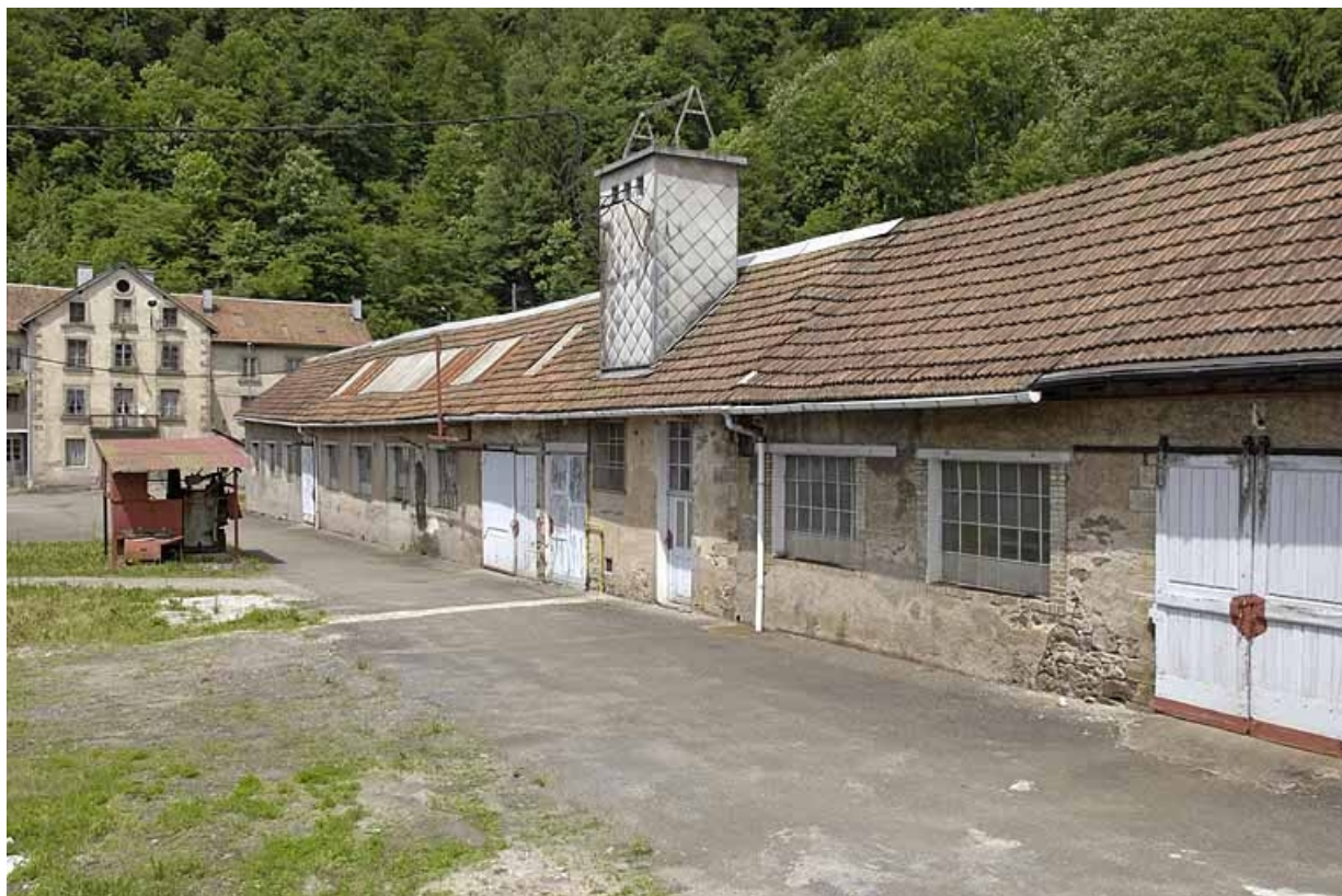
Vue de trois de la façade des ateliers (polissage, balanciers et presses).
