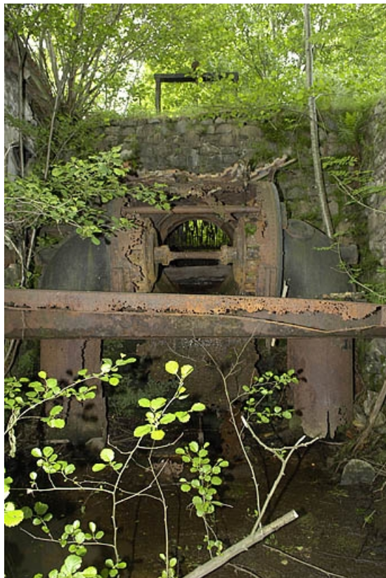
Vue d'ensemble de la turbine hydraulique.
