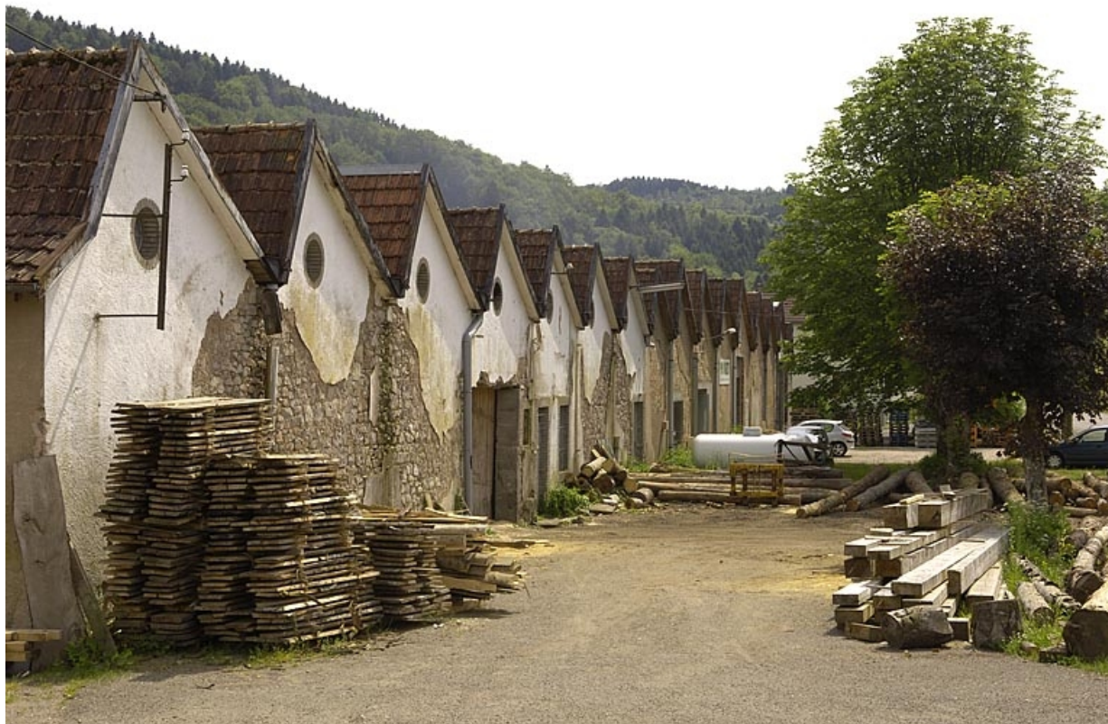
Pignons ouest de l'atelier de fabrication.
