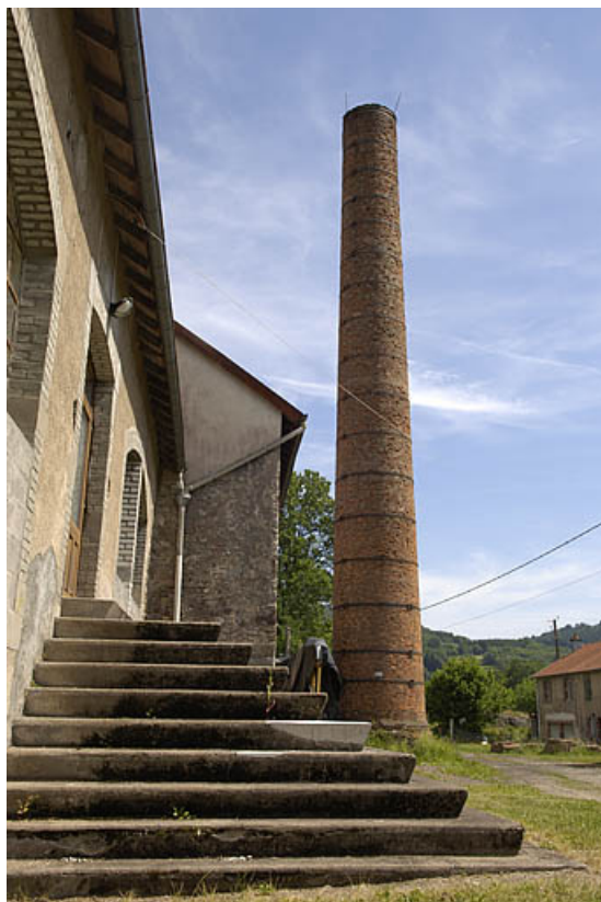
Escalier sur la façade postérieure et cheminée. 70, Corravillers R.D. 6
