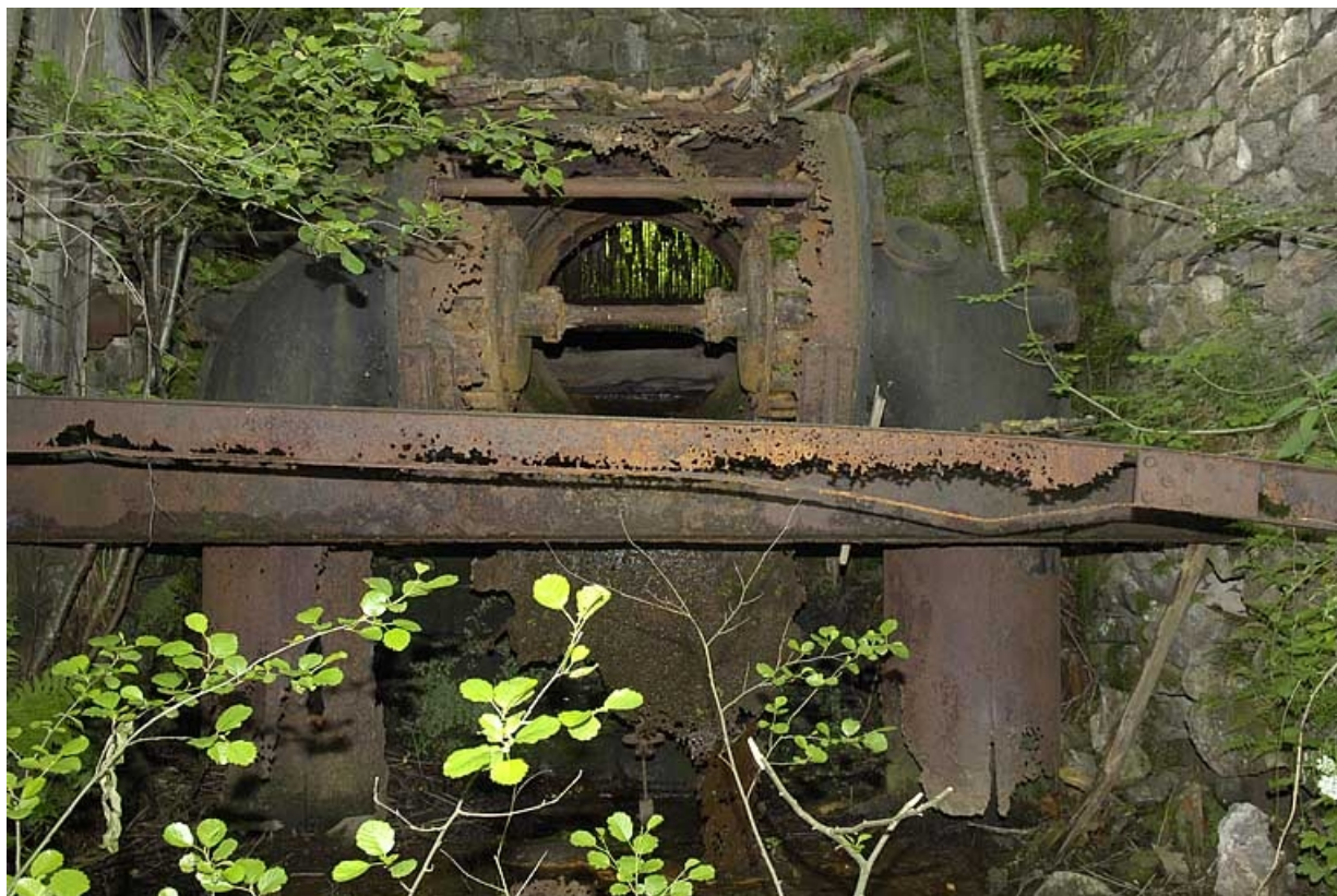
Turbine hydraulique à axe horizontal. Vue rapprochée. 70, Corravillers R.D. 6
