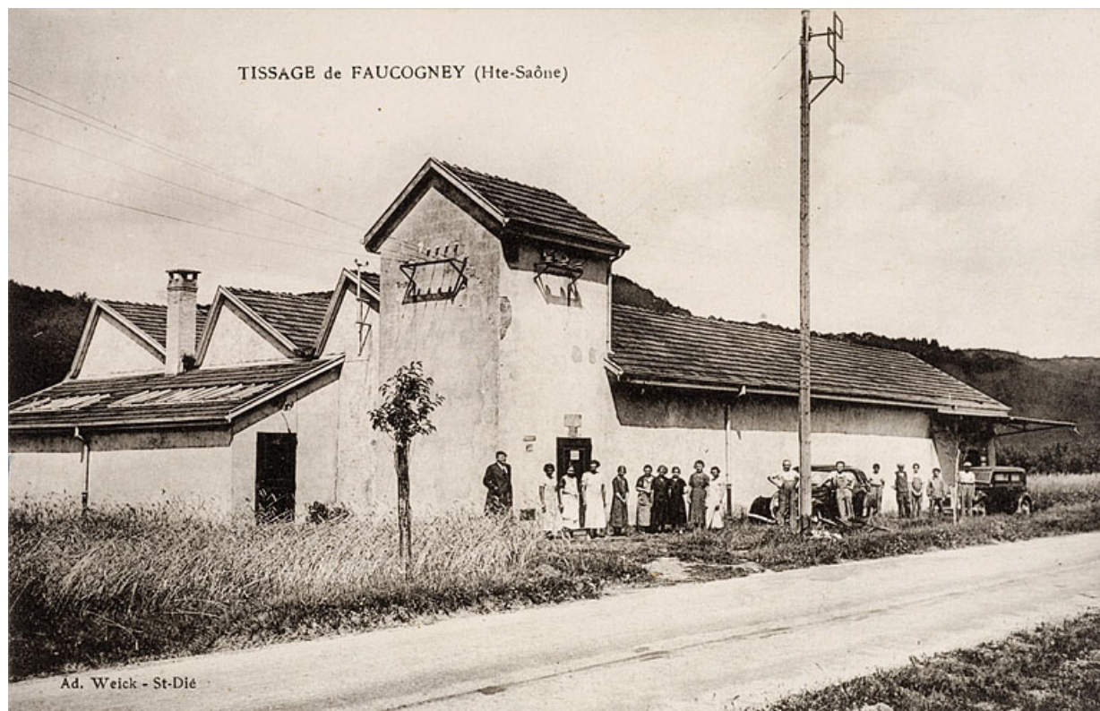
Tissage d'Amage [improprement légendé : Tissage de Fauconney] : vue d'ensemble depuis le sud-ouest. 70, Amage R.D. 6
