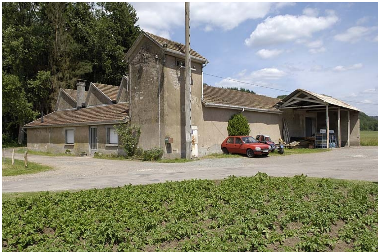
Vue d'ensemble depuis l'ouest. 70, Amage R.D. 6
