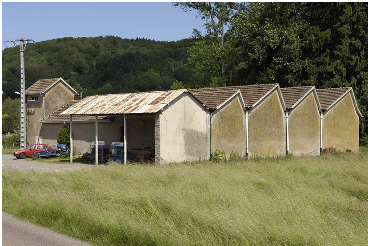
Vue d'ensemble depuis le sud-est. 70, Amage R.D. 6
