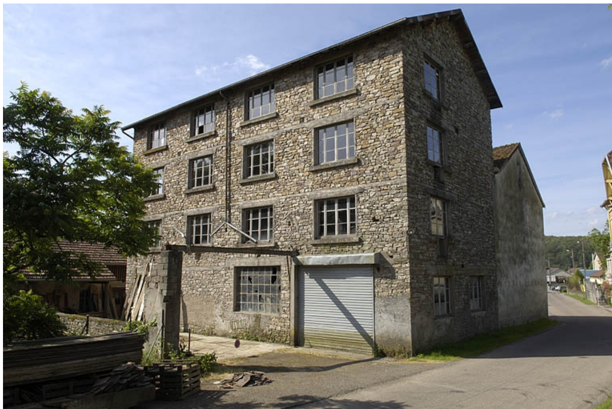
Extension orientale de l'atelier de fabrication.
