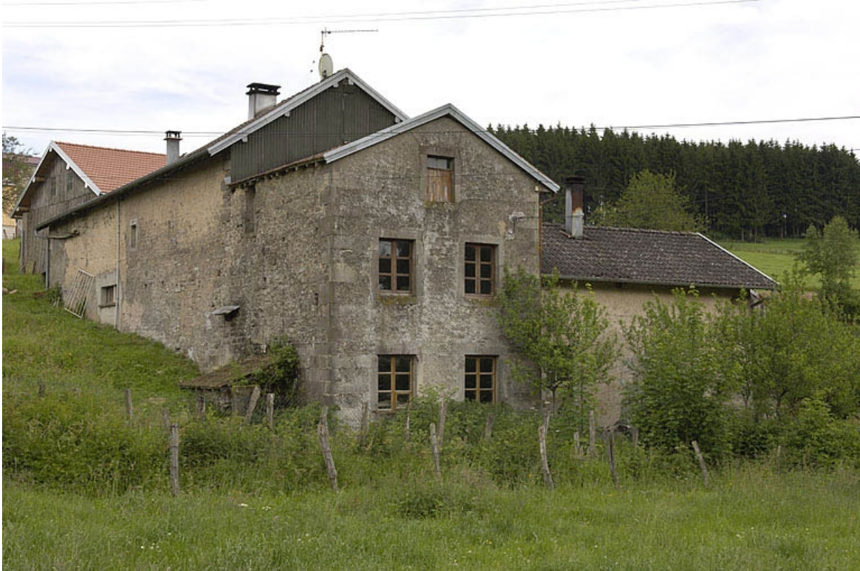
Atelier de fabrication du moulin vu depuis l'ouest.
