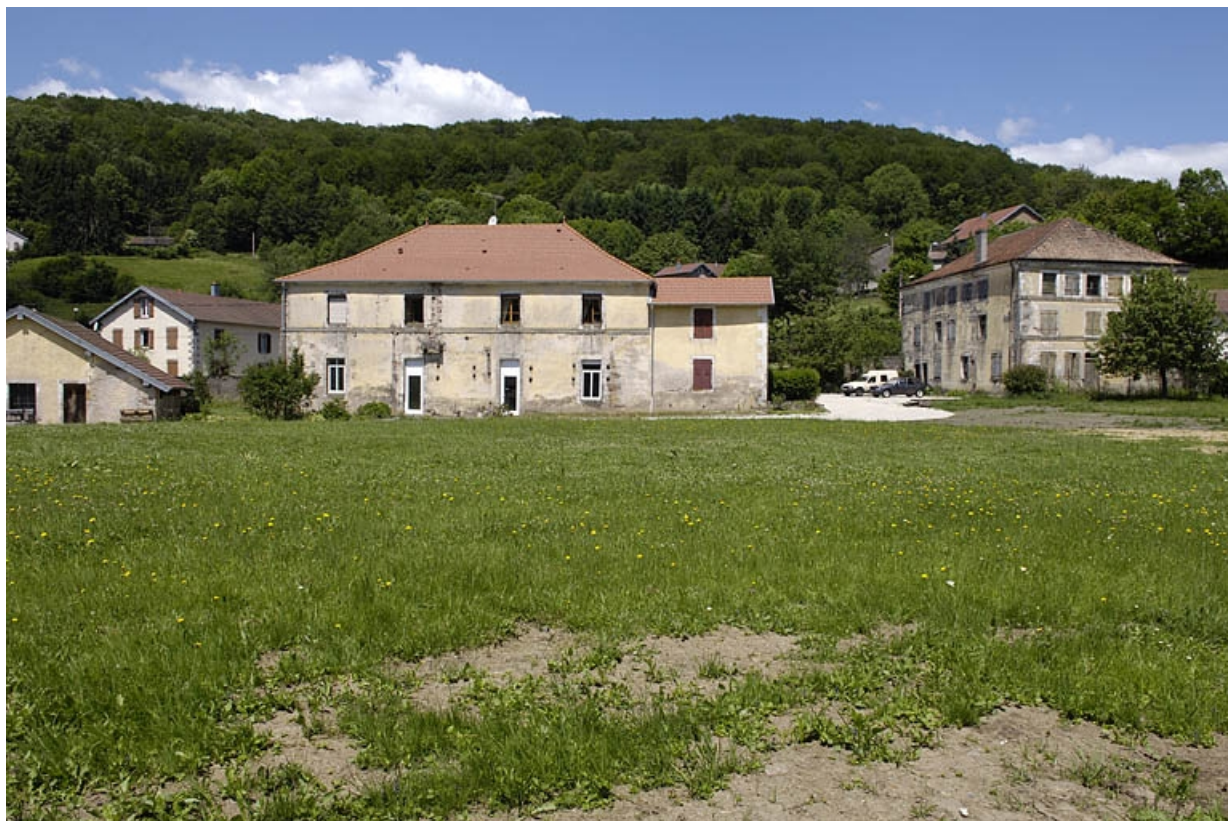
Vue des bâtiments de la papeterie depuis le sud.
