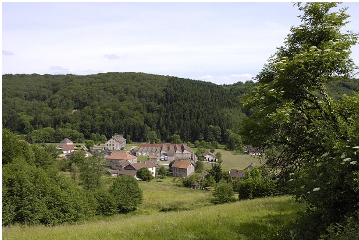
Vue générale plongeante depuis le nord-ouest.
