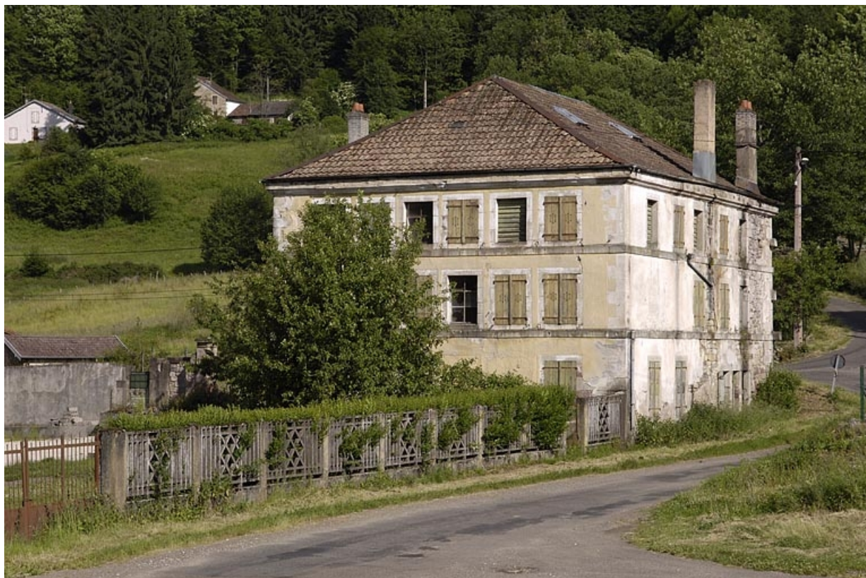
Ancien logement ouvrier vu depuis le sud-est.
