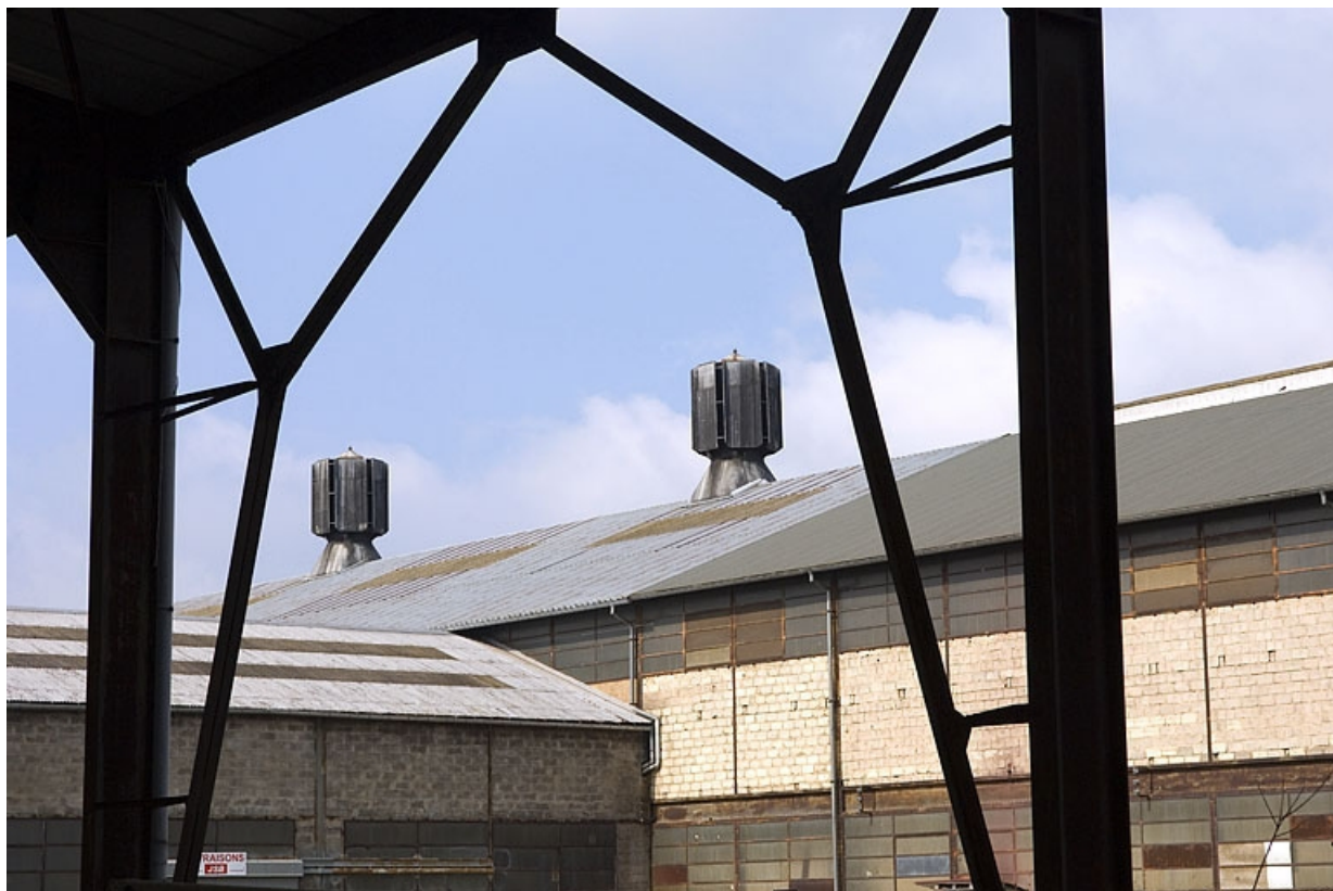
Atelier de fabrication. Cheminées d'extraction.
