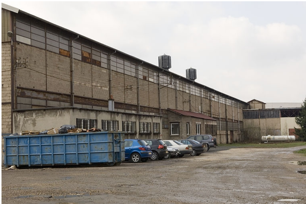
Façade nord de l'atelier de fabrication.
