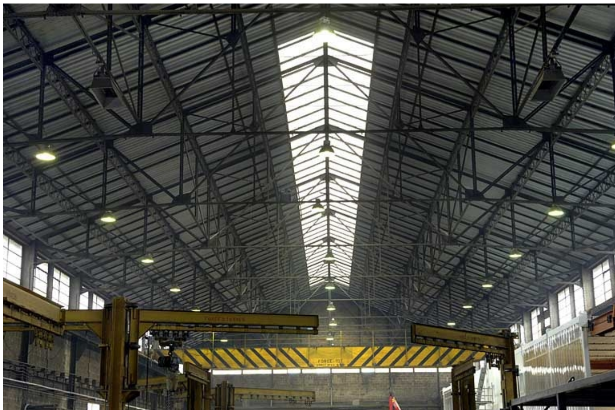
Atelier de fabrication. Charpente et couverture métallique.
