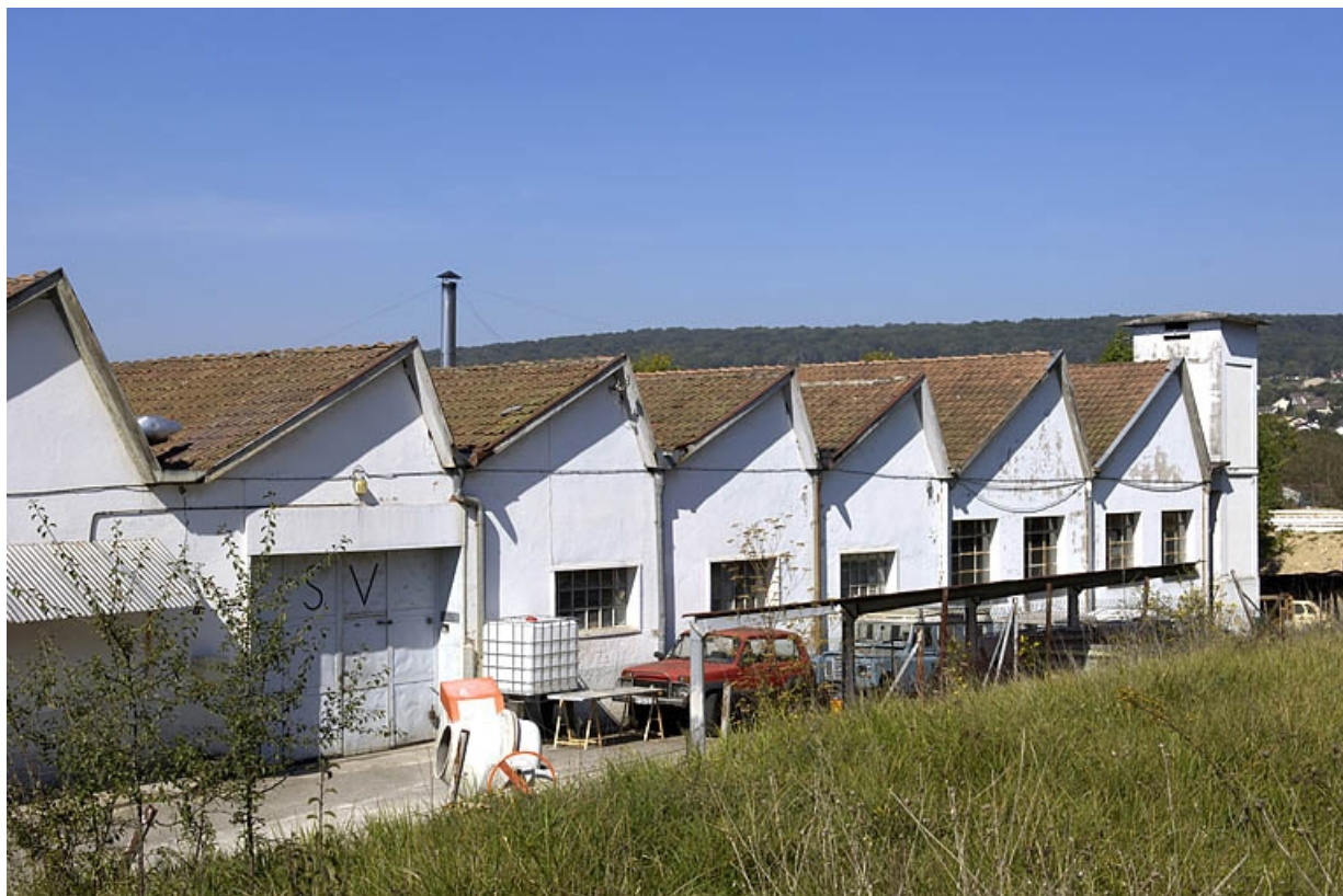
Murs pignons est de l'atelier de fabrication. 70, Héricourt rue Marcel Paul
