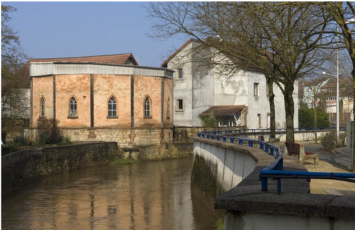
Vue d'ensemble en aval de la Lizaine.
