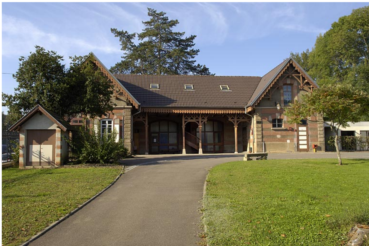
Façade nord de l'ancienne écurie (?). 70, Héricourt, 2 faubourg de Besançon
