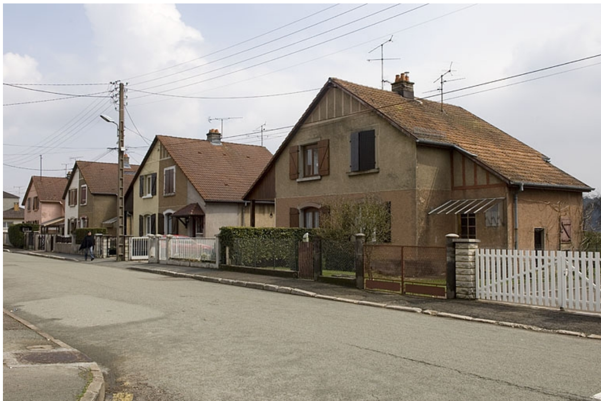
Alignement de quatre maisons (côté pair). 70, Héricourt rue Bel Air
