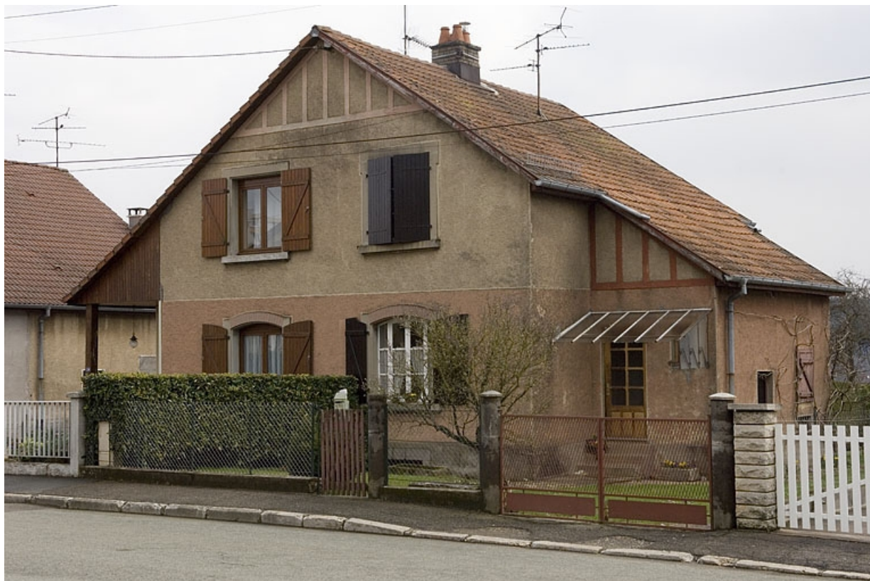
Vue de trois quarts d'une maison à deux logements.
