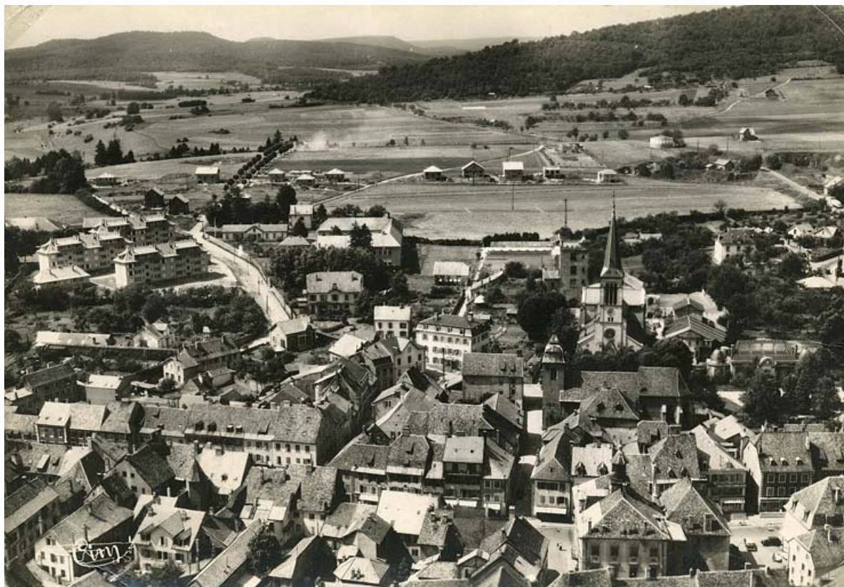
La cité ouvrière en construction (au second plan).
