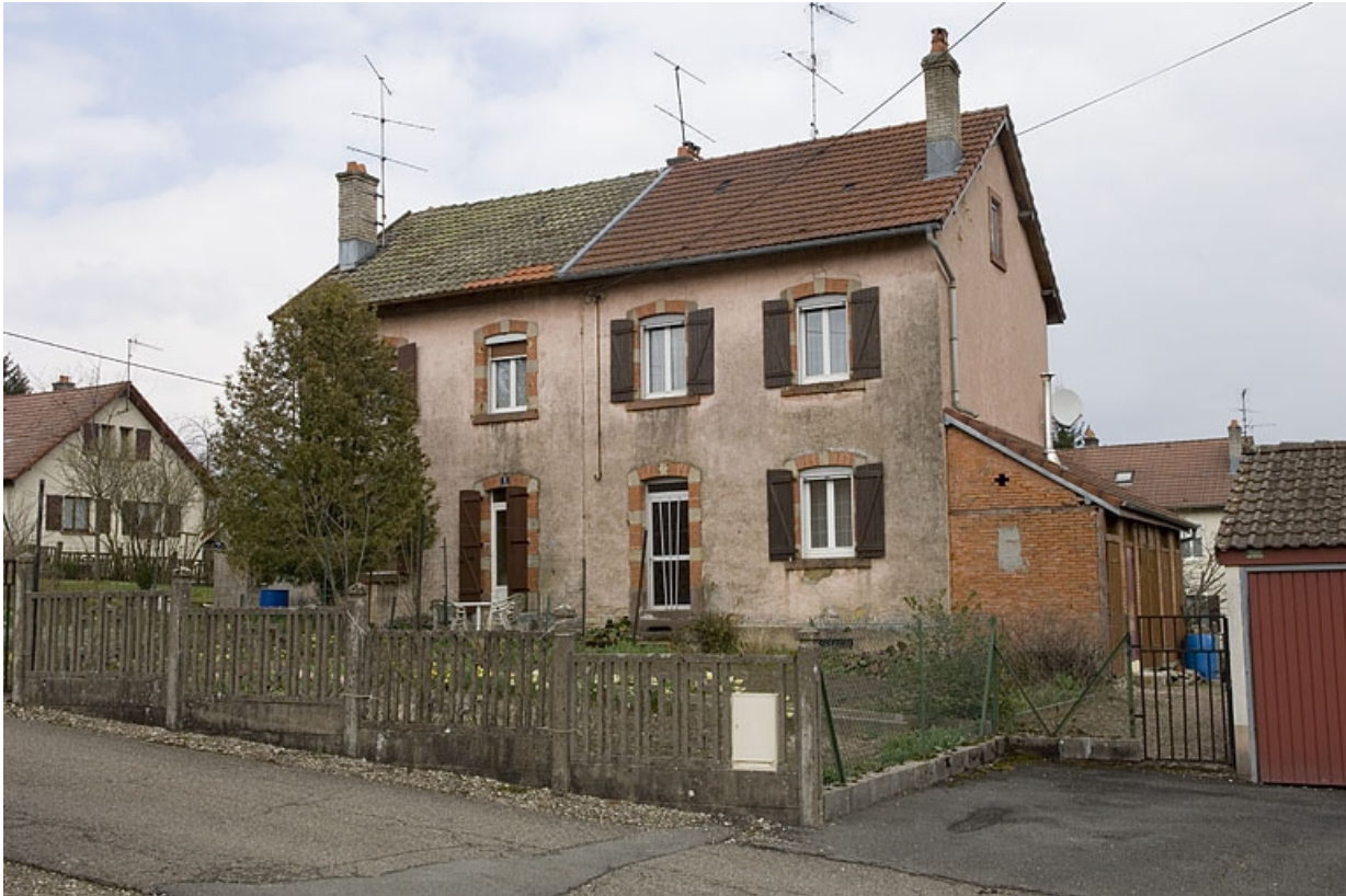
Maison ouvrière à quatre logements rue de Thann. 62, Héricourt rue des Cités Dollfus
