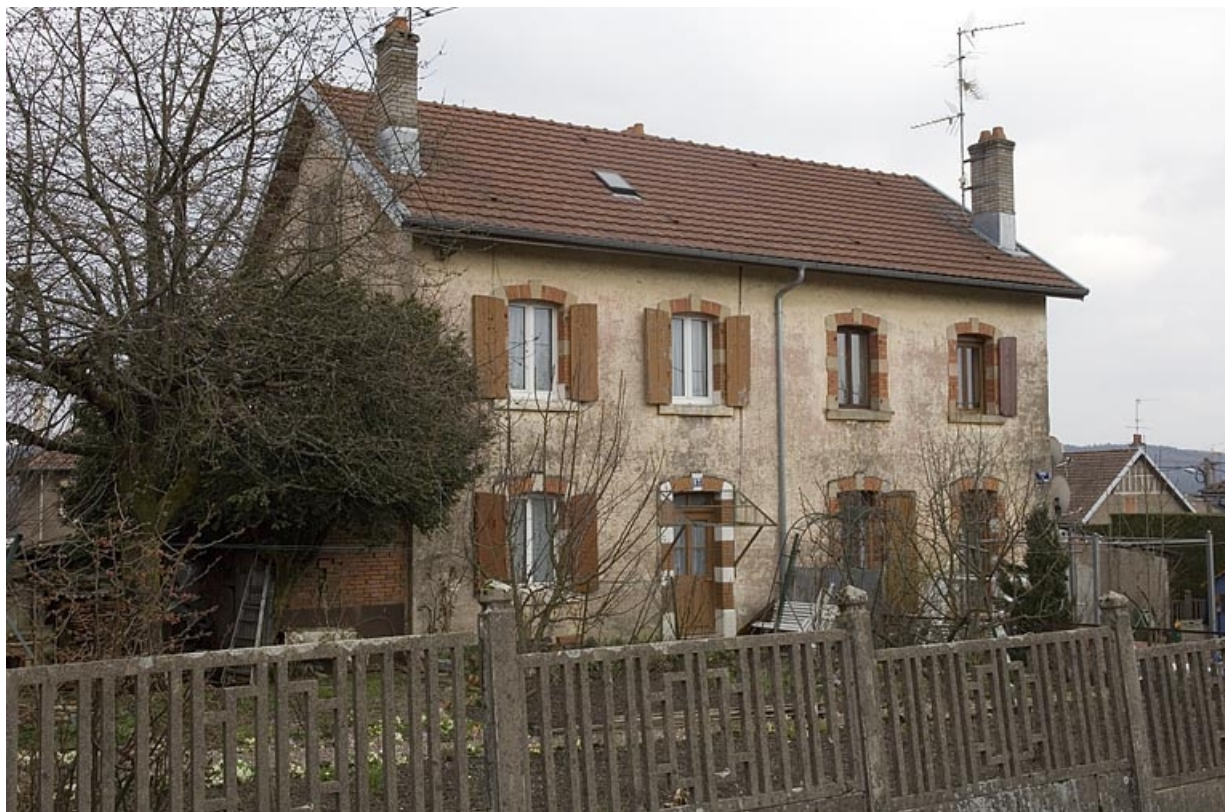
Maison ouvrière à quatre logements (côté rue de Strasbourg).
