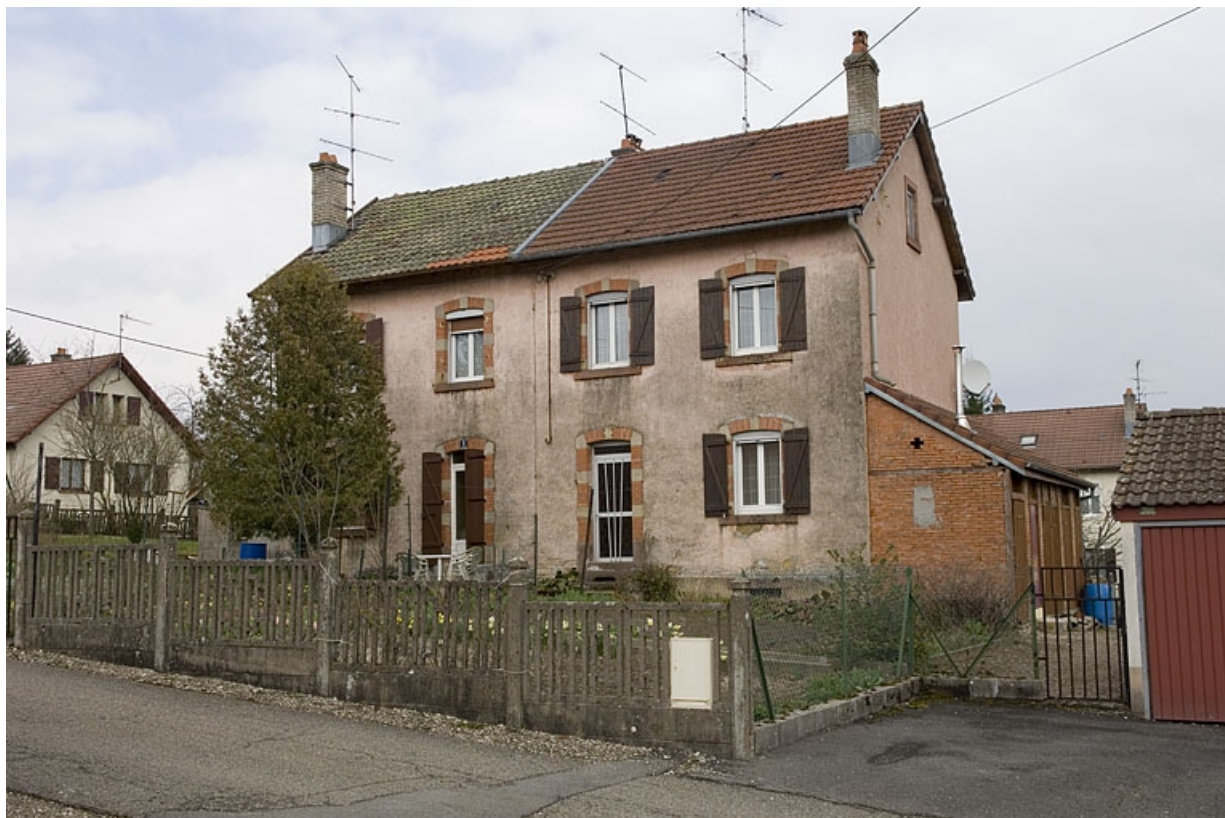
Maison ouvrière à quatre logements rue de Thann.
