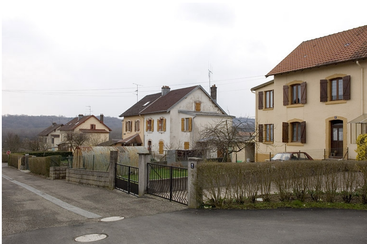
Maisons ouvrières rue de Wissembourg (côté pair). 70, Héricourt rue des Cités Dollfus
