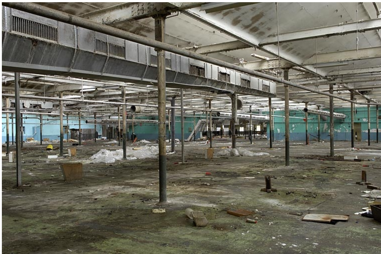
Extension est de la salle de tissage. Vue depuis l'est.
