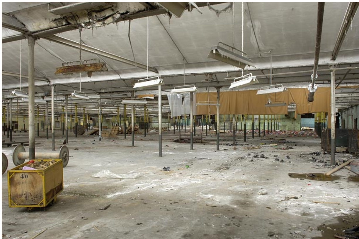
Salle de tissage. Vue d'ensemble depuis l'entrée.
