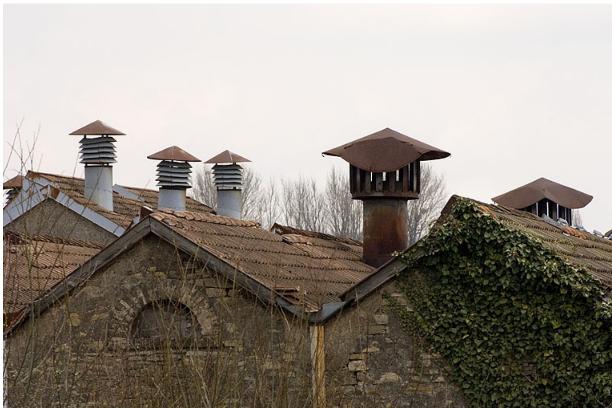
Cheminées métalliques de la salle de tissage.
