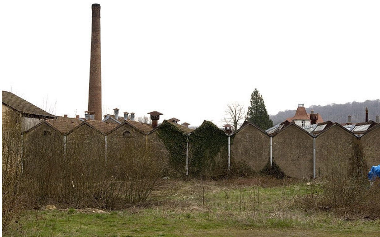
Cheminée et murs-pignons de la salle de tissage.
