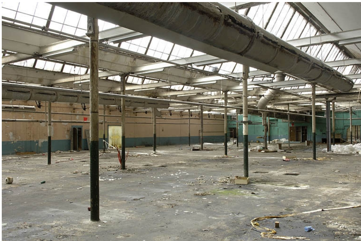
Extension est de la salle de tissage. Détail des structures.
