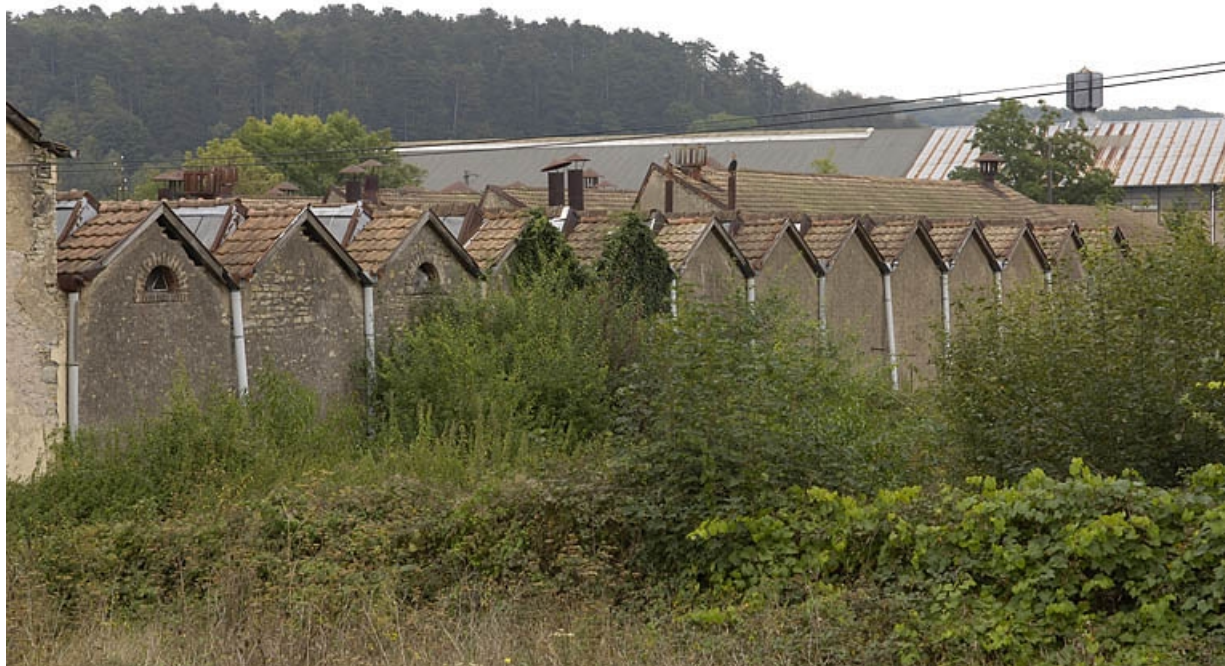
Murs-pignons sud de la salle de tissage.
