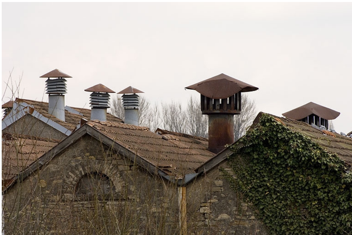
Cheminées métalliques de la salle de tissage.
