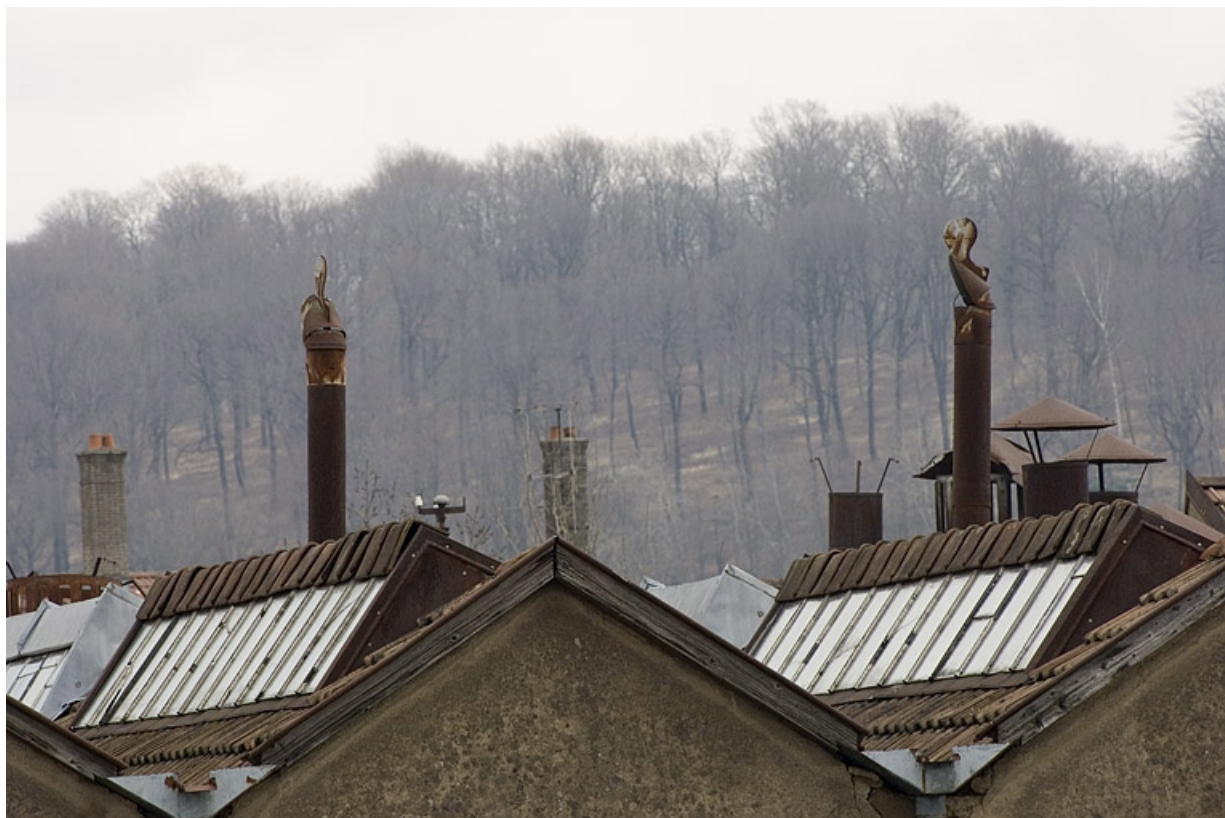
Détail des toitures et des cheminées métalliques.
