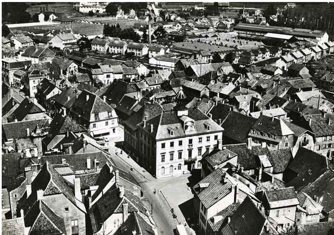
Vue aérienne depuis le nord-ouest.
