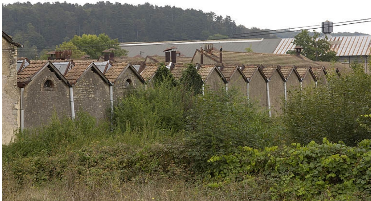
Murs-pignons sud de la salle de tissage.
