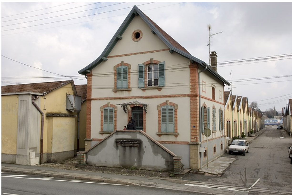
Logement et pignons des sheds sur la rue Marcel Bardot.
