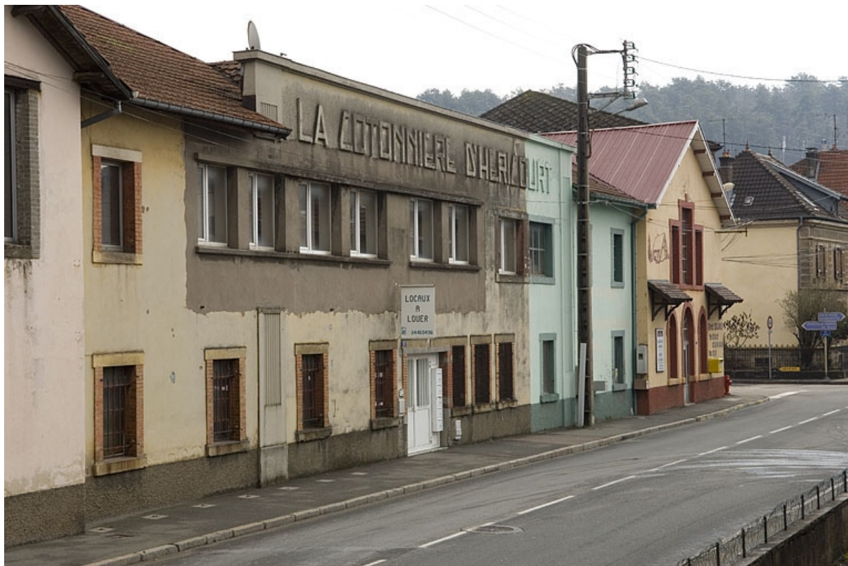
Façades sur l'avenue Jean Jaurès. Détail du frontispice La Cotonnière d'Héricourt. 70, Héricourt rue Marcel Bardot
