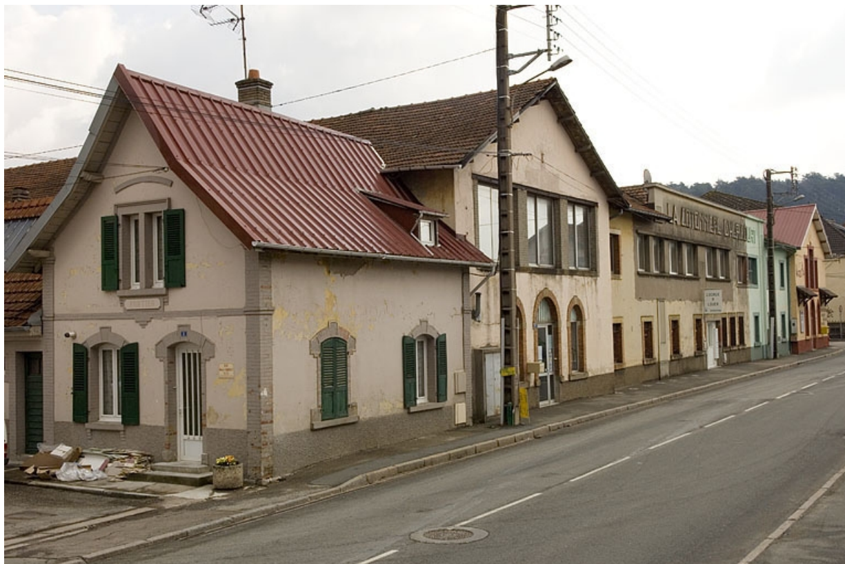
Façades sur l'avenue Jean Jaurès.
