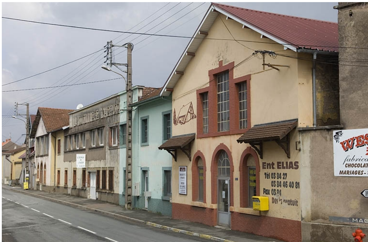
Façades sur l'avenue Jean Jaurès depuis le sud.
