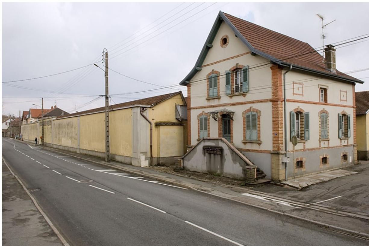
Alignement sur l'avenue Jean Jaurès de l'atelier de tissage et du logement d'entrée. 70, Héricourt rue Marcel Bardot
