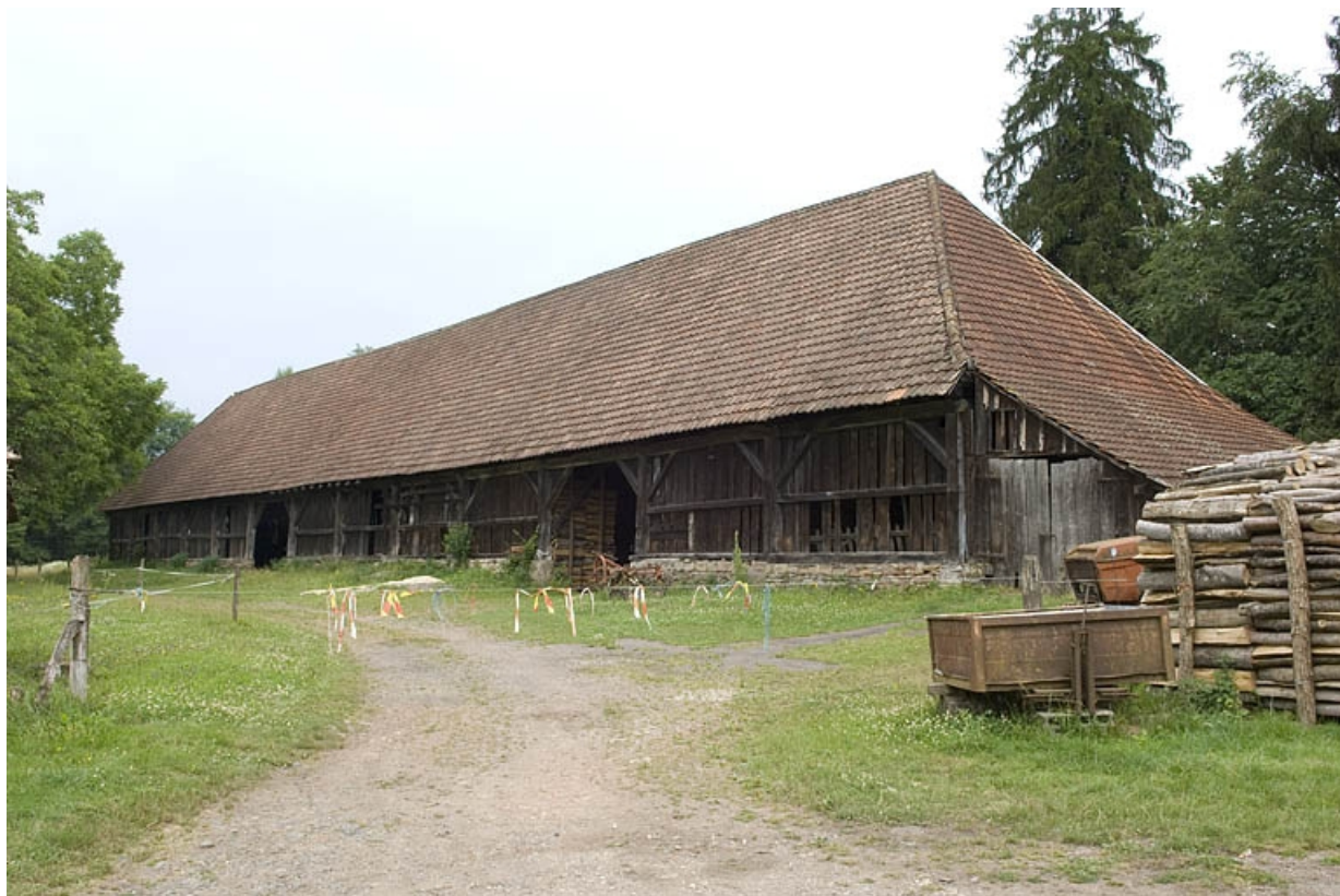
Vue de trois quarts de la halle à charbon.
