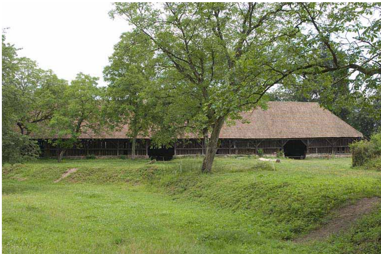
La halle à charbon vue depuis le sud-ouest.
