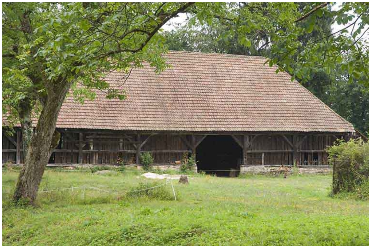
Halle à charbon. Vue rapprochée de la façade ouest.
