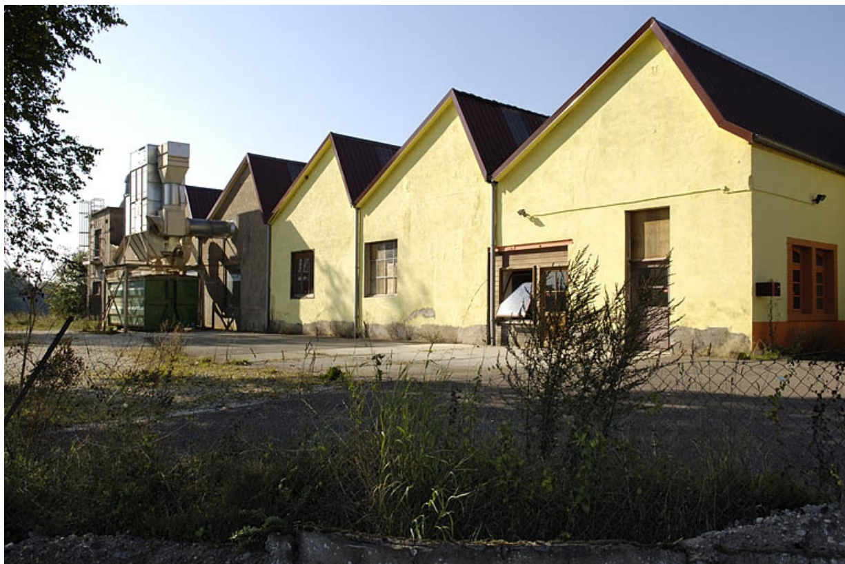
Pignons des sheds depuis l'est.
