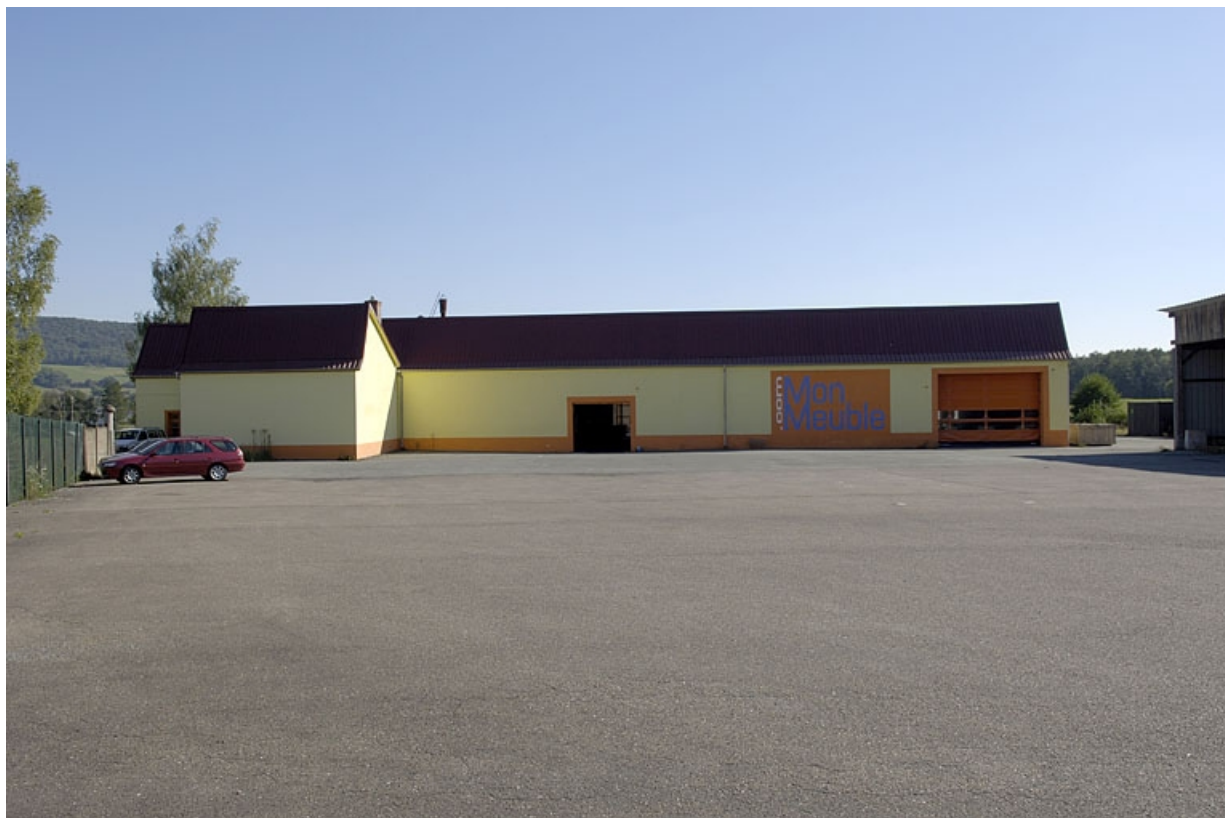
Vue d'ensemble depuis l'entrée.
