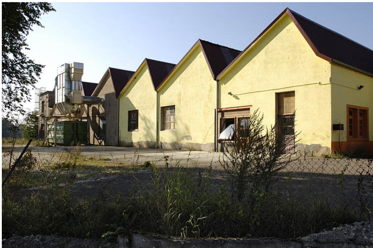
Pignons des sheds depuis l'est.
