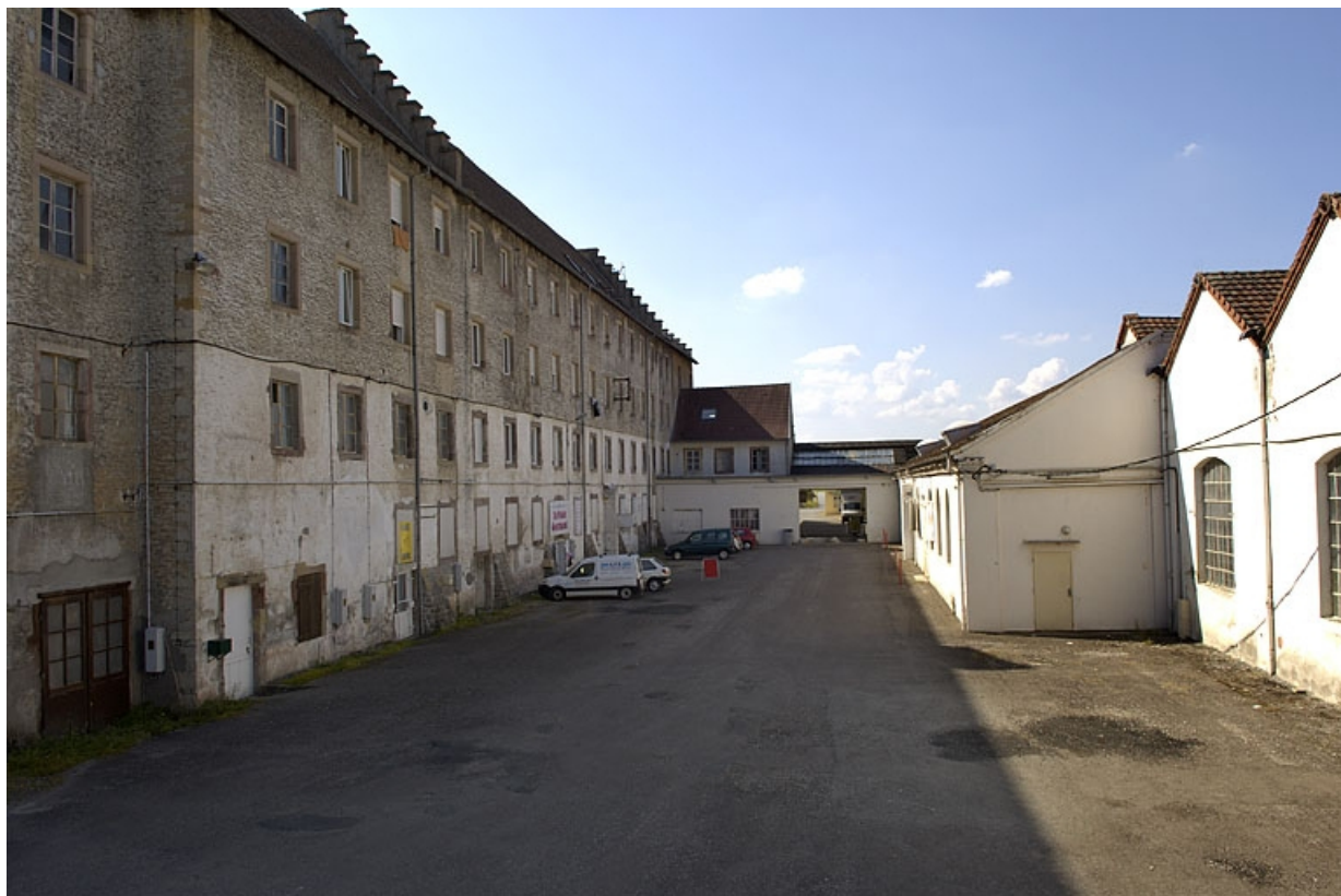
La cour entre l'atelier de fabrication à étages et l'atelier de bobinage. 70, Couthenans, lieudit : Chevret
