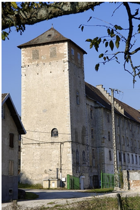
Tour de séchage à l'extrémité ouest de l'atelier de fabrication à étages.
