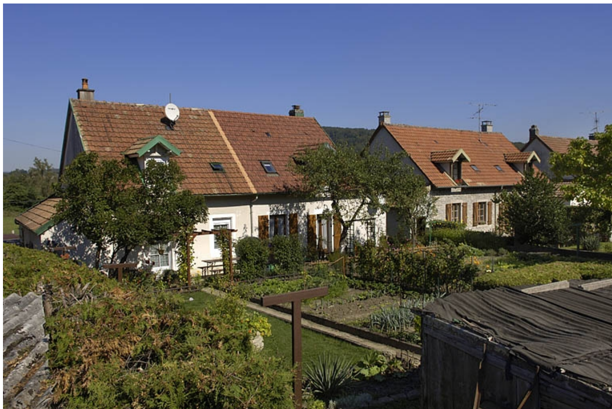
Façade sur jardin des maisons de la cité ouvrière.
