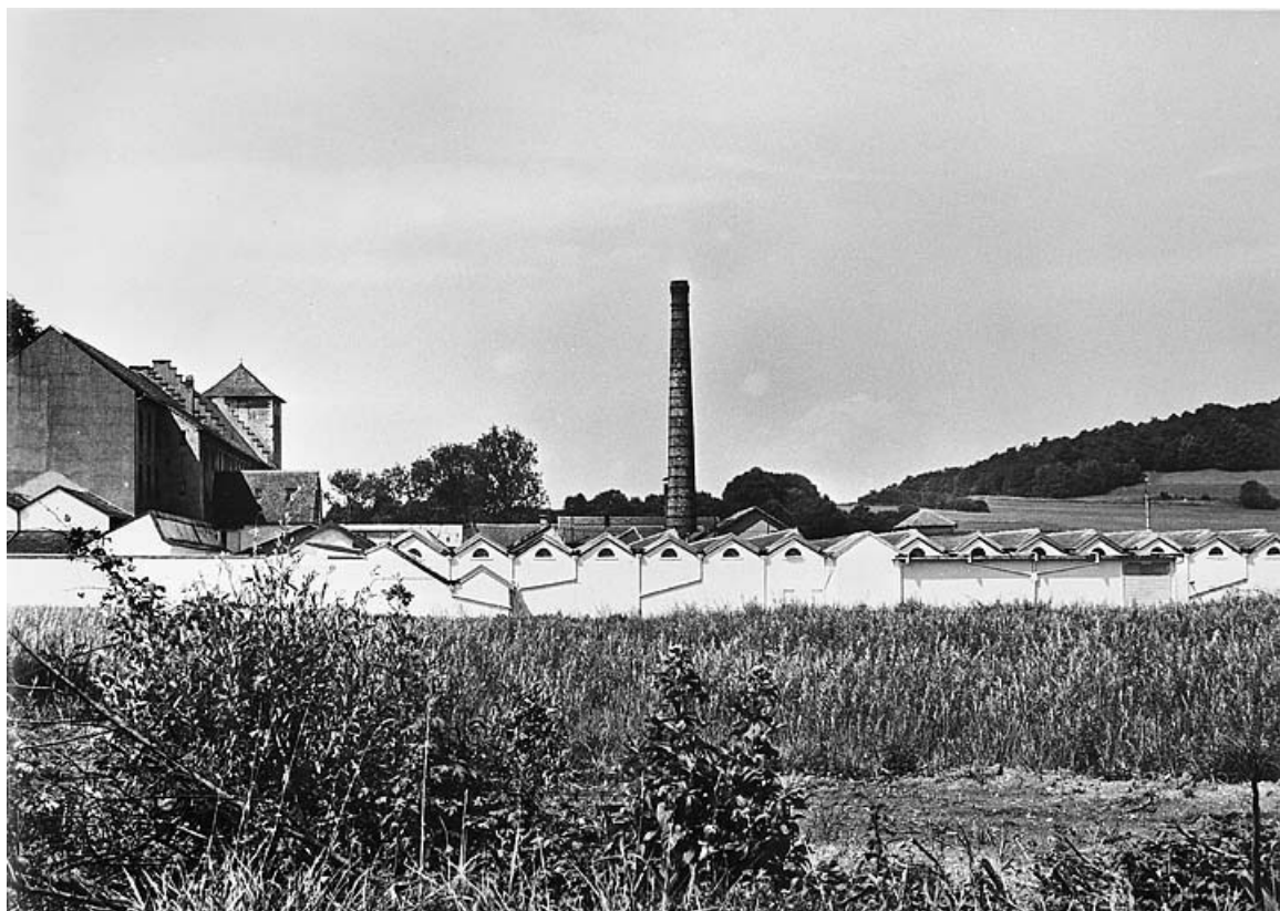
Vue d'ensemble depuis l'ouest.
