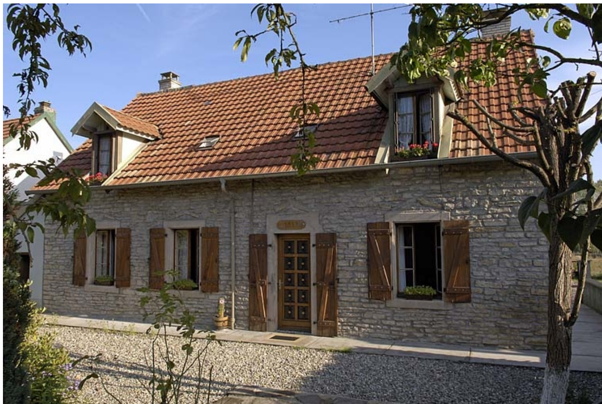
Façade postérieure d'un logement ouvrier.
