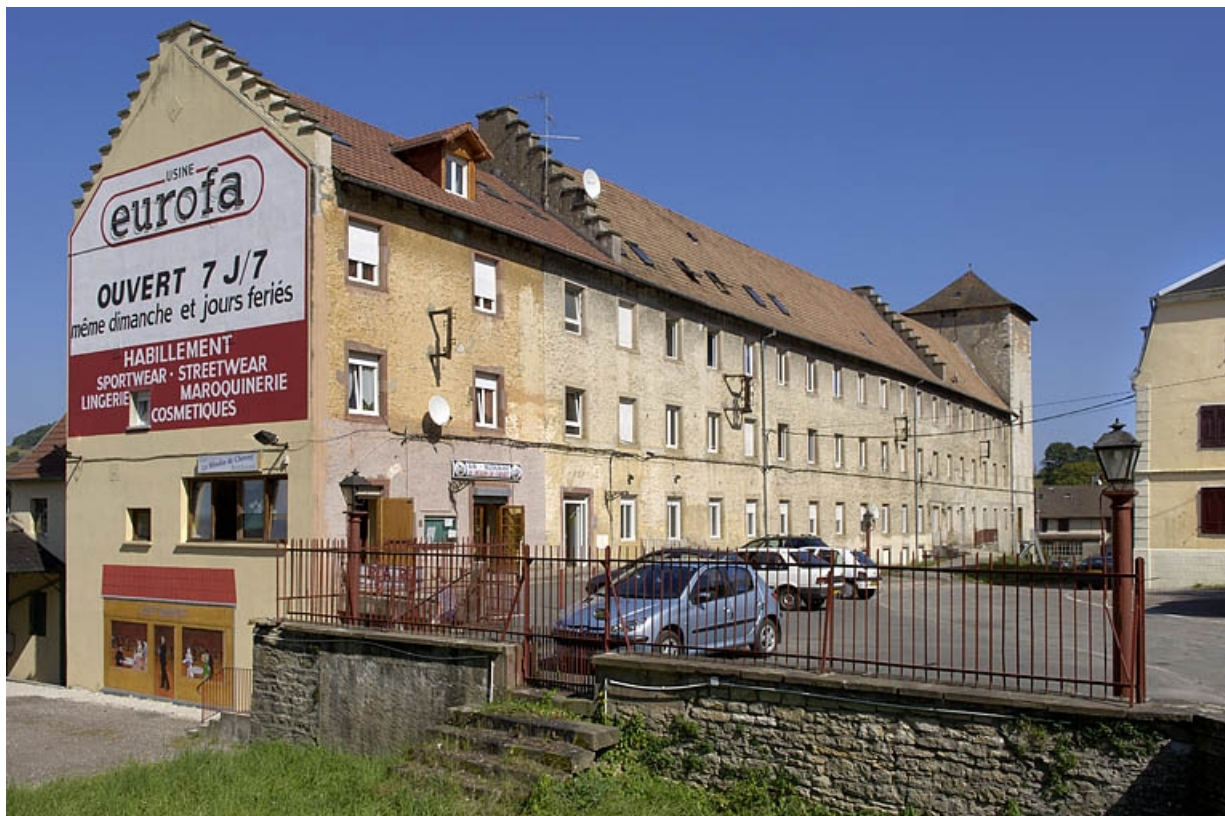
Façade sud de l'atelier de fabrication à étages.
