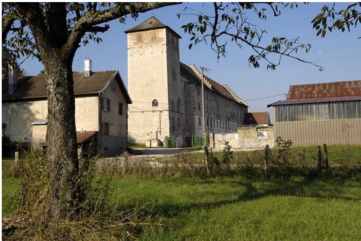
Atelier de fabrication à étages de la filature depuis l'est.
