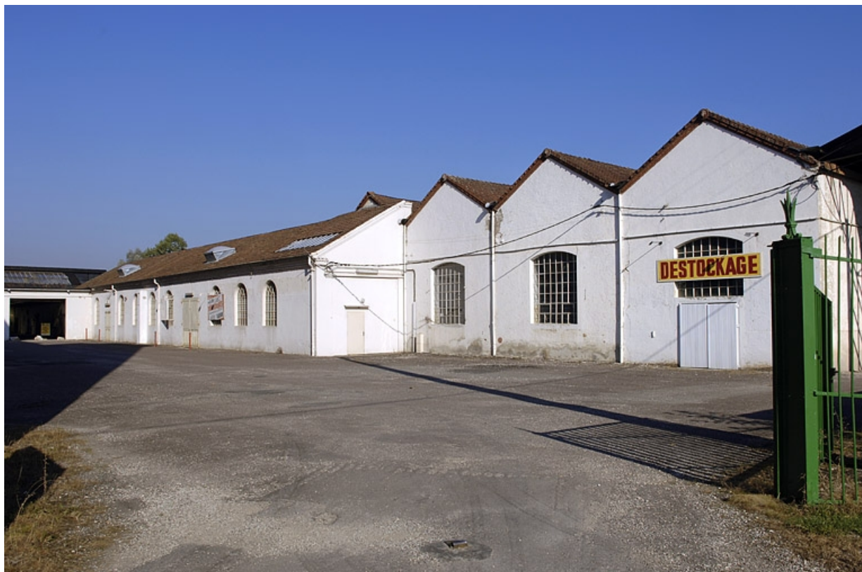
Façades sud de l'atelier de bobinage.
