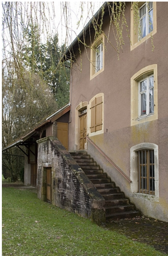
Façade antérieure. Escalier d'accès au logement.
