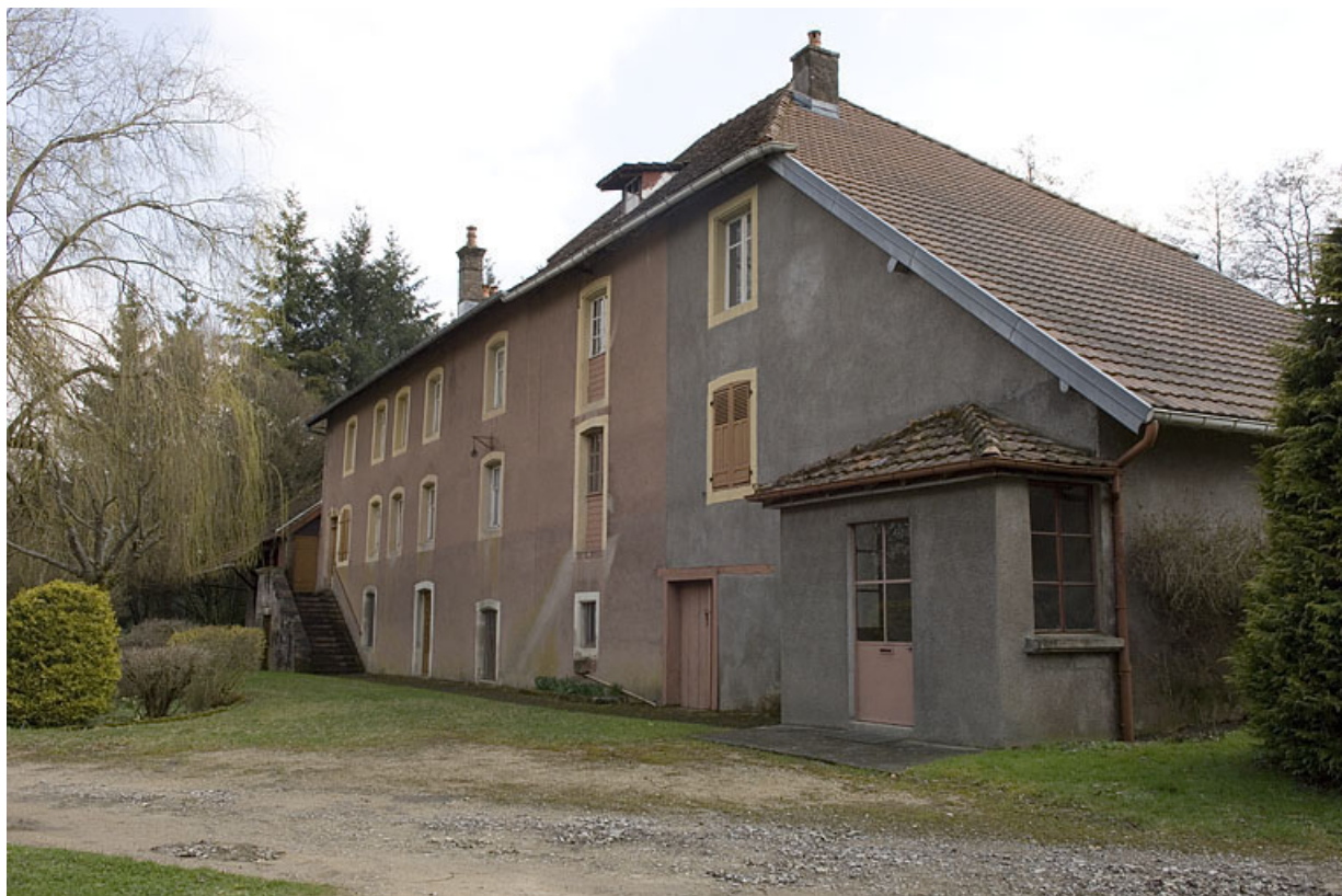
Façade antérieure depuis l'ouest.
