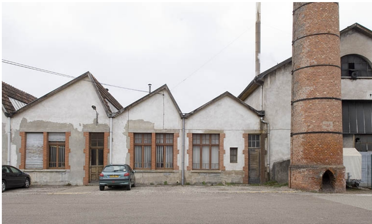
Façade est : bureaux, cheminée et chaufferie.
