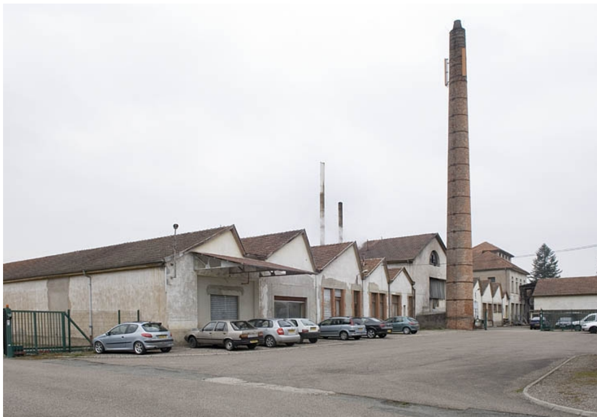
Vue de trois quarts depuis la cour.
