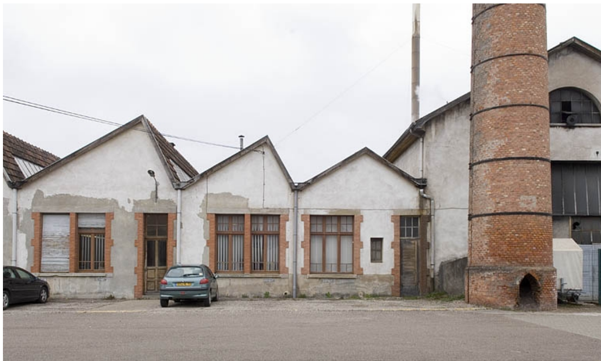
Façade est : bureaux, cheminée et chaufferie.
