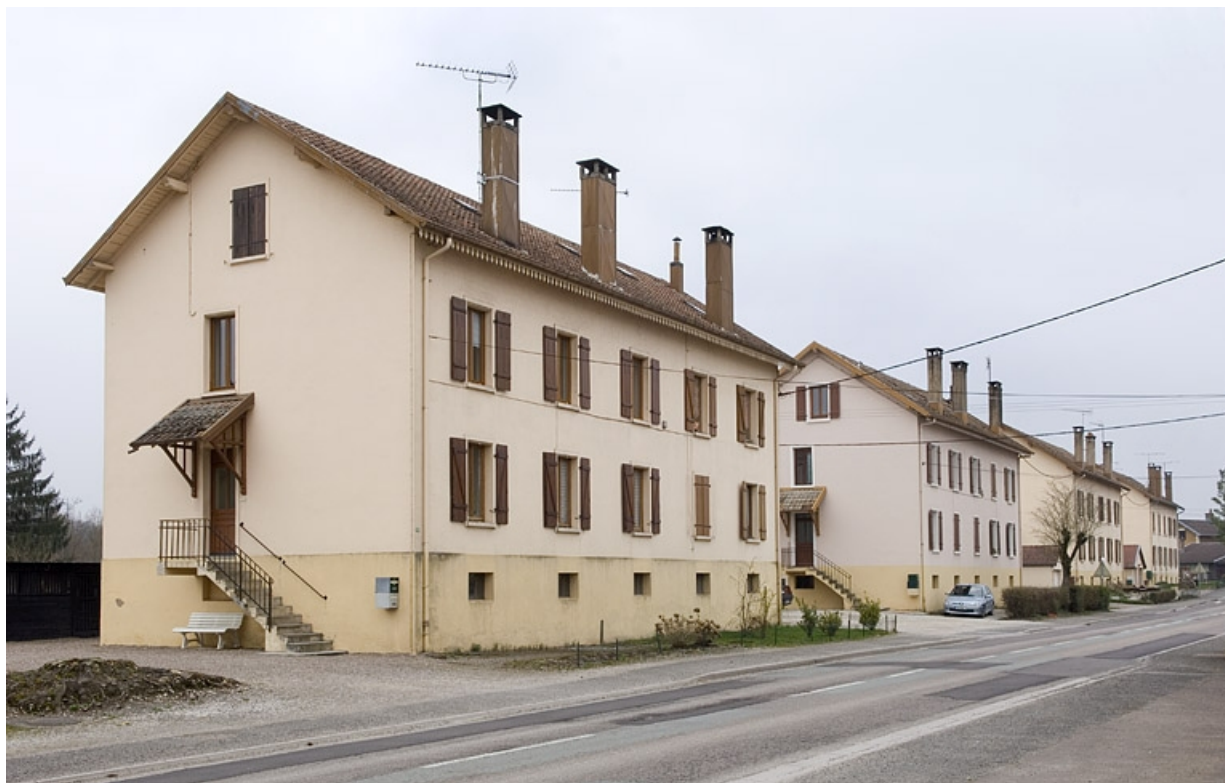
La cité ouvrière vue depuis la rue.
