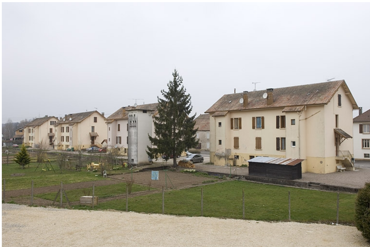
Vue d'ensemble de la cité ouvrière depuis le sud-est.
