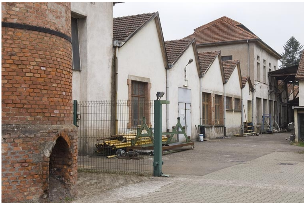
Pignons des sheds de l'atelier. 70, Villersexel, 199 rue des Vosges
