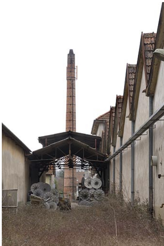
La cheminée vue depuis le nord. 70, Villersexel, 199 rue des Vosges
