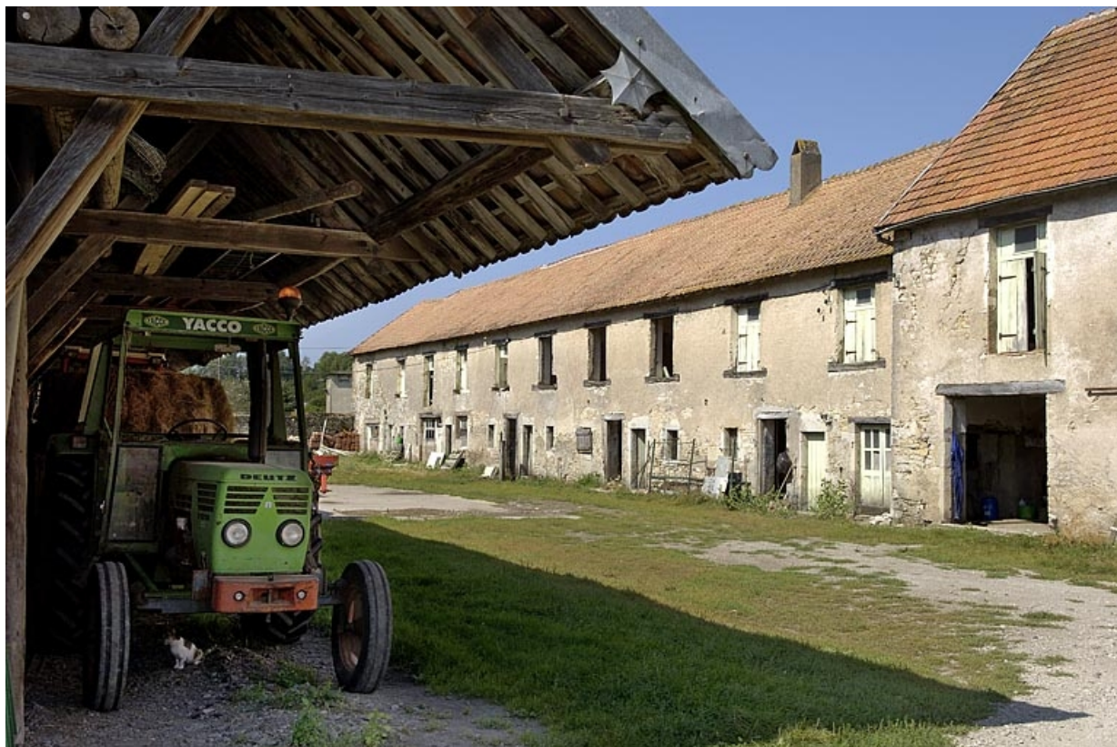
Aile ouest des logements ouvriers.
