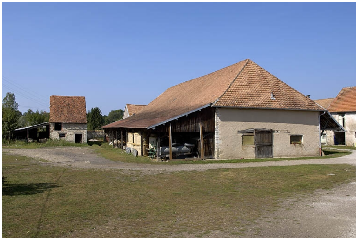
Vue depuis le sud-ouest de la cour.
