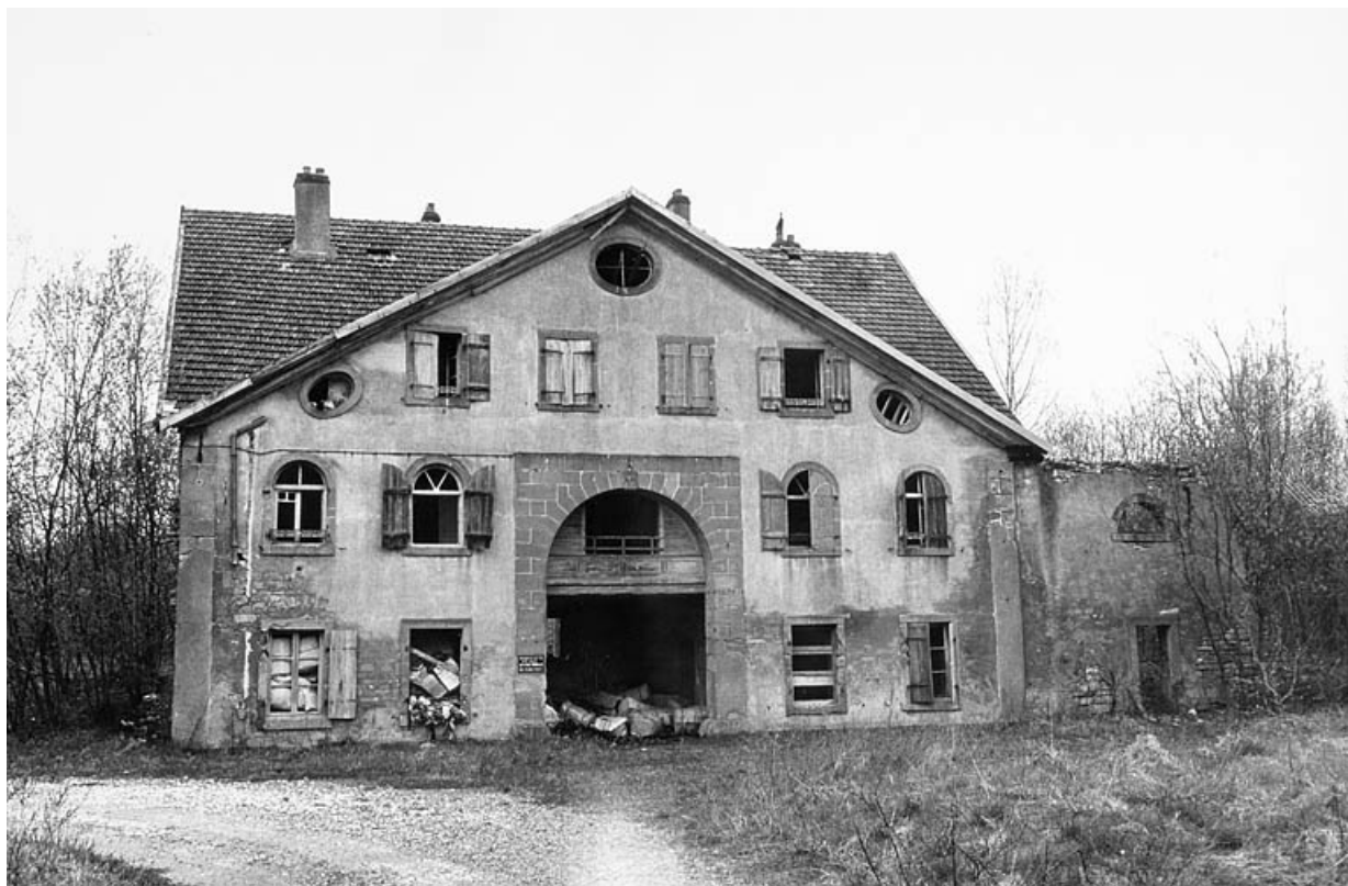
Bâtiment d'entrée ouest en 1977. Façade antérieure.
