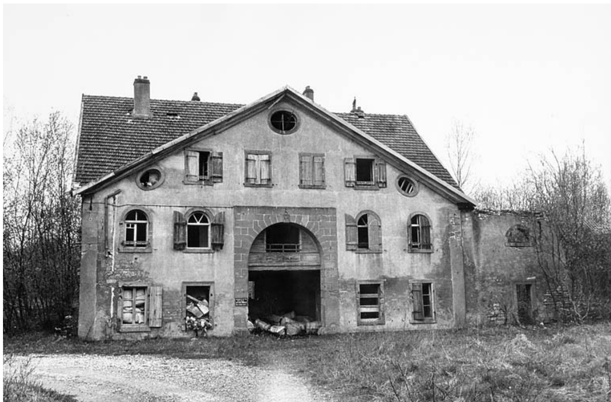
Bâtiment d'entrée ouest en 1977. Façade antérieure.
