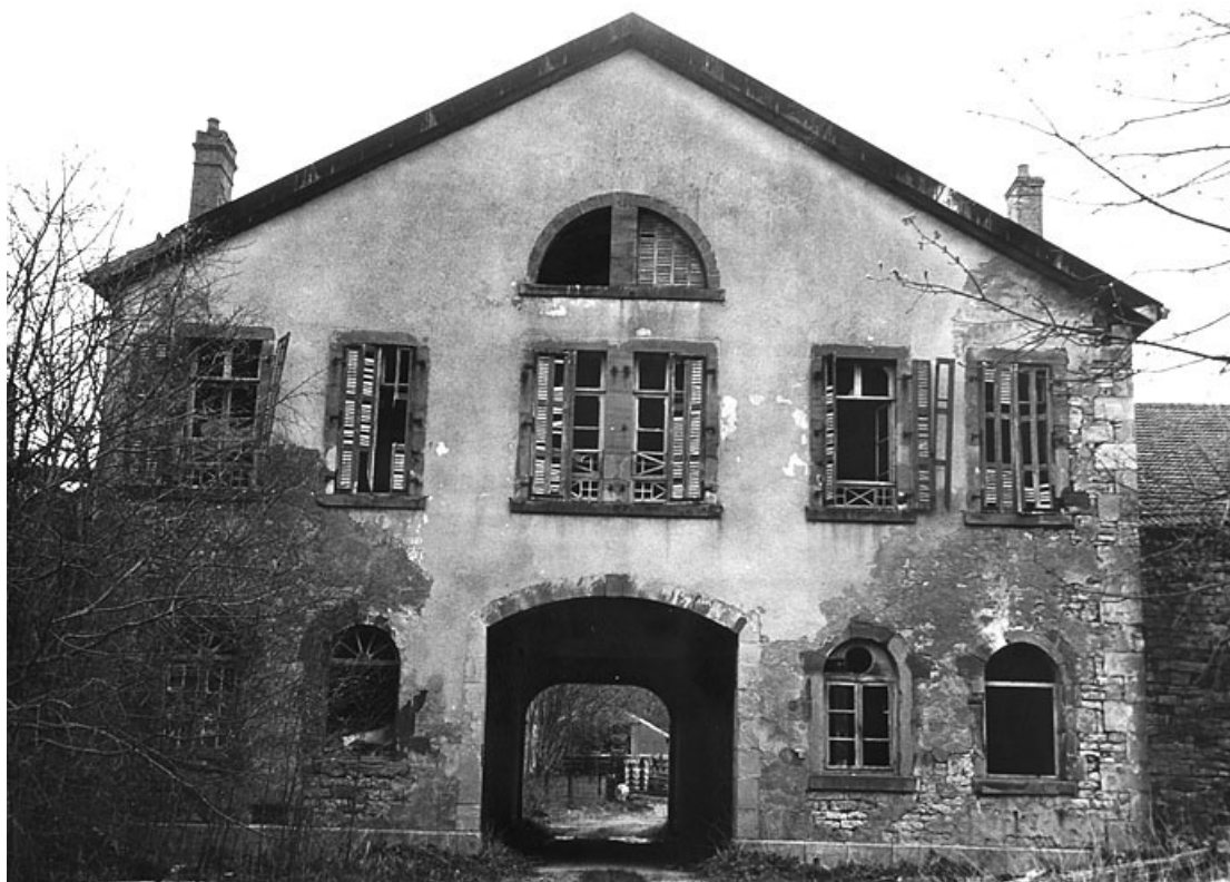
Bureau de la Régie en 1977. Façade antérieure.
