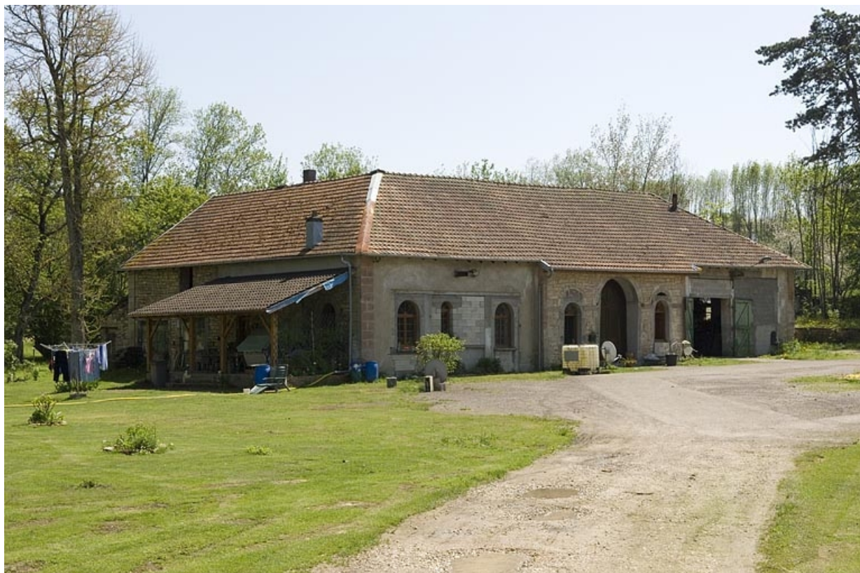
Bâtiment à usage multiple (logements, remises, écuries et ateliers divers). 70, Gouhenans R.D. 92, lieudit : la Saline
