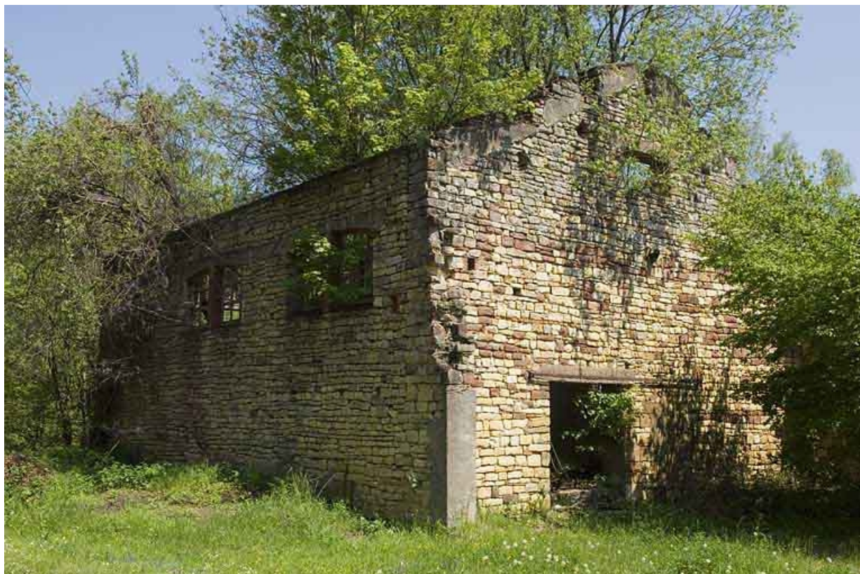
Atelier en ruines de l'usine de produits chimiques.
