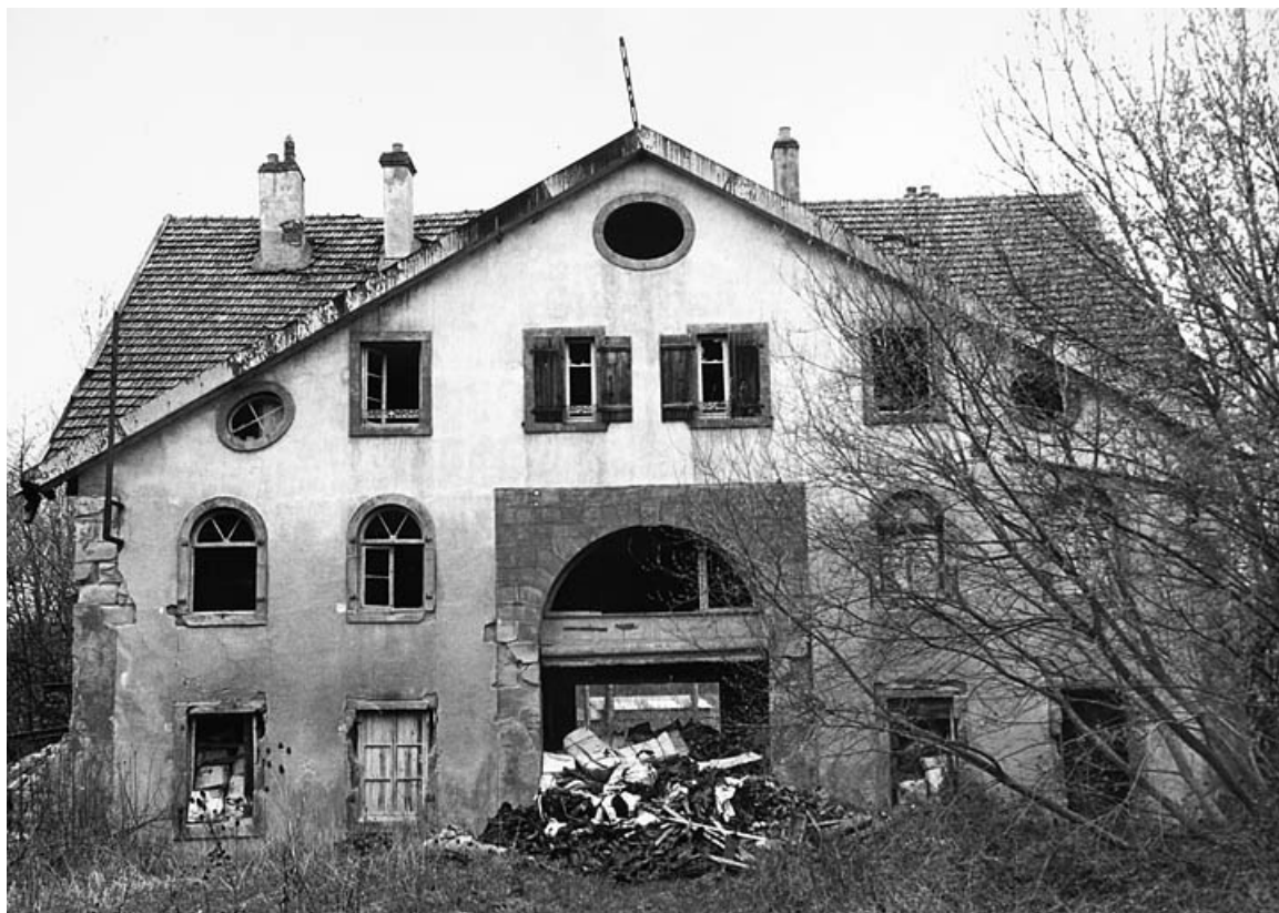
Bâtiment d'entrée ouest en 1977. Façade postérieure.
