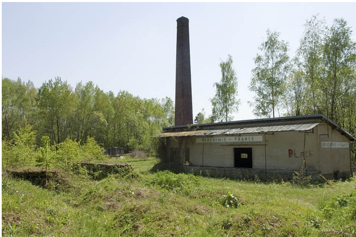
Emplacement de l'ancienne saline.
