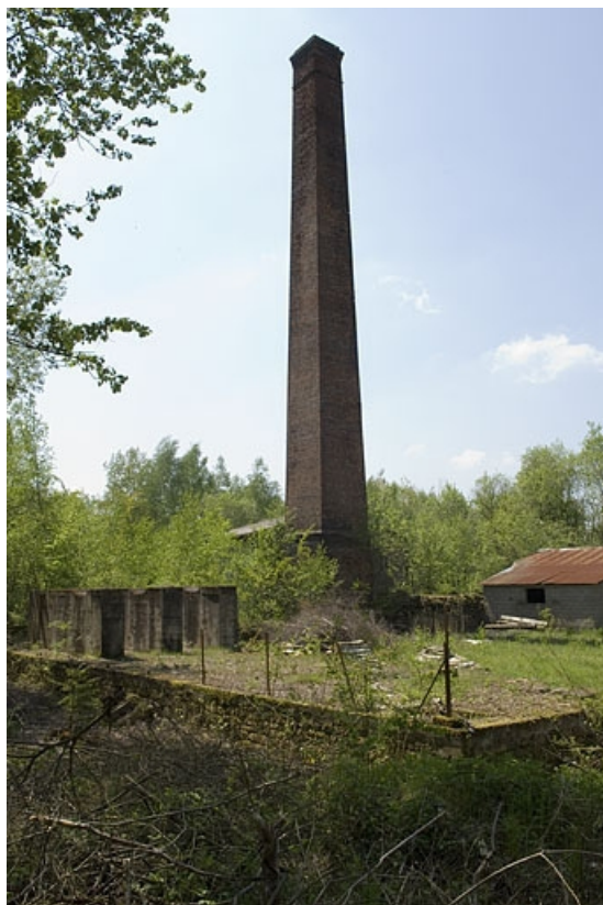
La cheminée vue depuis le nord-est.
