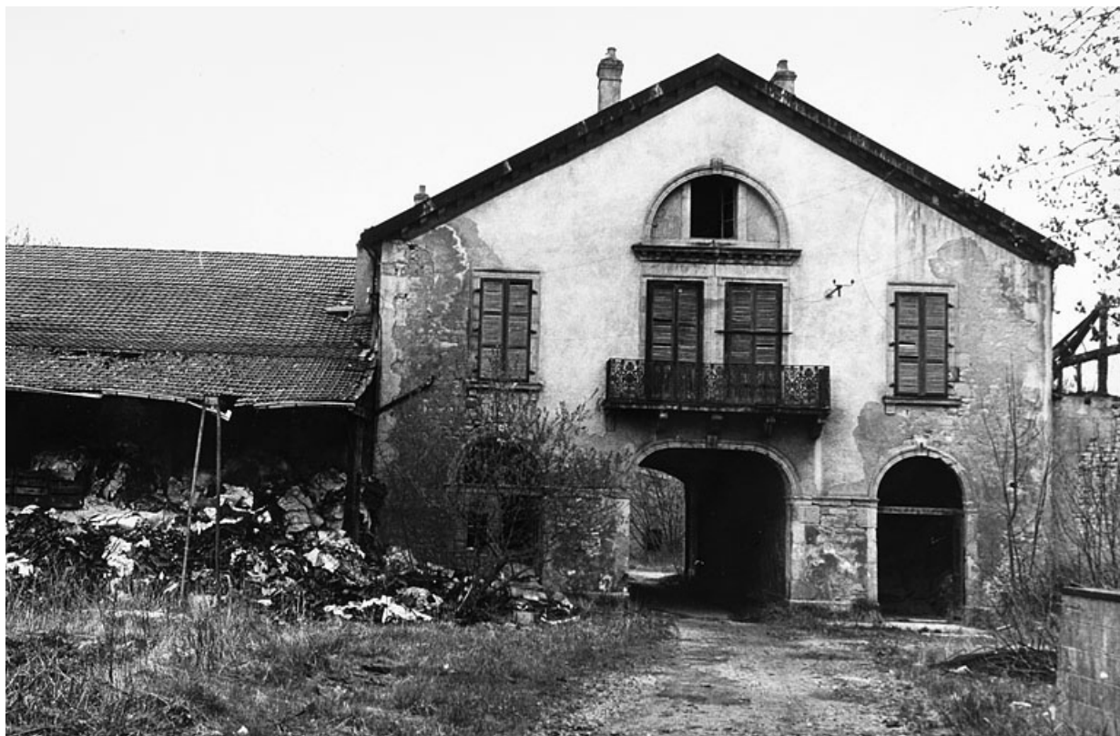
Bureau de la Régie en 1977. Façade postérieure.
