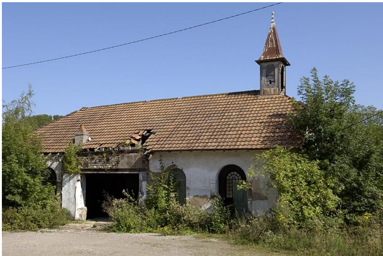
Salle des machines et atelier de réparation. 70, Fallon R.D. 90
