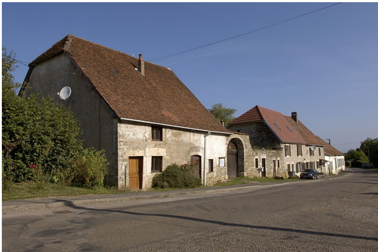
Logements ouvriers vus depuis le sud-est. 70, Fallon R.D. 90
