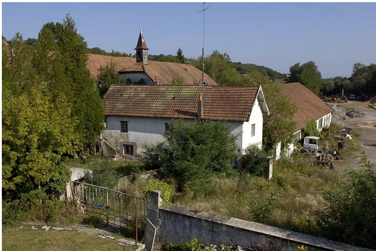
Vue d'ensemble depuis le sud. 70, Fallon R.D. 90
