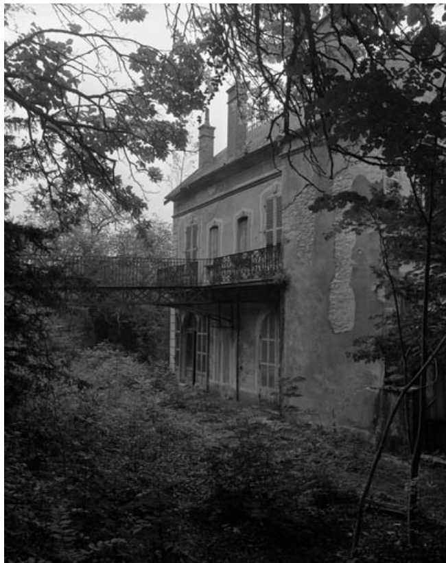
Vue de l'élévation postérieure et de la passerelle conduisant au jardin. 70, Arc-lès-Gray, 50 rue de Dijon
