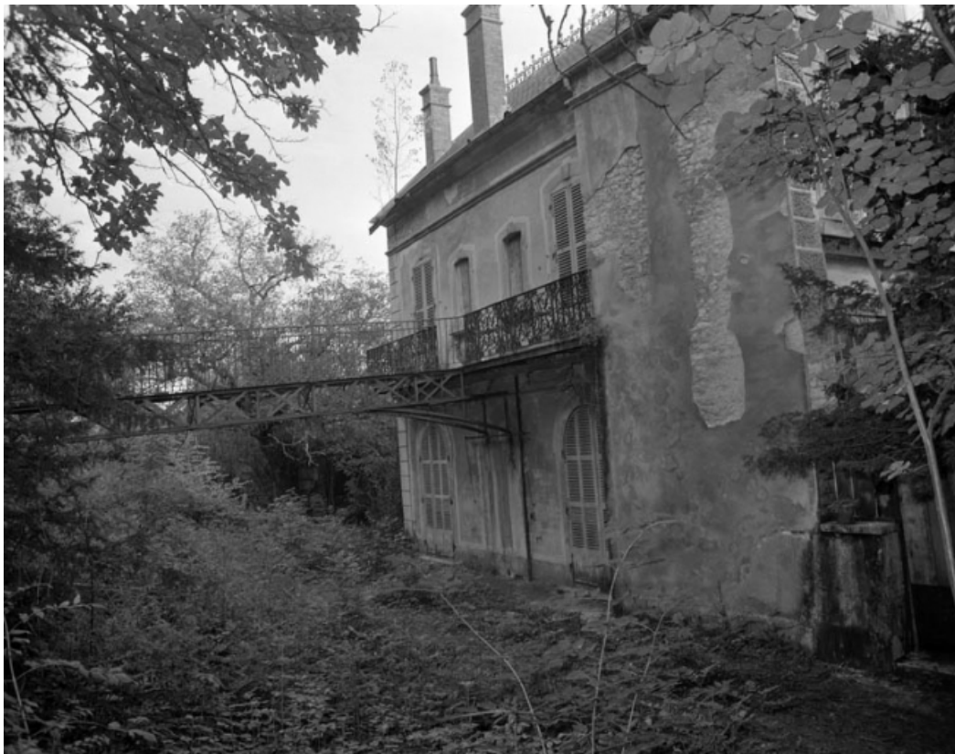
Vue de l'élévation postérieure et de la passerelle conduisant au jardin de trois-quarts droit. 70, Arc-lès-Gray, 50 rue de Dijon
