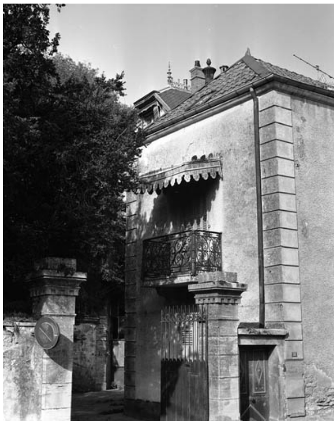
Vue partielle de l'élévation latérale gauche du logis.
