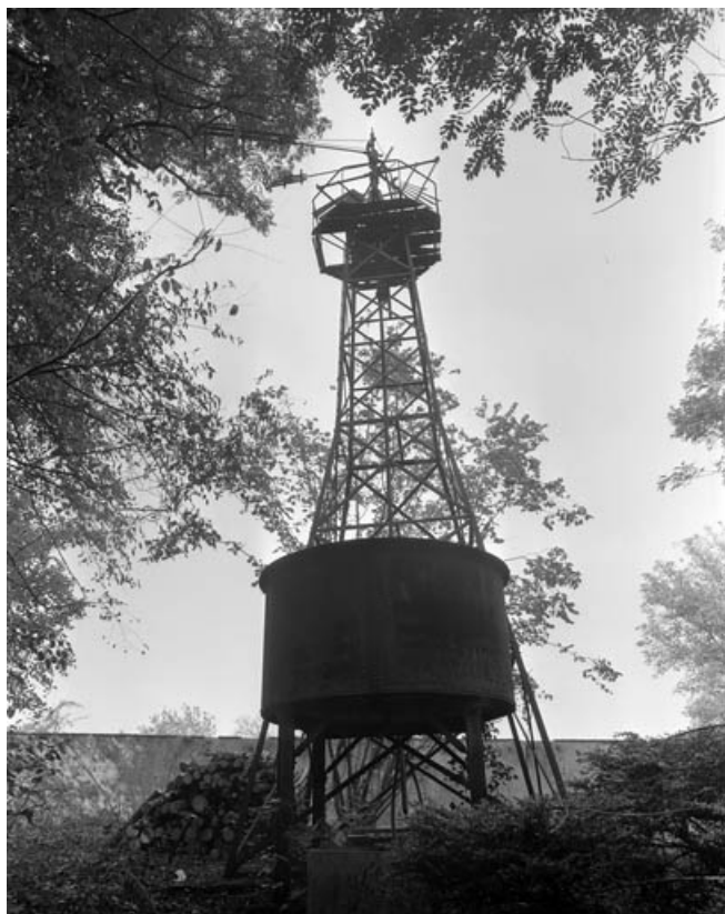
Vue rapprochée du château d'eau et de l'éolienne.
