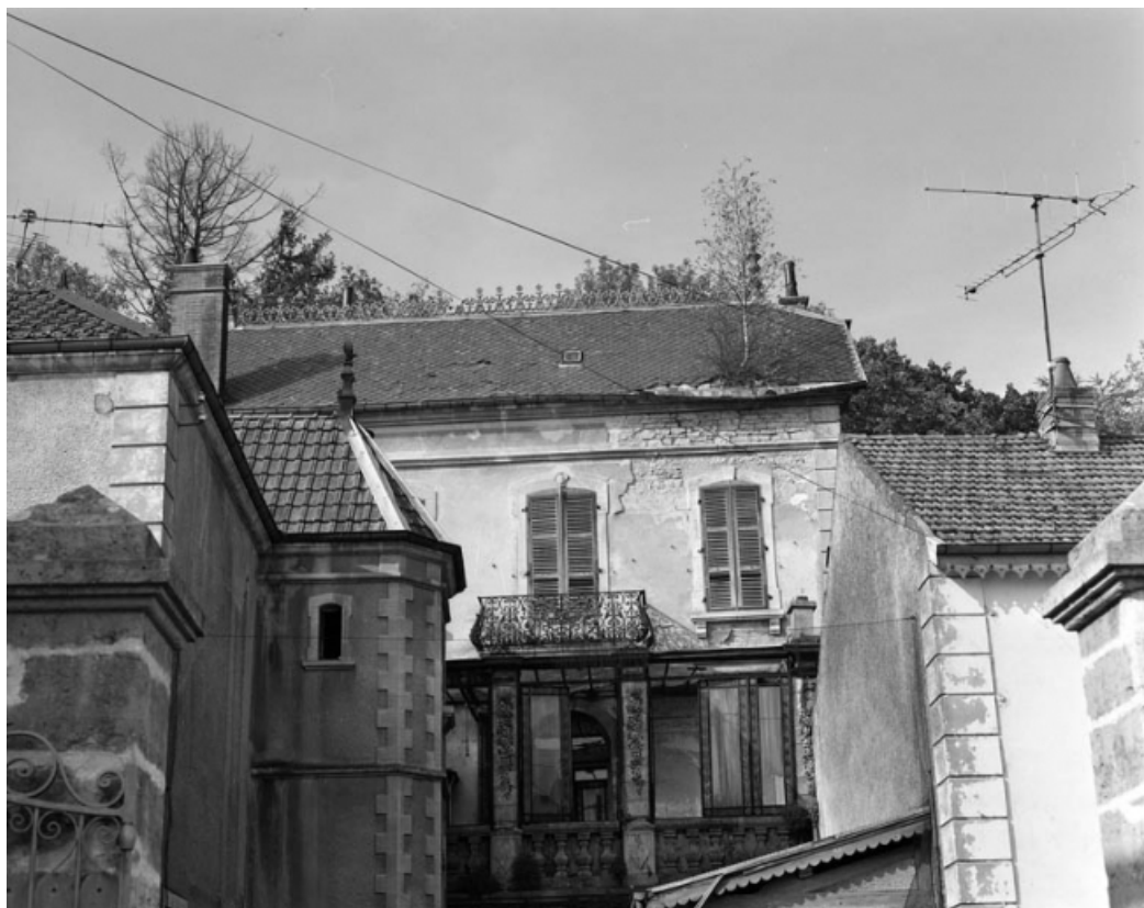
Détail de l'élévation antérieure du logis.
