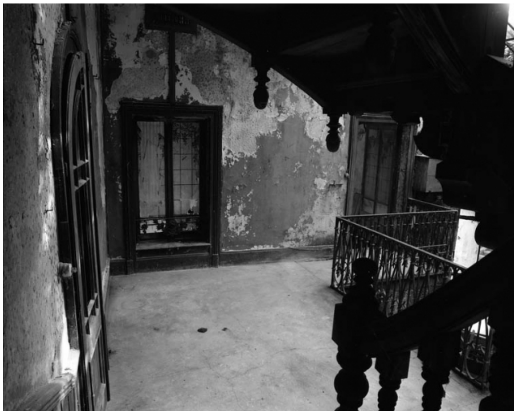
Vue du palier du 1er étage depuis l'escalier conduisant au grenier.
