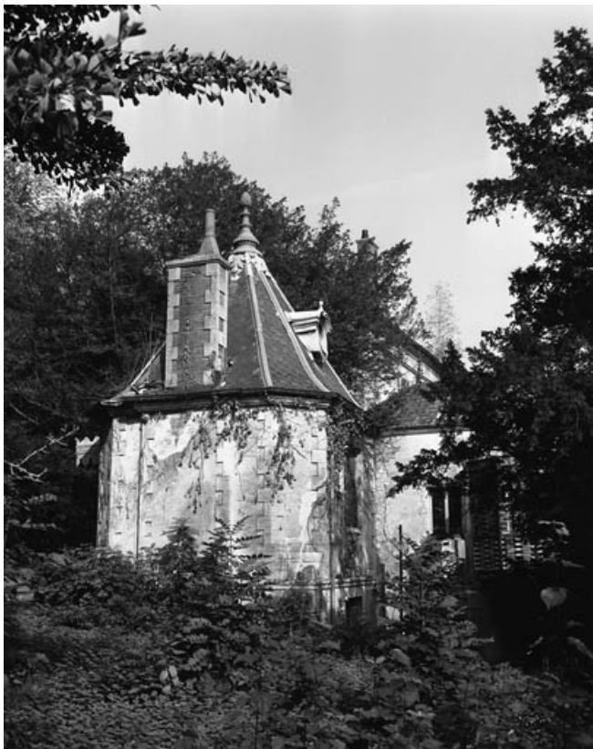
Vue d'ensemble du pavillon de jardin (n° 1) depuis la terrasse. 70, Arc-lès-Gray, 50 rue de Dijon
