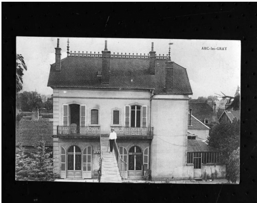
Élévation postérieure avec la passerelle.
