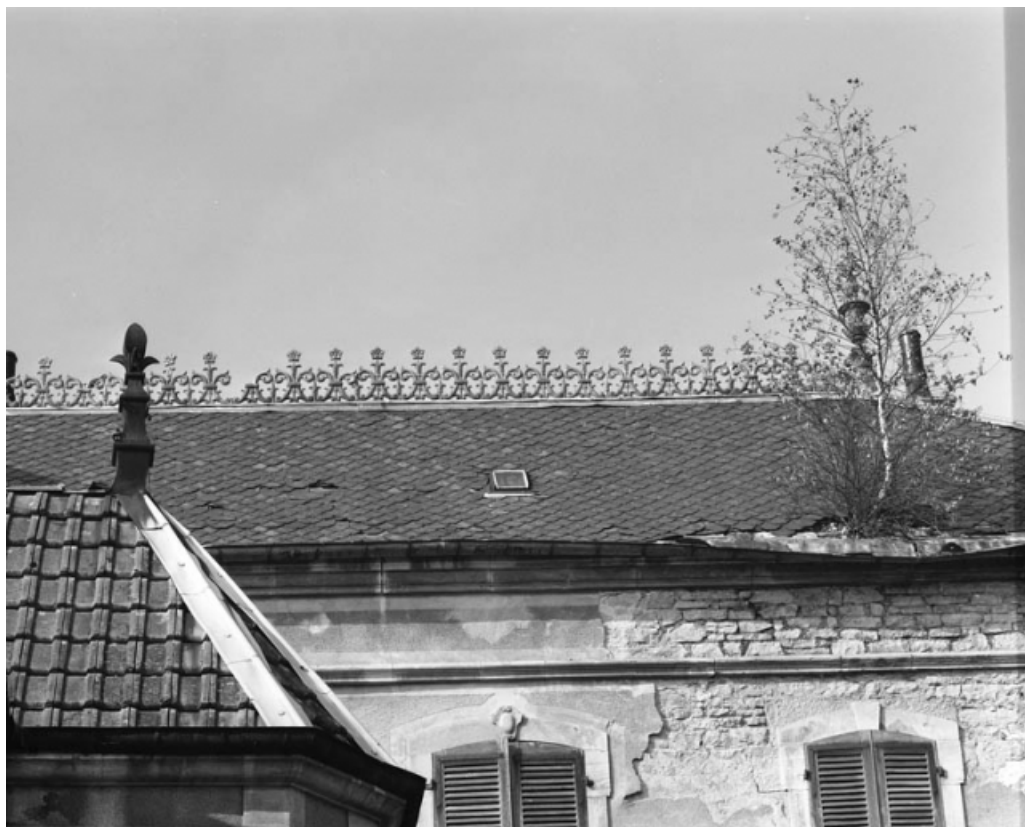
Vue de la crête du toit du logis.
