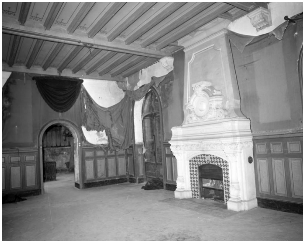
Vue de la salle de billard : la cheminée et la porte ouvrant sur le palier du 1er étage. 70, Arc-lès-Gray, 50 rue de Dijon
