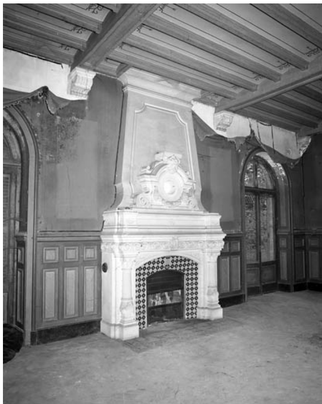
Vue de la cheminée de la salle de billard de trois-quart gauche. 70, Arc-lès-Gray, 50 rue de Dijon
