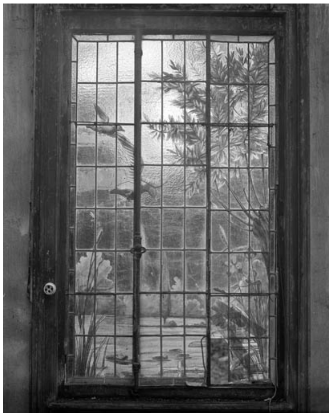
Intérieur de la logette (n° 2) : verrière fermant la salle de bain. 70, Arc-lès-Gray, 50 rue de Dijon
