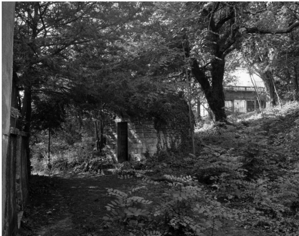
Vue d'ensemble du pavillon (n° 4) et de l'orangerie.
