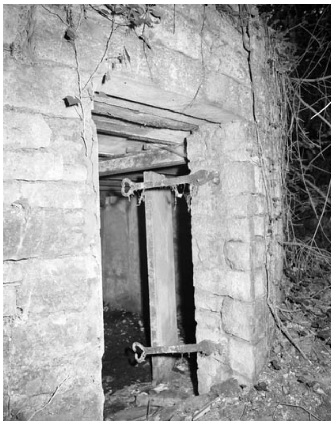
Intérieur du fruitier : vue partielle de la double paroi.
