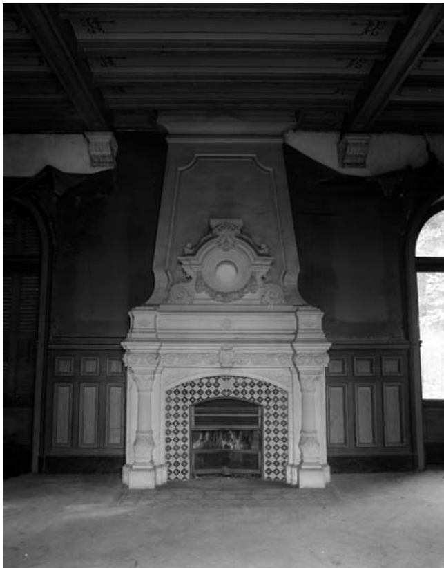
La cheminée de la salle de billard vue de face.
