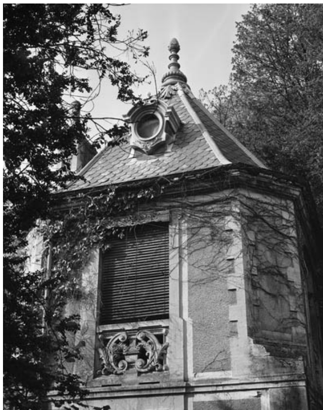
Vue du 1er étage du pavillon de jardin (n° 1).
