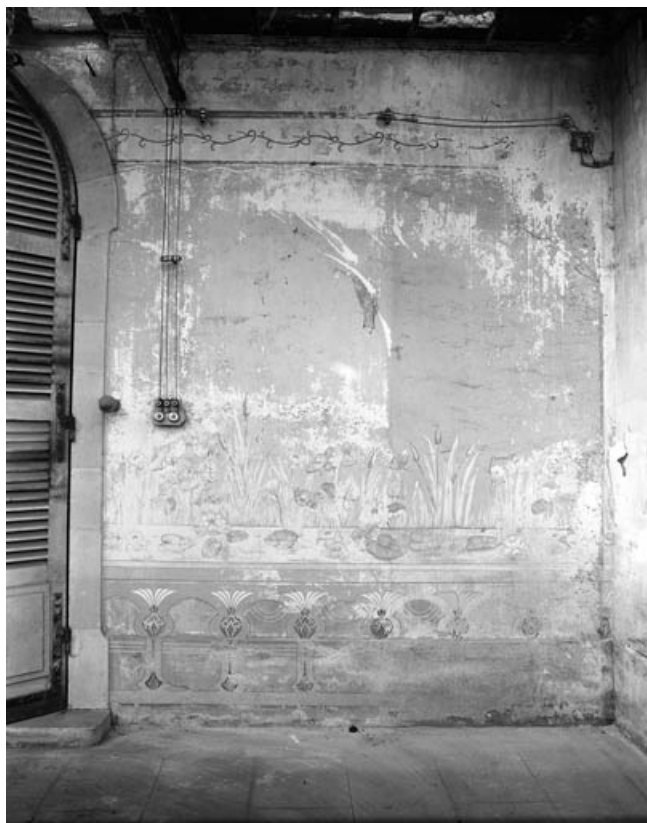
Vue intérieure de la logette (n° 1) : peinture monumentale.
