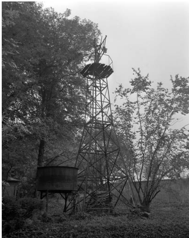
Vue d'ensemble du château d'eau et de l'éolienne.
