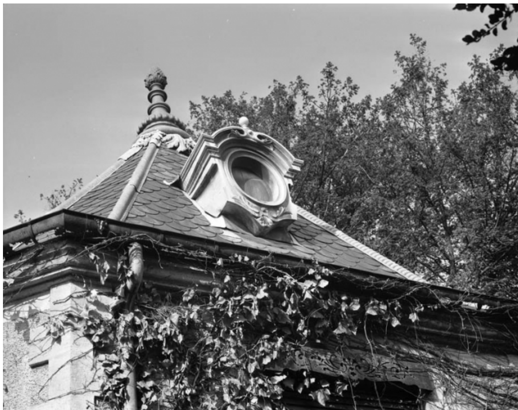
Vue de la lucarne du pavillon de jardin (n° 1). 70, Arc-lès-Gray, 50 rue de Dijon
