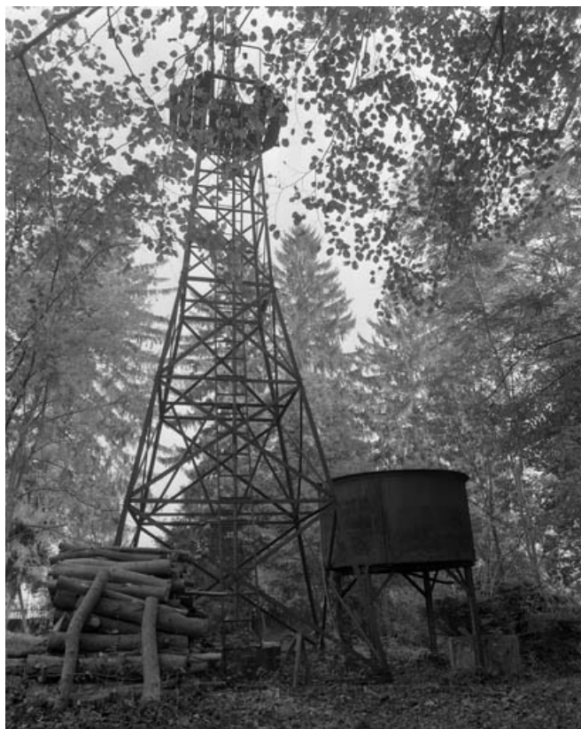
Vue d'ensemble de l'éolienne et du château d'eau.
