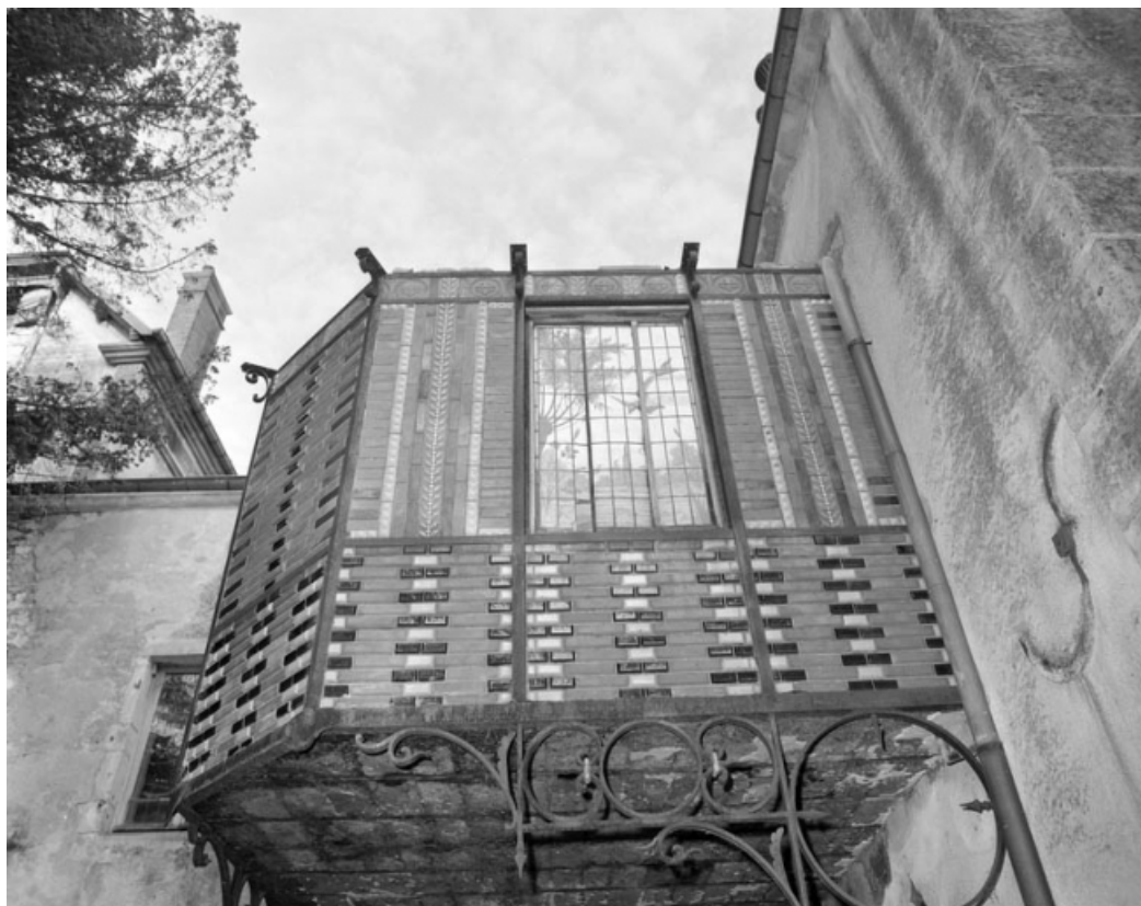
Logette (n° 2) abritant la salle de bain. 70, Arc-lès-Gray, 50 rue de Dijon
