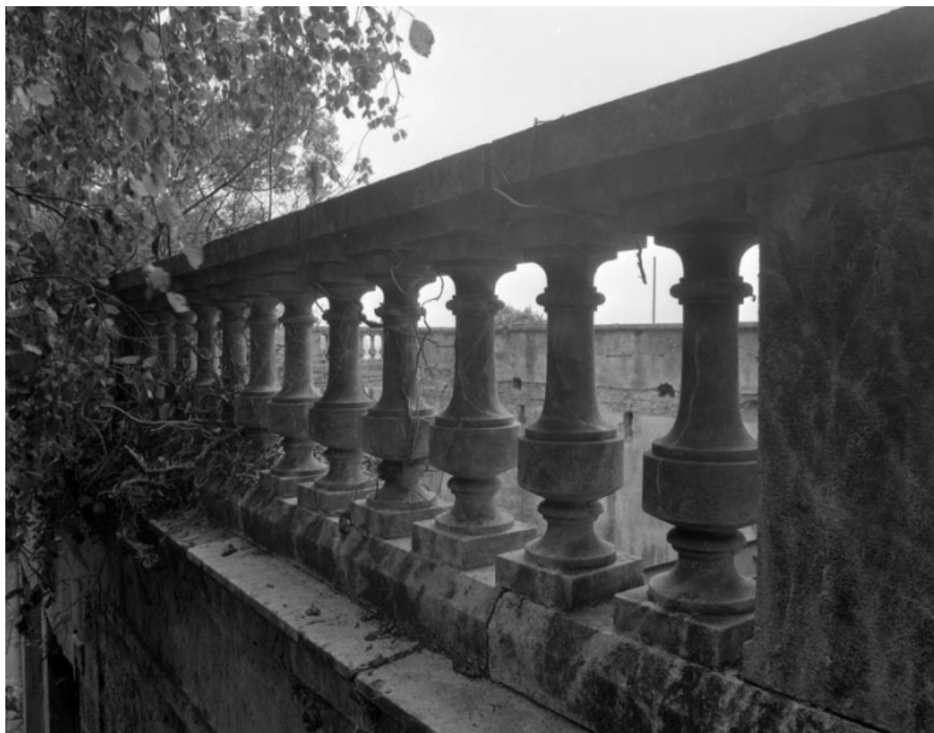
Vue partielle de la balustrade de l'orangerie.
