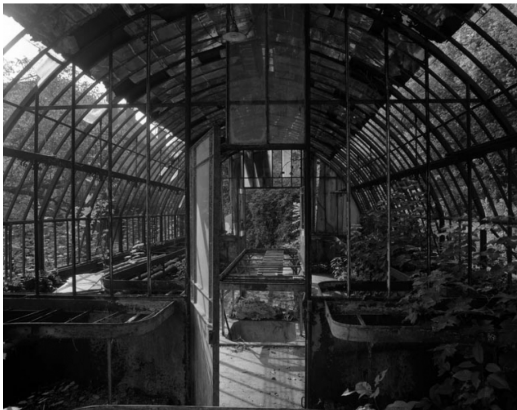
Vue intérieure de la serre.
