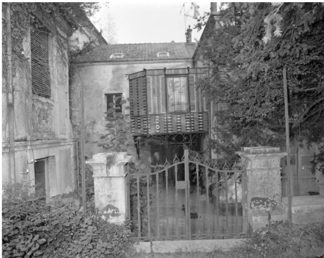
Élévation de l'aile du logis depuis le jardin.
