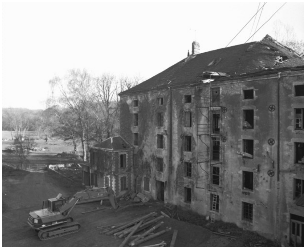
Façade antérieure du moulin public en 1989.
