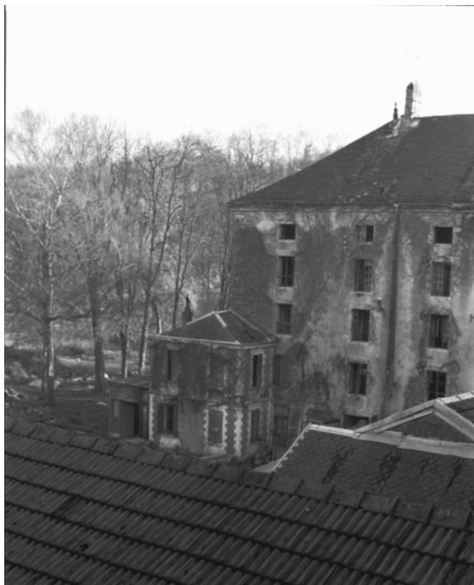
Extrémité nord du moulin public et logement attenant en 1989. 70, Port-sur-Saône rue Gilberte Lavaire
