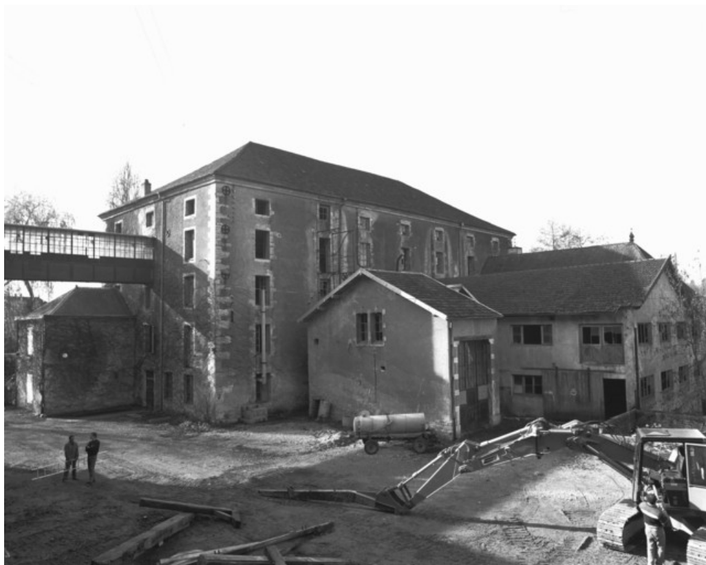
Le moulin de commerce vu de trois quarts arrière en 1989. 70, Port-sur-Saône rue Gilberte Lavaire
