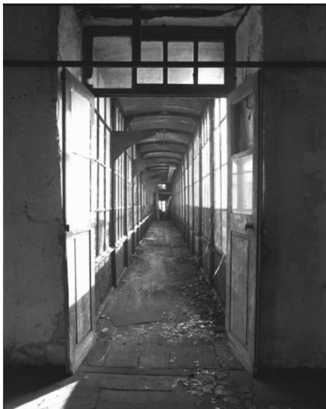
L'entrée de la passerelle depuis le moulin de commerce en 1989. 70, Port-sur-Saône rue Gilberte Lavaire
