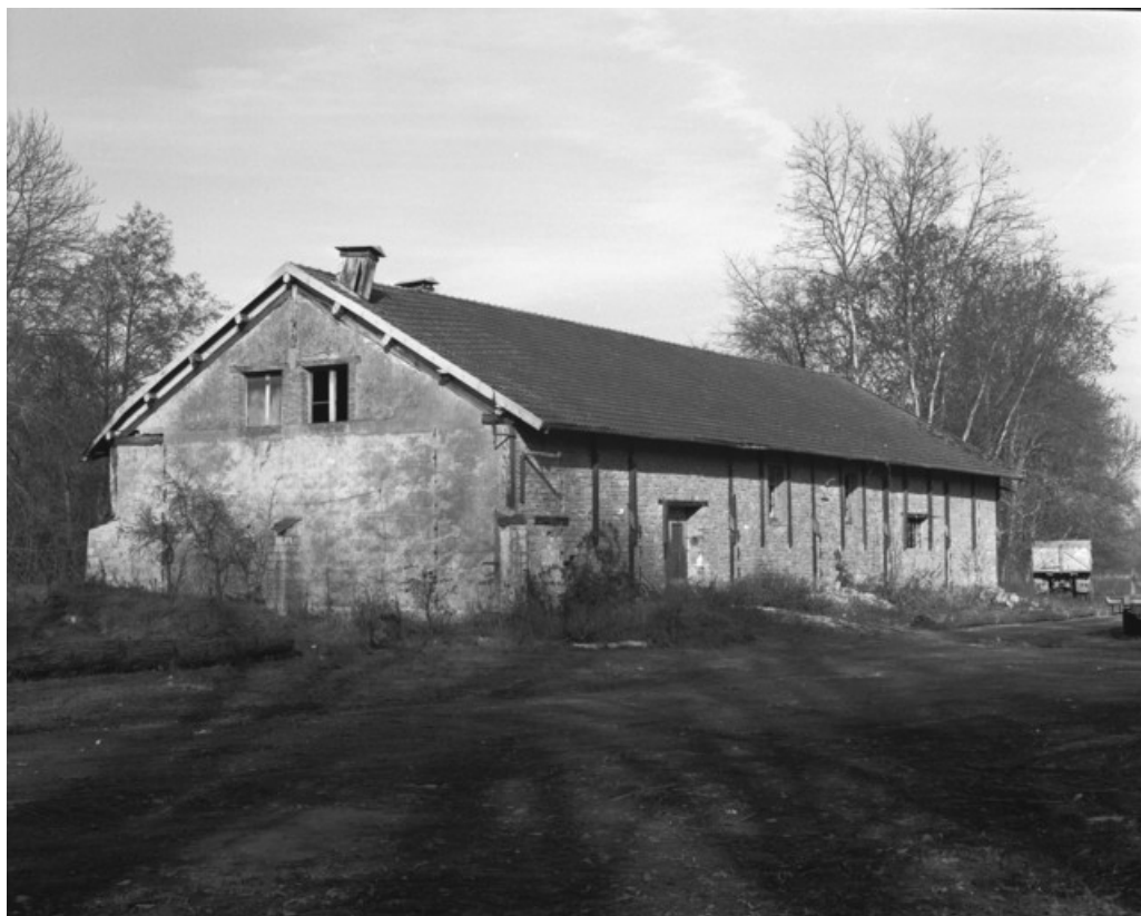
Vue rapprochée de l'entrepôt industriel en 1989.
