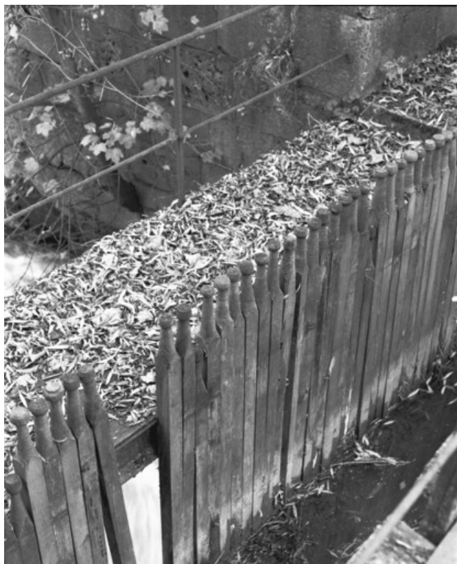
Détail des aiguilles du barrage en 1989.
