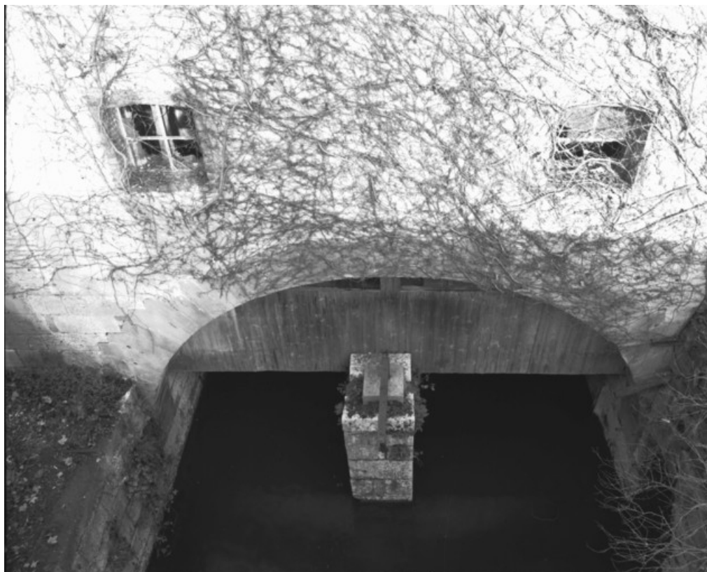
Canal de fuite du moulin de commerce en 1989.
