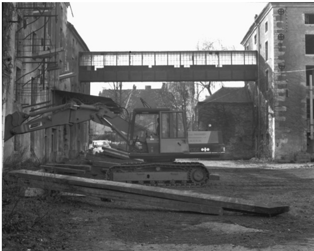
Vue rapprochée de la passerelle en 1989.
