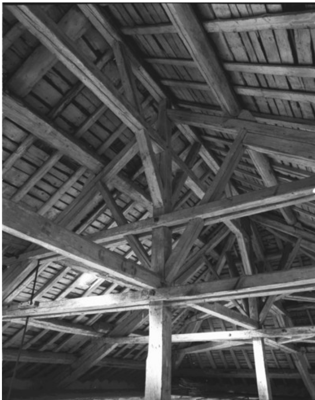
Vue de la charpente du moulin de commerce en 1989.
