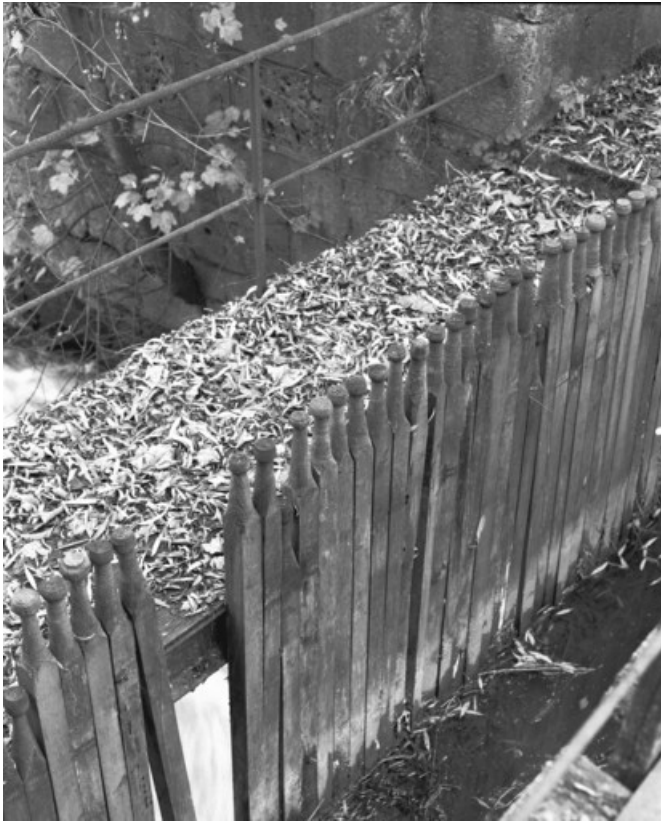
Détail des aiguilles du barrage en 1989.
