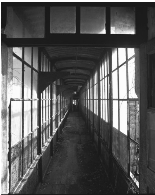
Intérieur de la passerelle en 1989.
