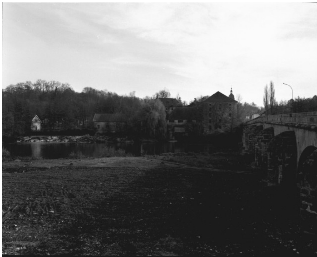
Vue d'ensemble depuis l'ouest en 1989.
