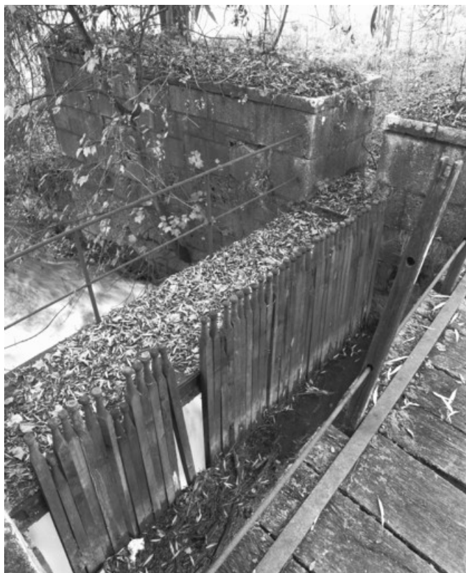
Barrage à aiguilles sur le canal d'aménée en 1989.
