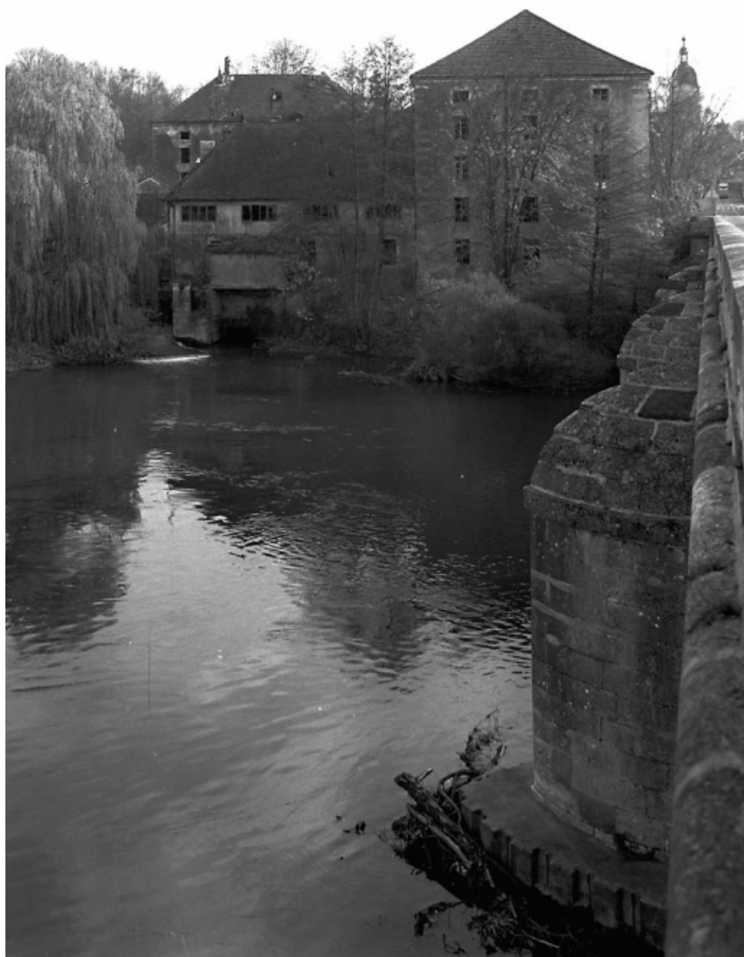
Vue d'ensemble depuis le Grand Pont en 1989.
