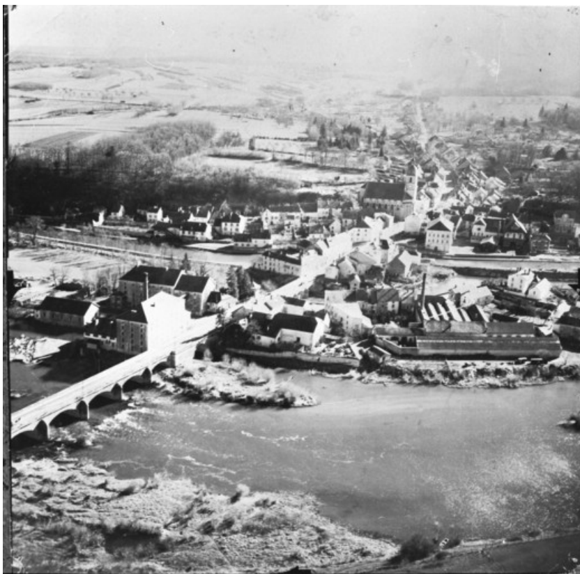
Vue aérienne depuis l'ouest.
