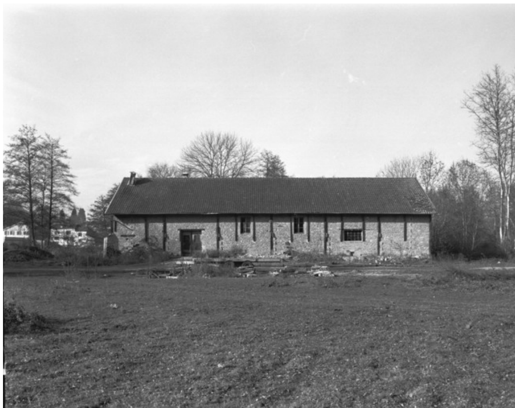
Vue de face de l'entrepôt industriel en 1989.
