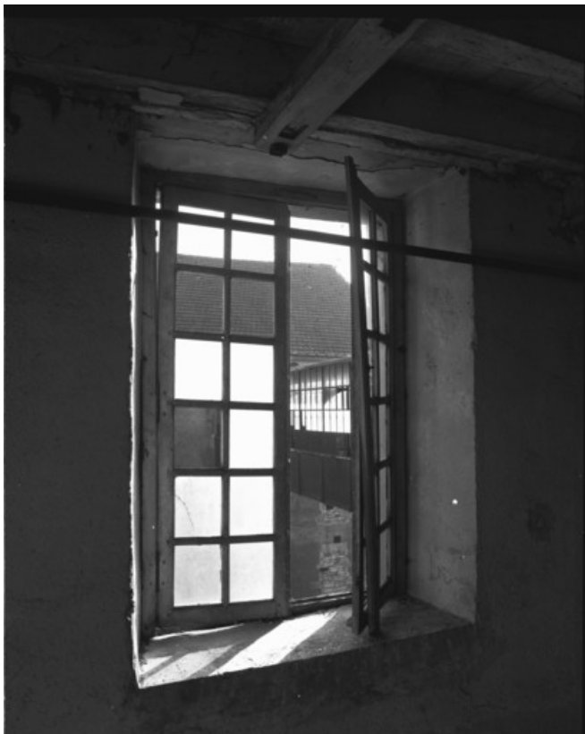
Détail d'une fenêtre du 4e niveau du moulin de commerce en 1989. 70, Port-sur-Saône rue Gilberte Lavaire
