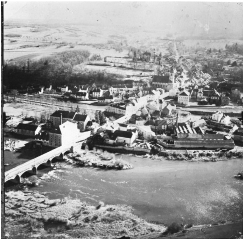
Vue aérienne depuis l'ouest.
