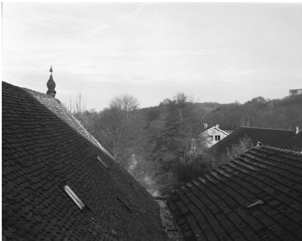
Vue depuis le toit de la salle des machines en 1989.
