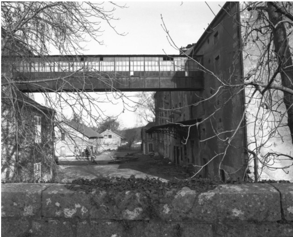
La passerelle depuis la rue en 1989. 70, Port-sur-Saône rue Gilberte Lavaire
