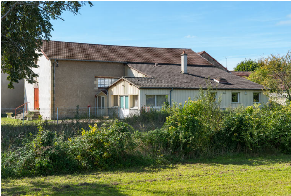
Façade latérale droite, de trois quarts gauche.
