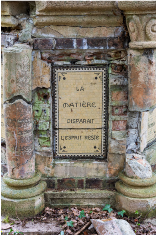
Soubassement, détail, inscription : "La matière disparaît l'esprit reste." 58, Pougues-les-Eaux, 130 avenue de Paris, lieudit : La Montjaie
