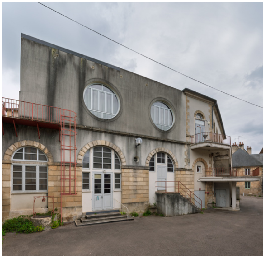
Façade latérale gauche de l'extension (salle de sport et salle des fêtes). 58, Prémery, 8 place de la Mairie
