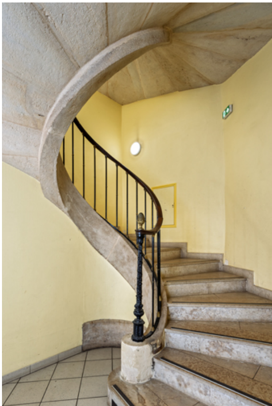
Rez-de-chaussée : escalier en vis.
