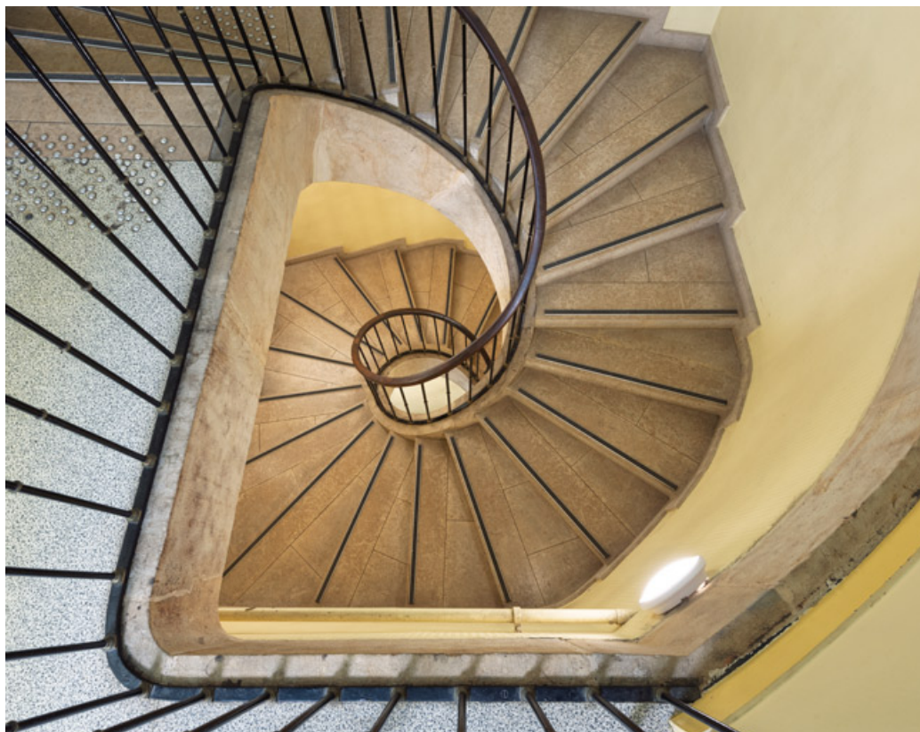
Escalier en vis : vue plongeante oblique depuis le palier de l'étage. 58, Prémery, 8 place de la Mairie
