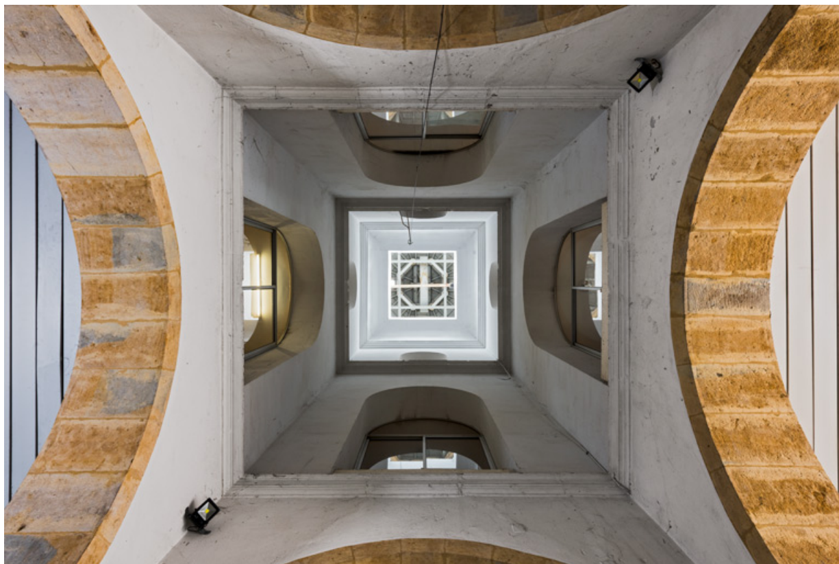
Rez-de-chaussée, halle : lanternon.
