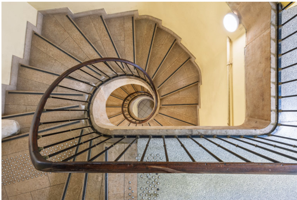
Escalier en vis : vue plongeante depuis le palier de l'étage.
