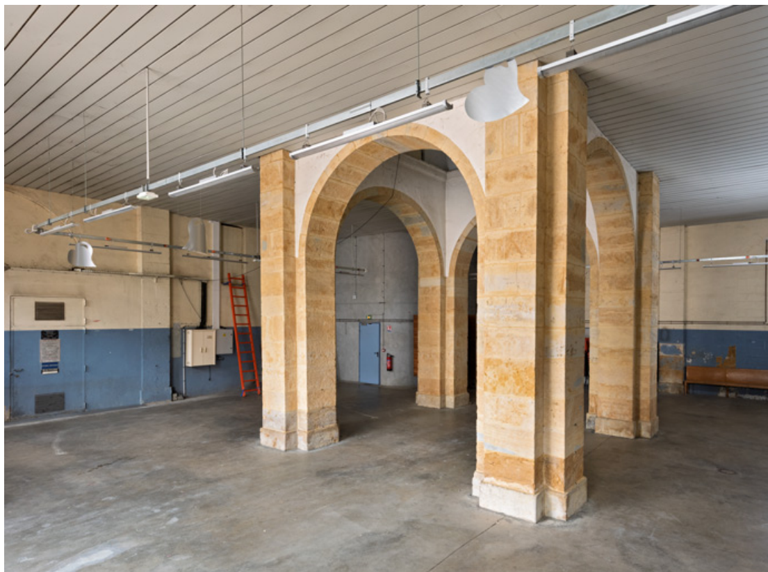
Rez-de-chaussée, halle : vue d'ensemble.
