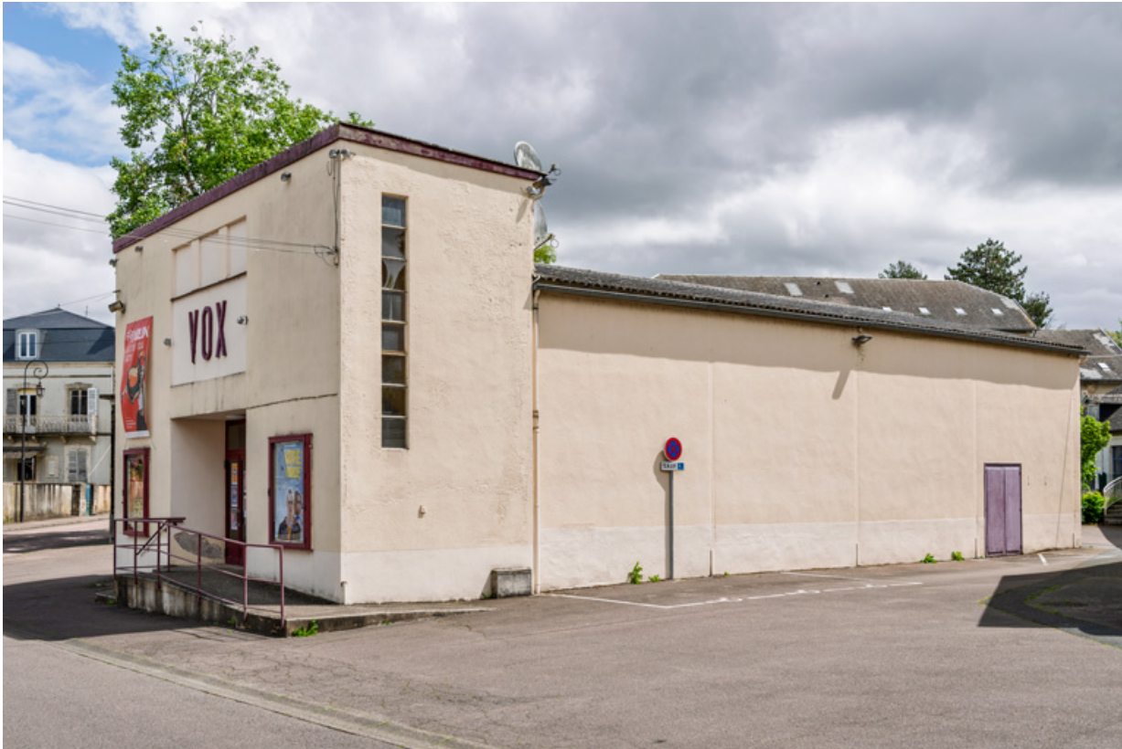
Vue d'ensemble depuis le sud (façades antérieure et latérale droite). 58, Luzy, 9 rue des Remparts
