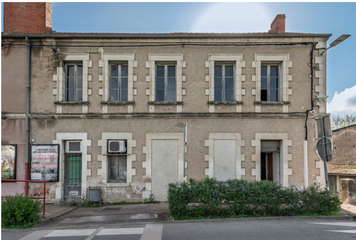
Façade antérieure, partie droite.
