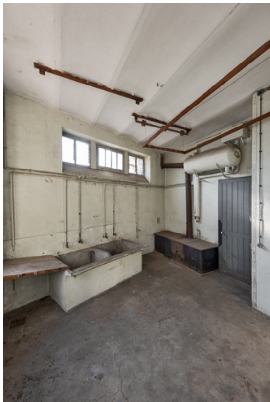
Vue intérieure de la buanderie.
