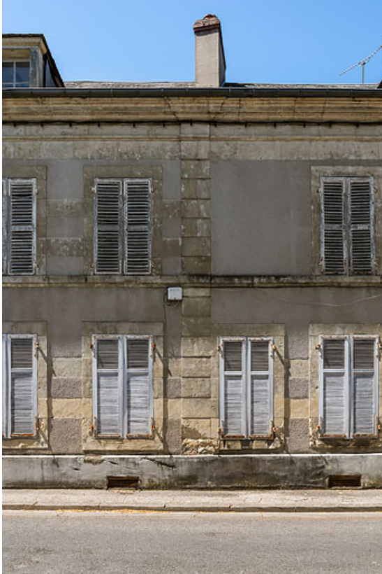
Façade sur la rue du Docteur Jean Pidoux, jambe marquant l'agrandissement de la demeure (à droite). 58, Pougues-les-Eaux, 57 avenue de Paris
