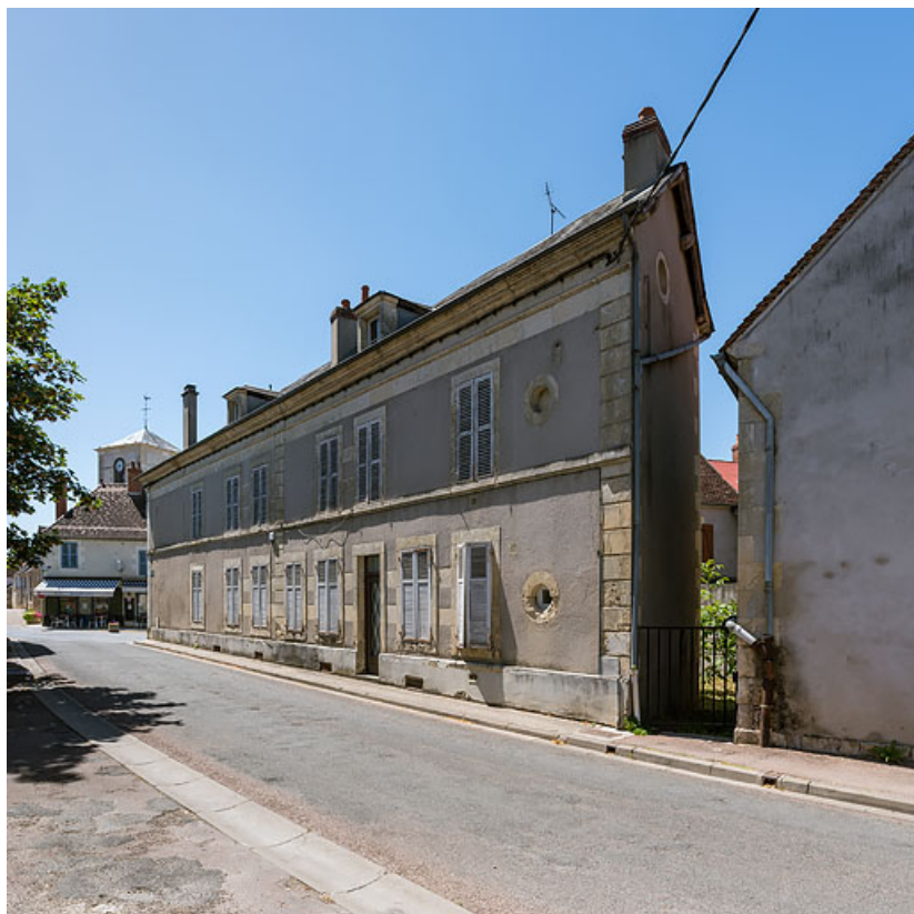
Façade sur la rue du Docteur Jean Pidoux.
