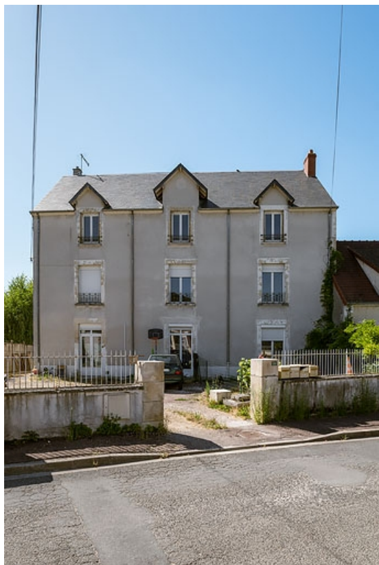
Façade depuis la rue de Bourgneuf.
