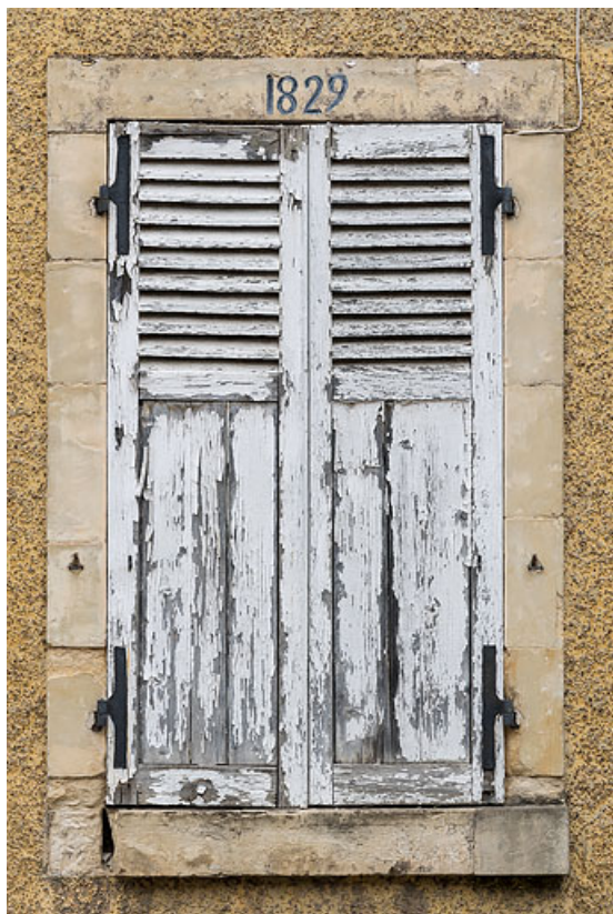
Fenêtre à encadrement de pierre portant la date (1829).
