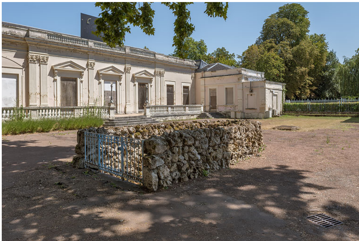
Escalier de la source, vue depuis le nord.
