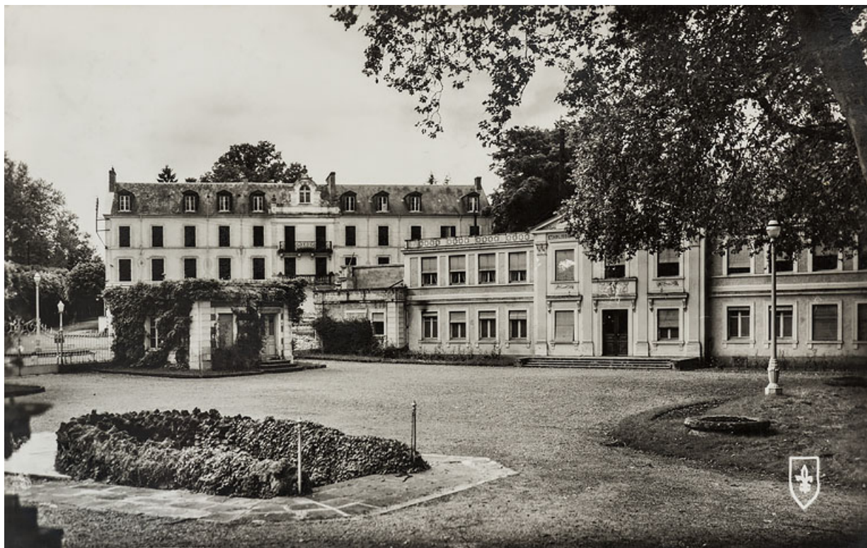
Margelles en pierre des anciennes sources Saint-Léger et saint Marcel dans la pelouse à l'entrée du parc (à droite) et escalier de la source (à gauche).
