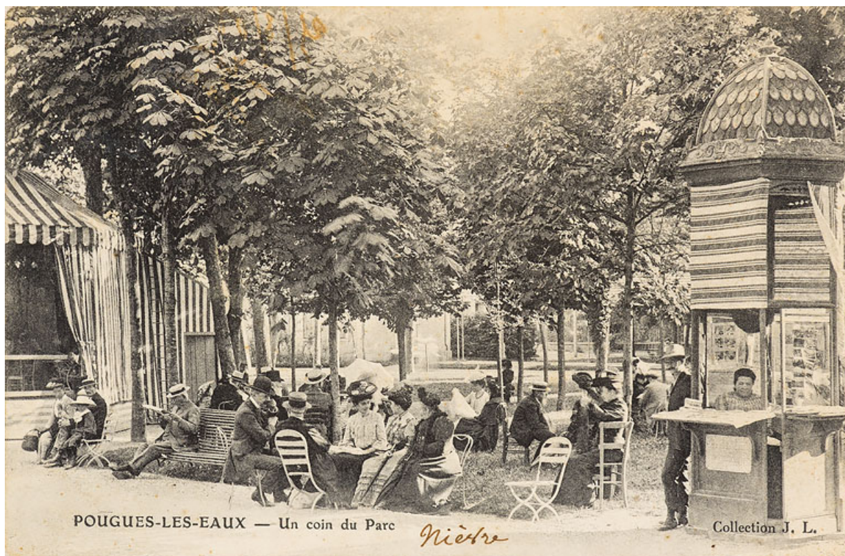
Rassemblement à proximité du kiosque à musique.
