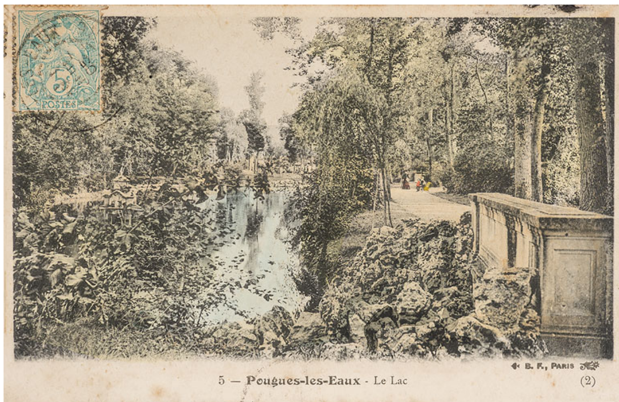
Pont de pierre au nord du lac (état au début du 20e siècle).
