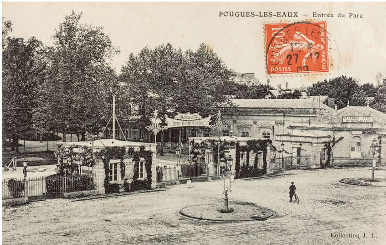
Portail de l'entrée principale, état au début du 20e siècle.
