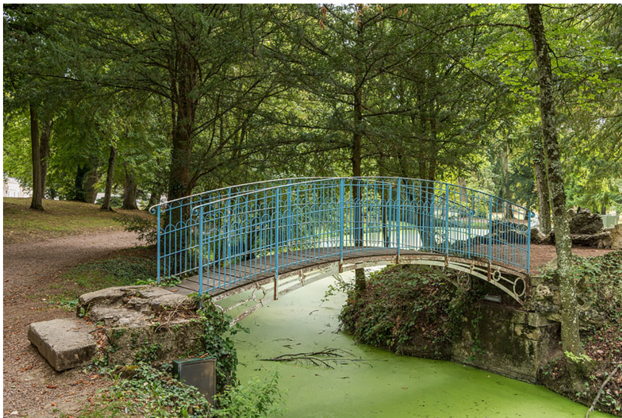
Passerelle métallique donnant accès à l'île. 58, Pougues-les-Eaux, 23-25 avenue de Conti
