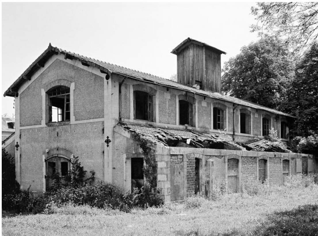
Magasin d'embouteillage, façade postérieure.
