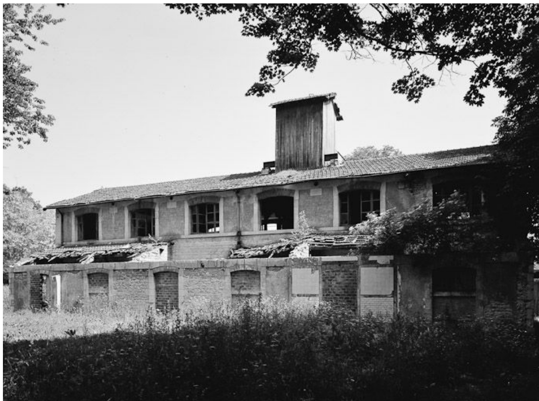
Magasin d'embouteillage, façade postérieure.
