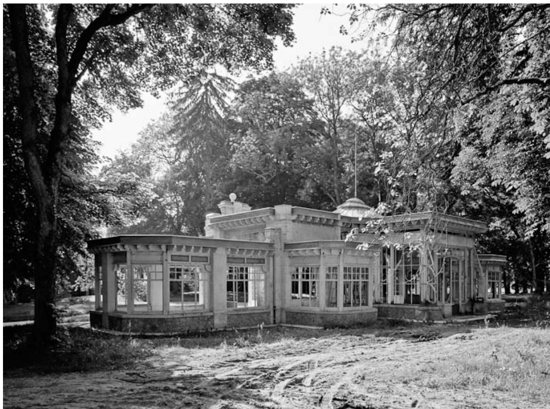
Pavillon des sources Saint-Léon et Saint-Léger, façade postérieure.
