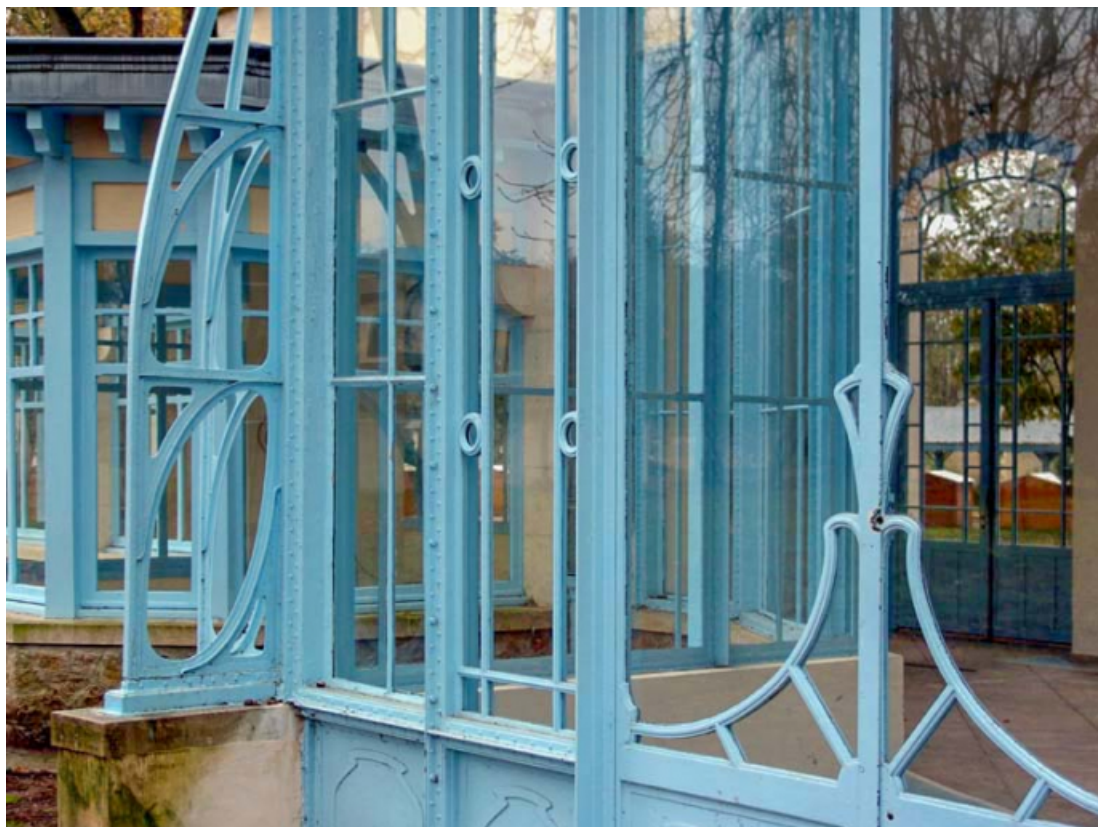
Façade est, vue en 2005.
