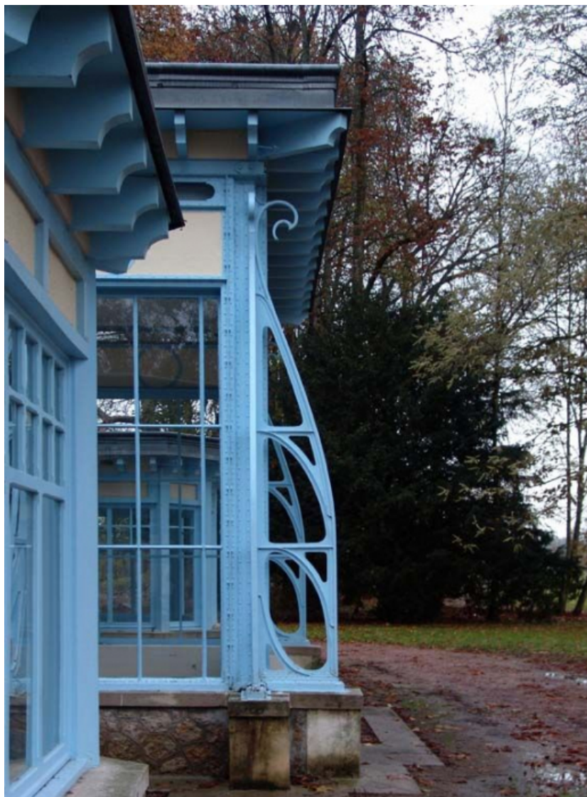
Façade est, vue en 2005.
