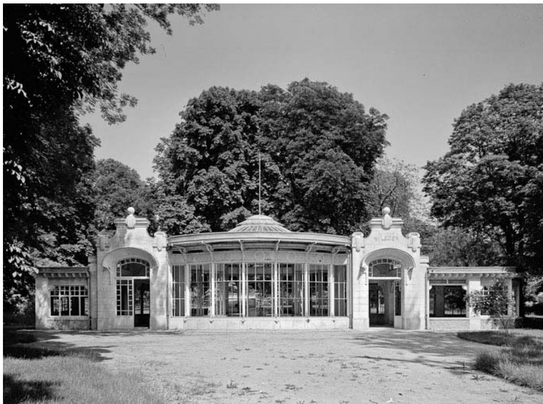
Pavillon des sources Saint-Léon et Saint-Léger, façade antérieure.
