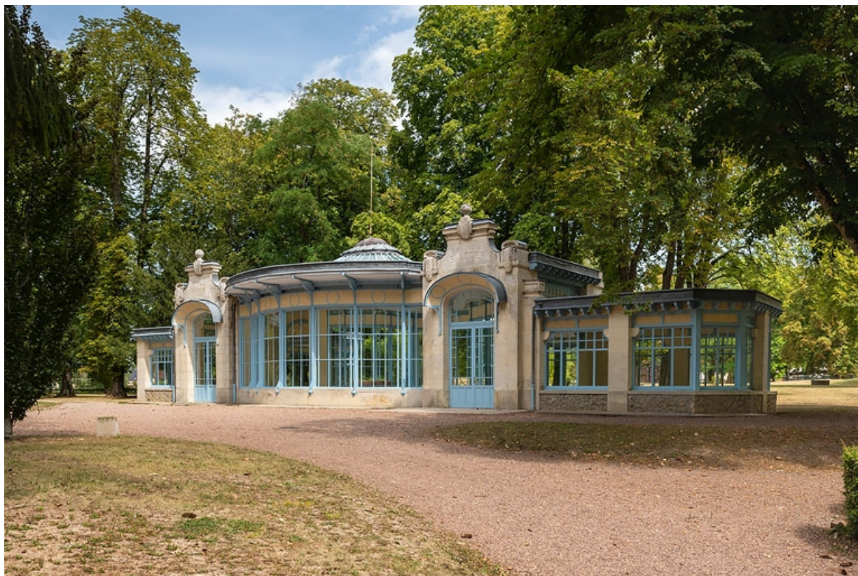
Façade ouest, vue en 2020.
