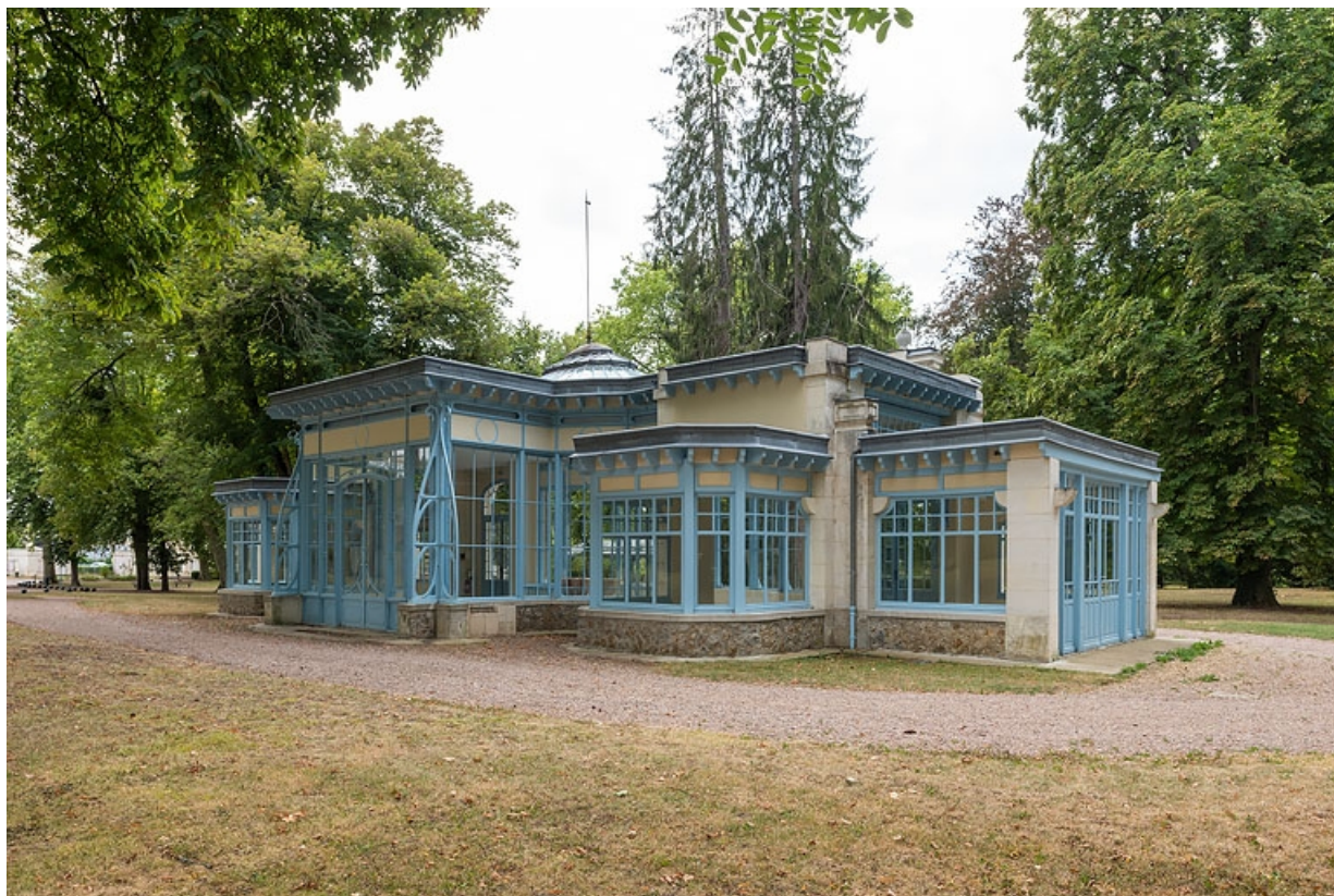
Façade est, vue en 2020.
