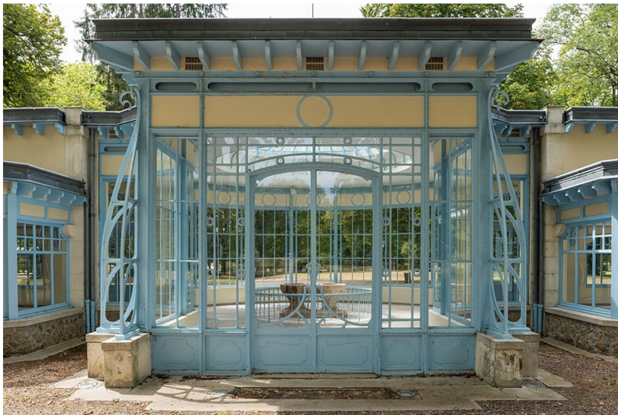
Façade est, vue en 2020.
