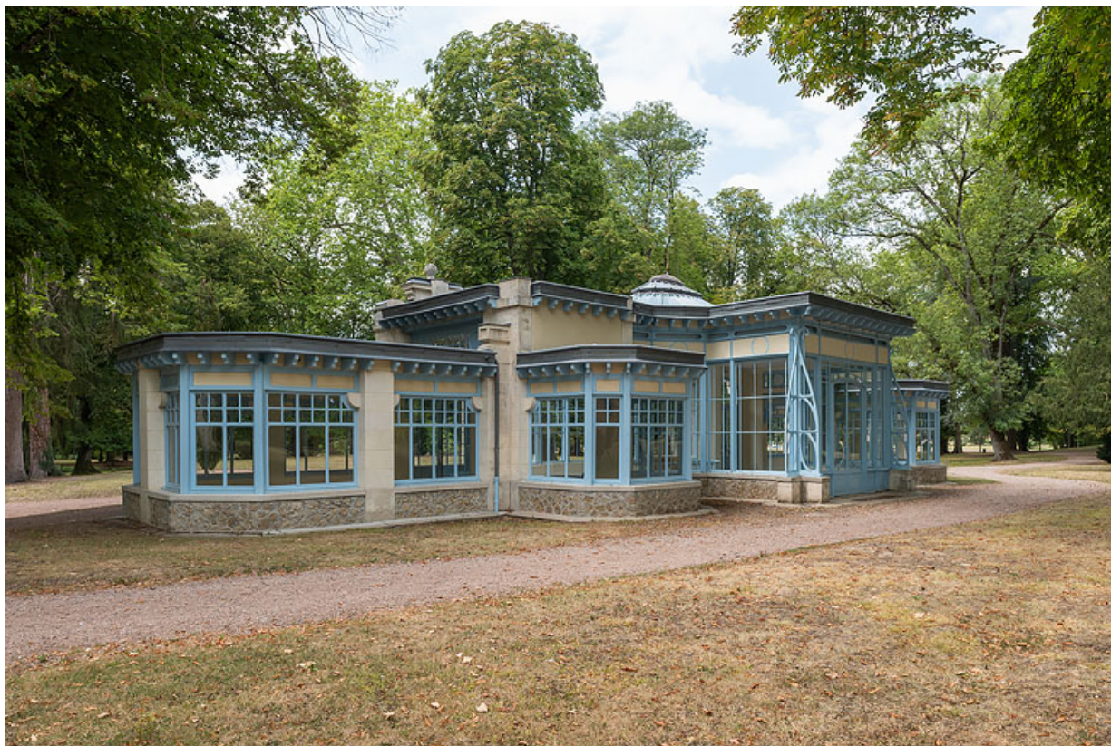
Façade est, vue en 2020.
