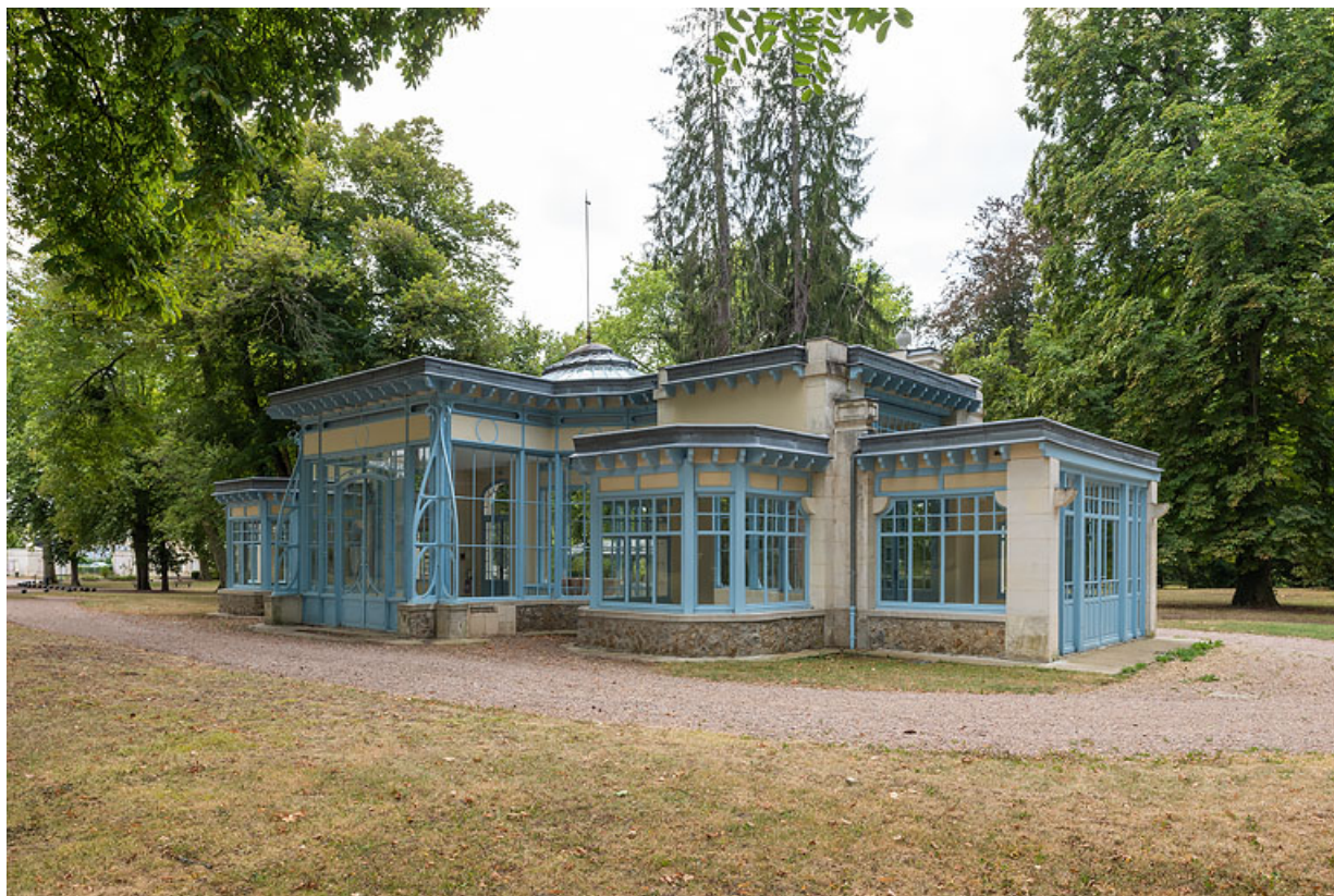
Façade est, vue en 2020.
