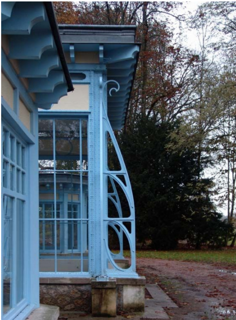
Façade est, vue en 2005.
