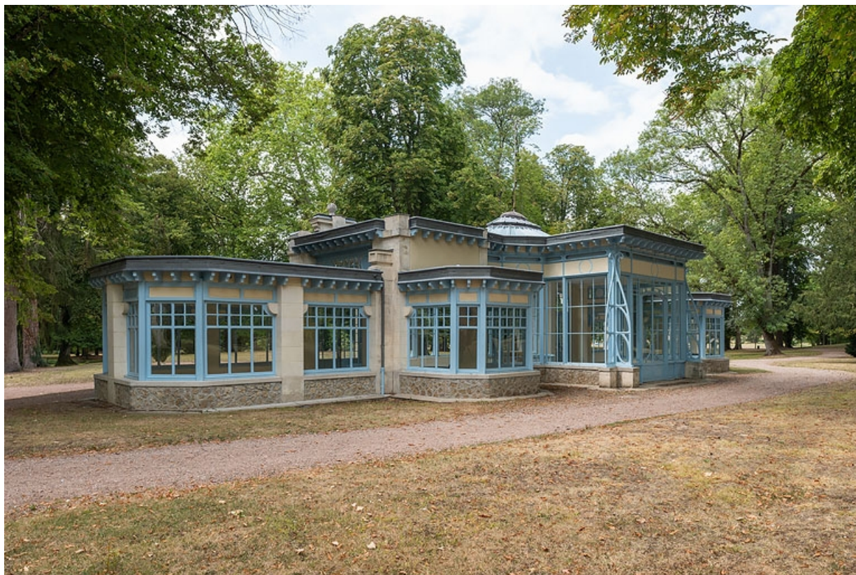
Façade est, vue en 2020.
