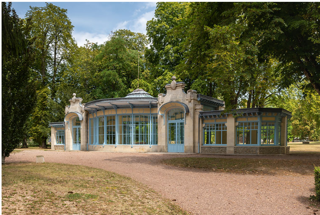
Façade ouest, vue en 2020.
