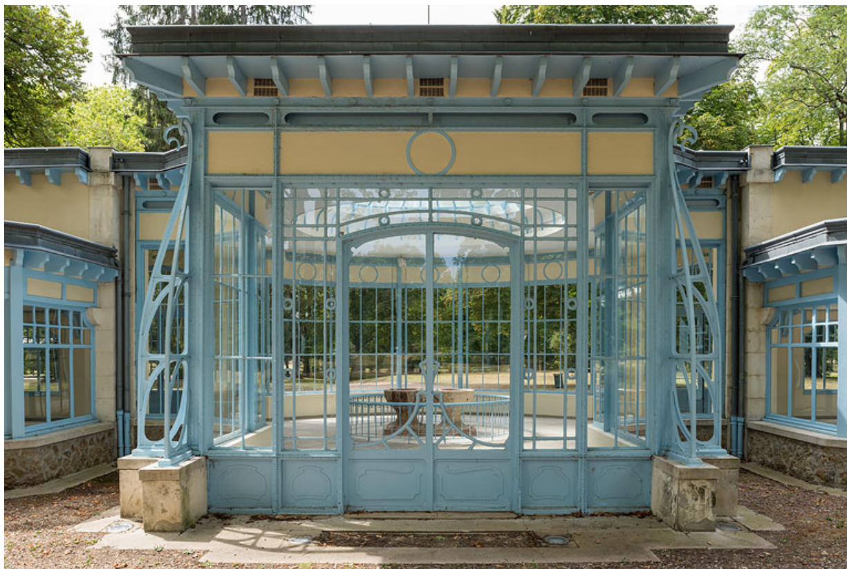
Façade est, vue en 2020.
