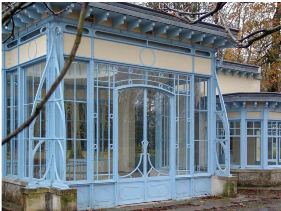
Façade est, vue en 2005.
