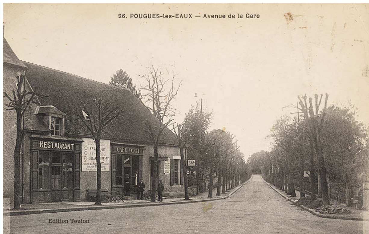
Vue de l'édifice (à gauche) au croisement de l'avenue de la Gare et de l'avenue de Paris. 58, Pougues-les-Eaux
