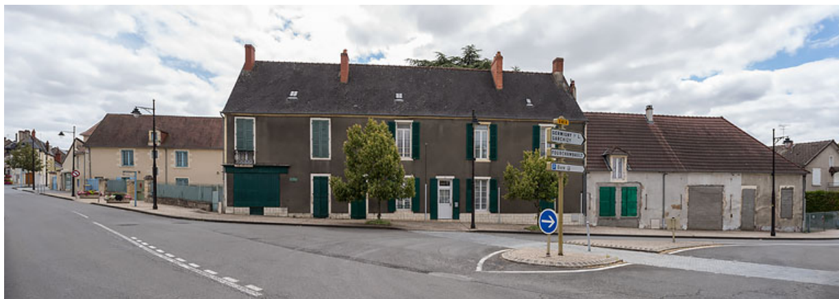
Vue d'ensemble, depuis le croisement de l'avenue de Paris et de l'avenue de la Gare. 58, Pougues-les-Eaux, 40 avenue de Paris
