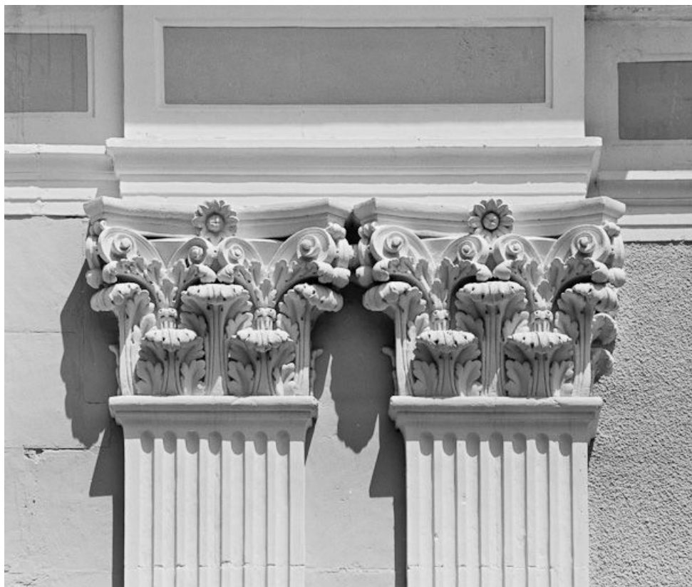
Casino, façade antérieure : détail de deux pilastres.
