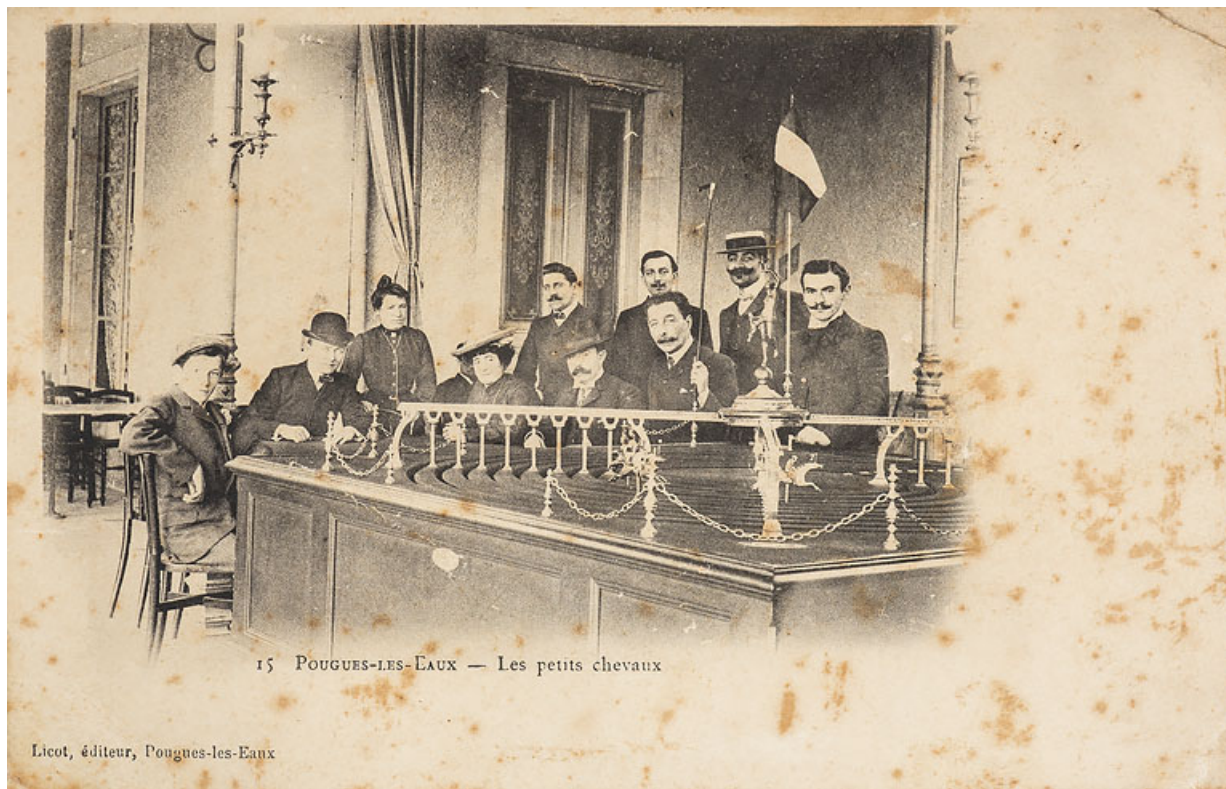
Vue intérieure du kiosque des petits chevaux construit en 1895.
