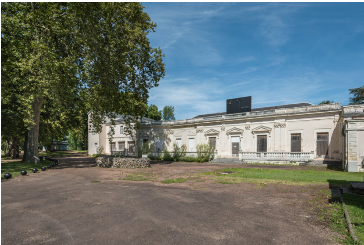
Façade, vue depuis le sud-ouest.
