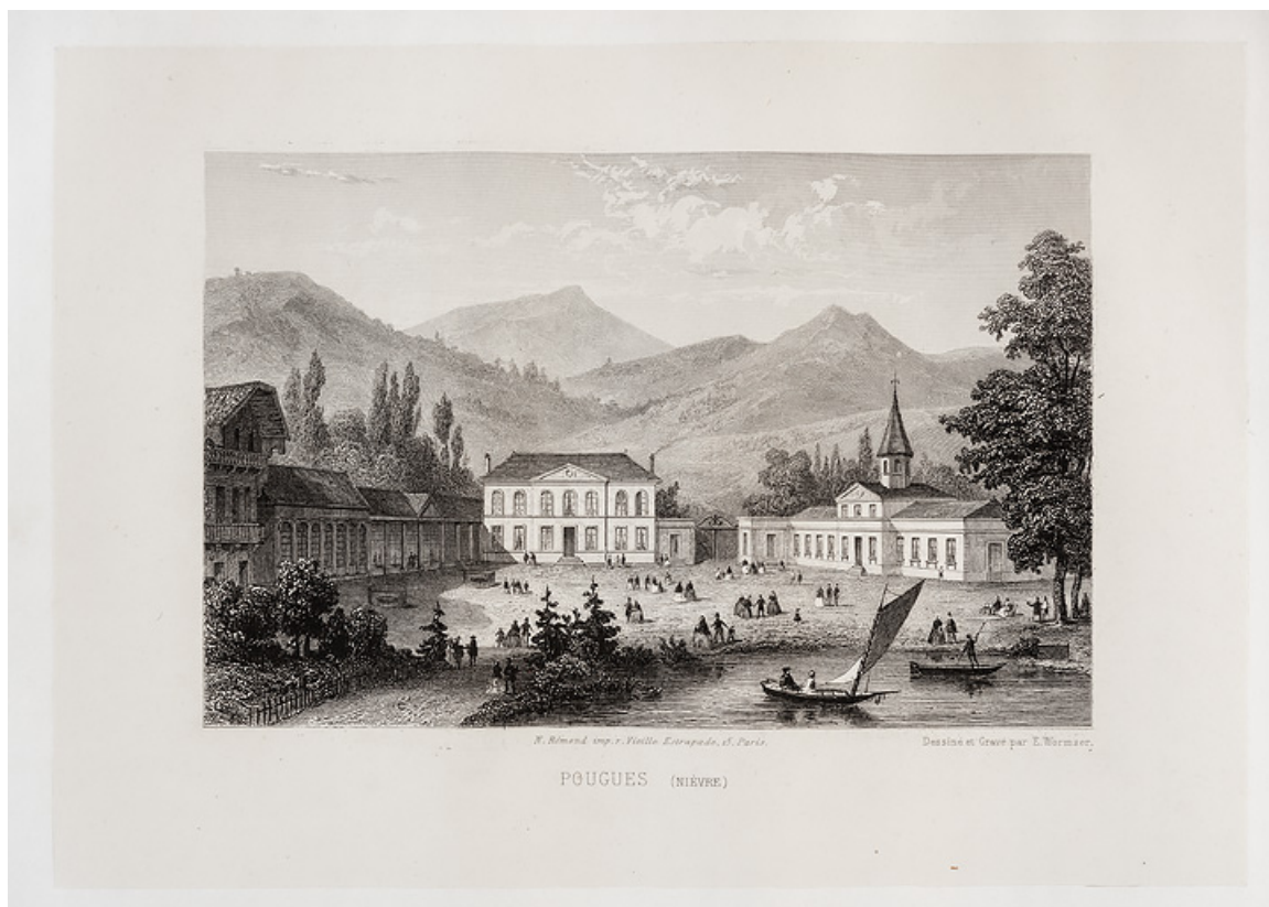
Vue du premier casino (au centre) entre la galerie de la source Saint-Léger et l'établissement thermal. 58, Pougues-les-Eaux, 23-25 avenue de Conti
