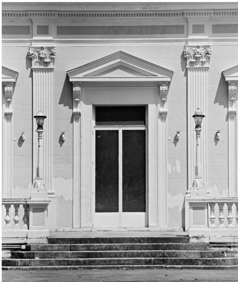
Casino, façade antérieure : détail d'une porte. 58, Pougues-les-Eaux avenue de Conti
