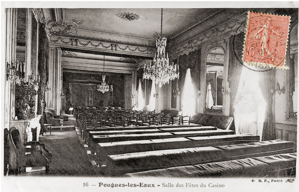
Salle de spectacle du casino construit en 1860-1863, vue en direction de la scène (mur sud-ouest). 58, Pougues-les-Eaux avenue de Conti
