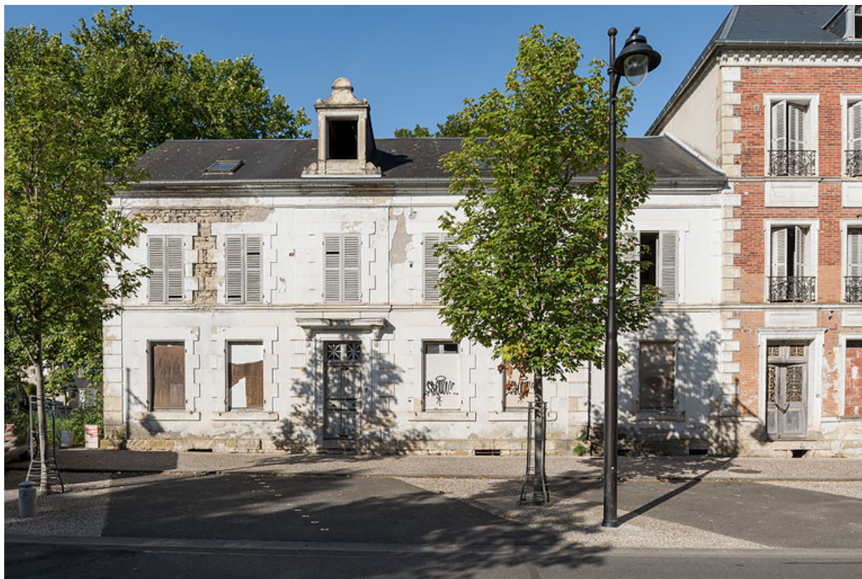
Façade de la maison de Marien dit Georges Bigouret.
