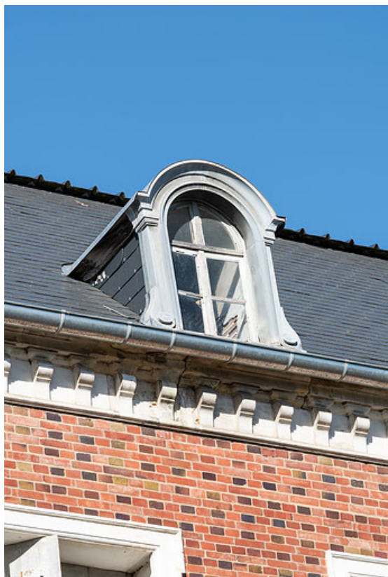
Façade de l'extension de Jules Guimard, lucarne. 58, Pougues-les-Eaux, 34 avenue de Paris
