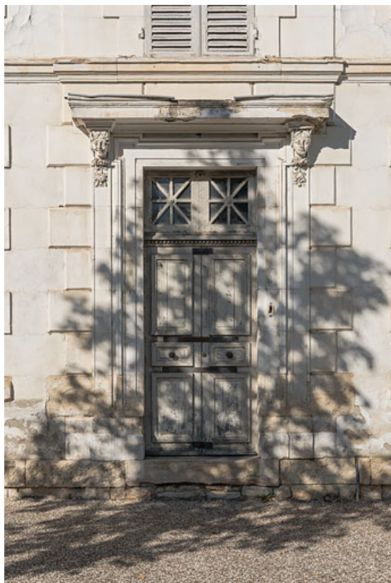
Façade de la maison de Marien dit Georges Bigouret, porte d'entrée. 58, Pougues-les-Eaux, 34 avenue de Paris
