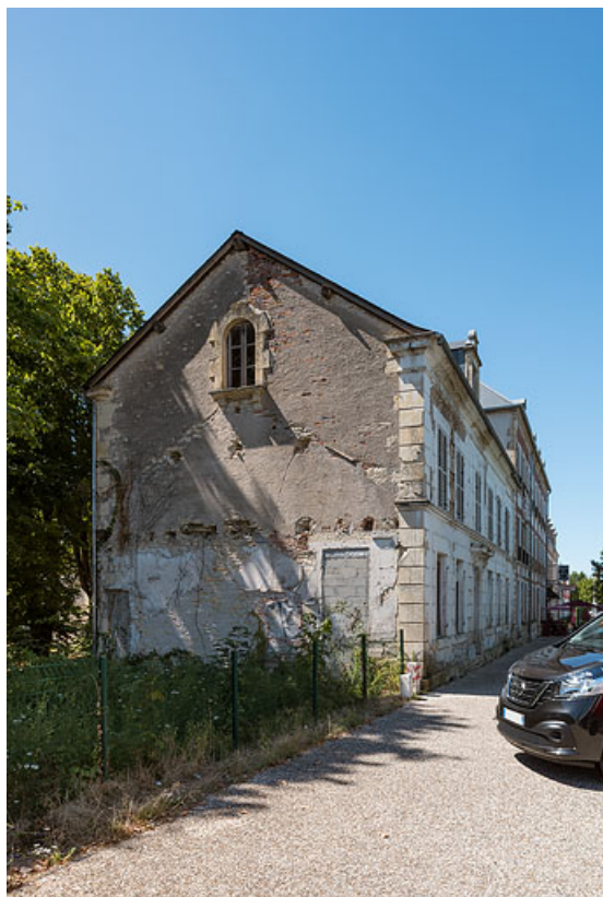
Mur pignon sud de la maison de Marien dit Georges Bigouret (emplacement du garage aujourd'hui détruit). 58, Pougues-les-Eaux, 34 avenue de Paris
