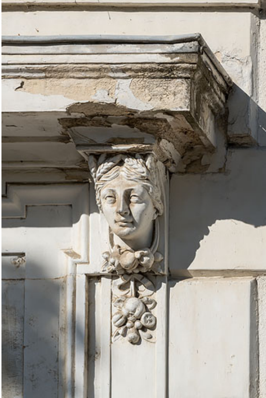
Façade de la maison de Marien dit Georges Bigouret, porte d'entrée, tête allégorique de l'été. 58, Pougues-les-Eaux, 34 avenue de Paris
