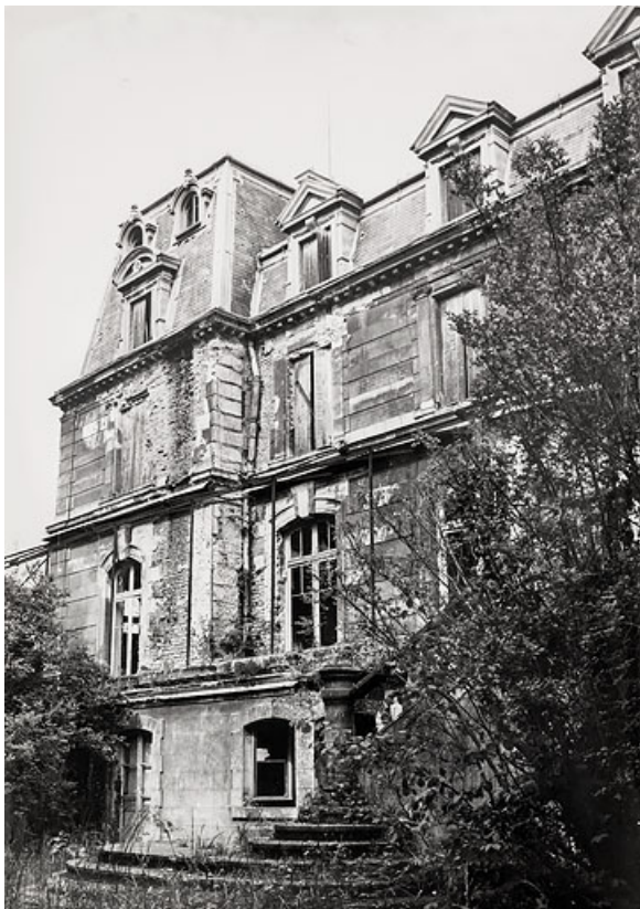
Vestiges de l'hôtel avant sa destruction.
