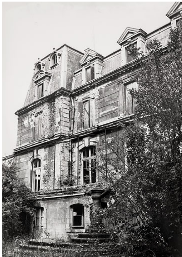
Vestiges de l'hôtel avant sa destruction.
