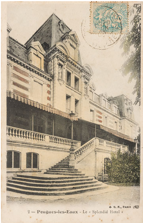
Façade ouest, pavillon central et escalier extérieur. 58, Pougues-les-Eaux, 25 avenue de Conti
