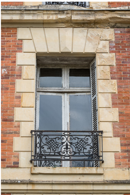
Façade sur l'avenue de Paris, détail, baie du premier étage.
