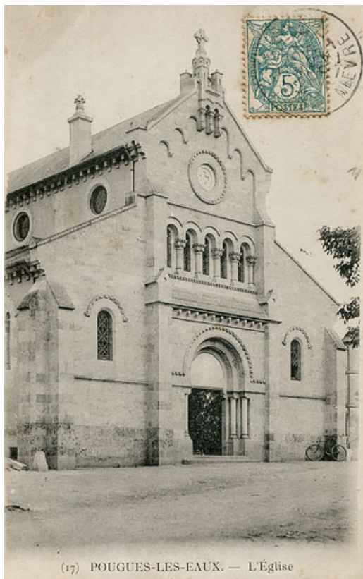
Façade de l'église au début du 20e siècle.
