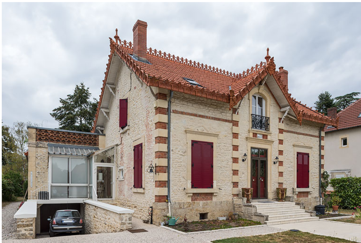
Façade principale, vue de trois-quarts.
