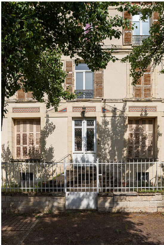
Façade ouest, détail avec la porte d'entrée.
