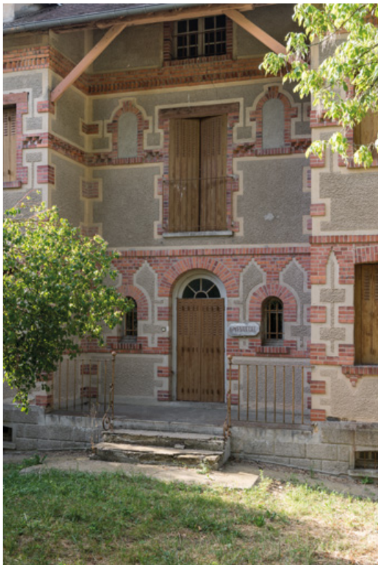
Façade principale, arrière-corps central.
