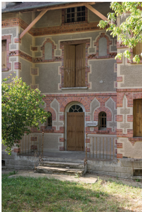
Façade principale, arrière-corps central.
