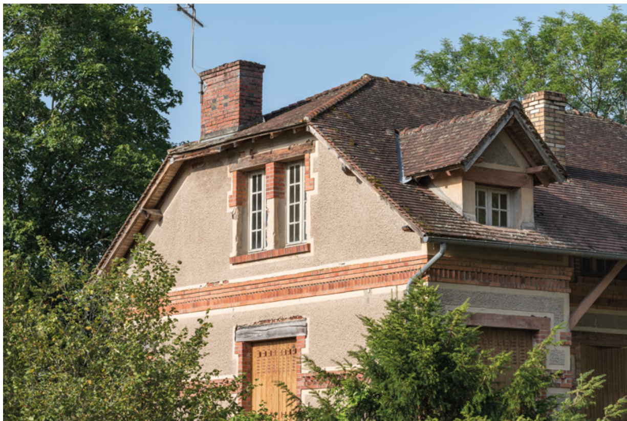
Détail de la toiture, demi-croupe et lucarne.
