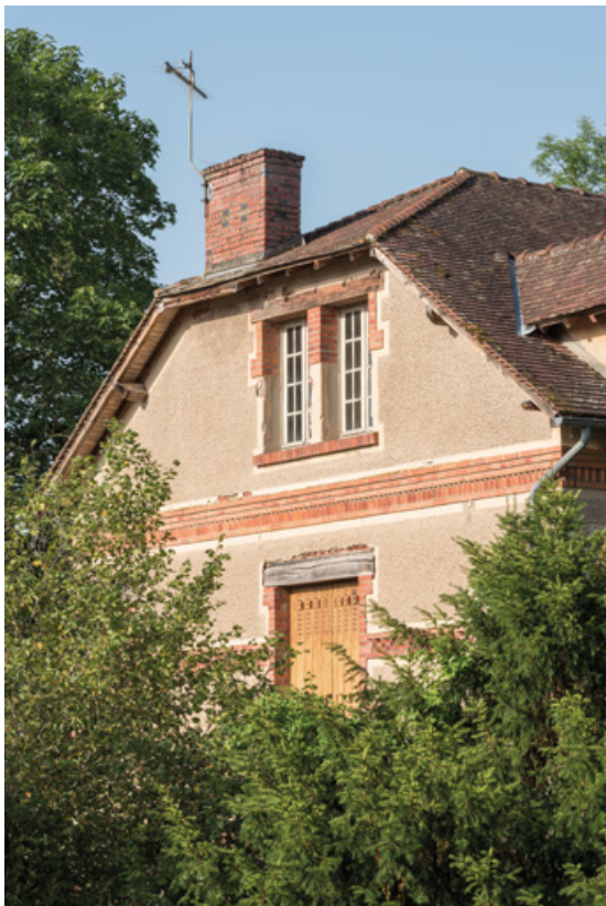
Mur pignon occidental, détail de l'étage de comble. 58, Saint-Honoré-les-Bains, 19 avenue Jean Mermoz
