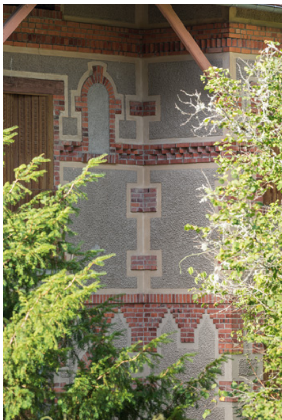
Façade principale, ressaut et décor de brique.
