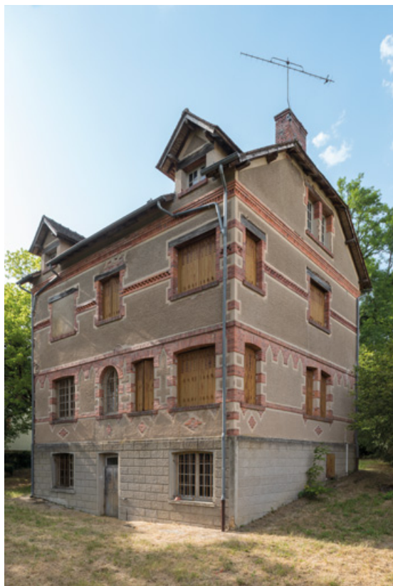
Façade postérieure, vue depuis le sud-est.
