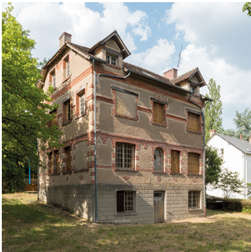
Façade postérieure, vue depuis le sud-ouest.
