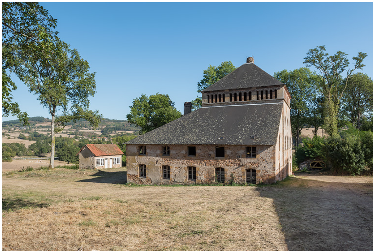
Vue depuis le nord-ouest, état actuel.
