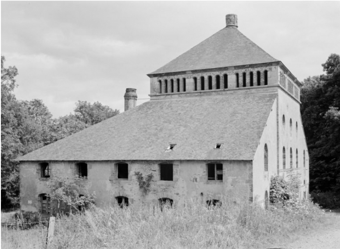
Vue depuis le nord-ouest, état en 1977.
