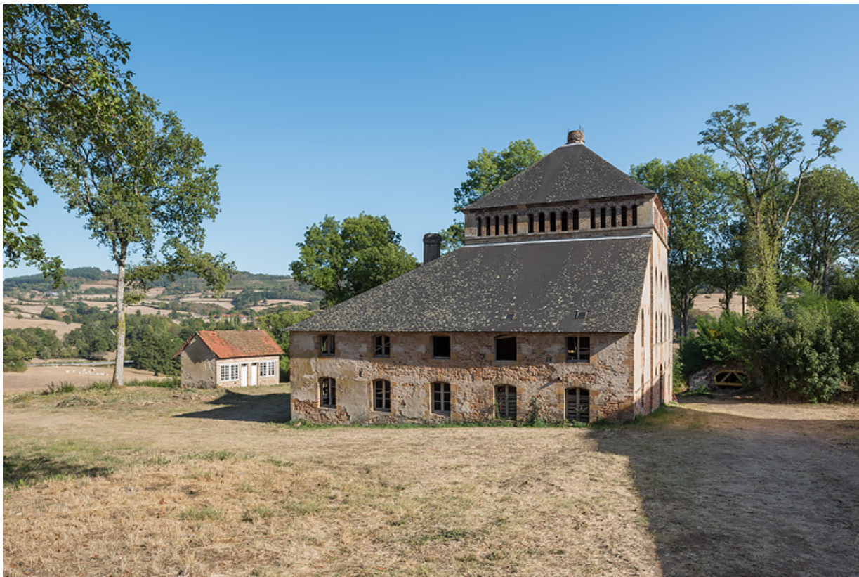
Vue depuis le nord-ouest, état actuel.
