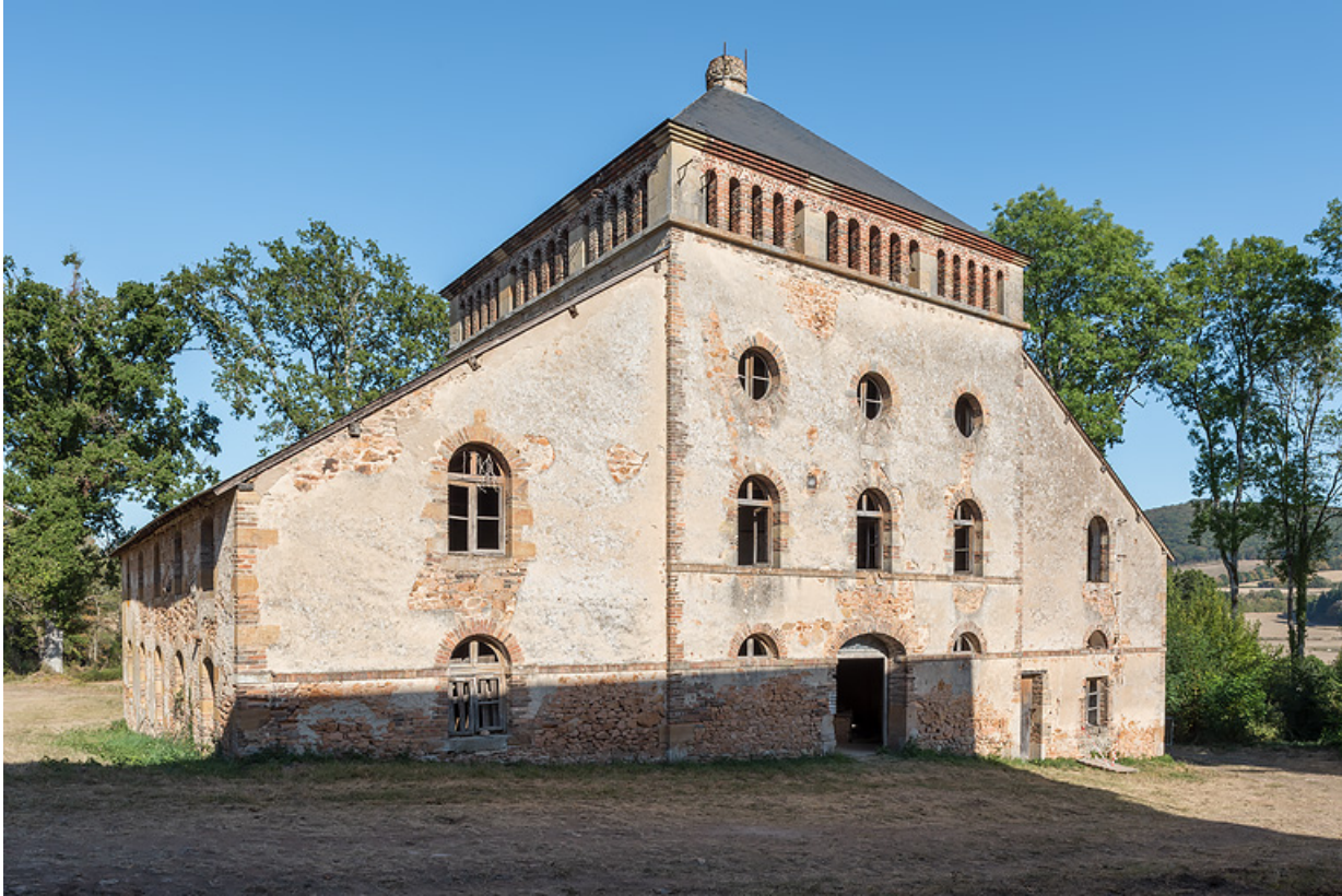
Vue depuis l'ouest, état actuel.
