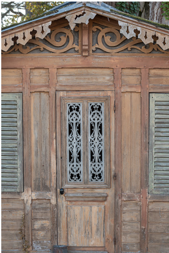
Décor en bois ajouré (lambrequins, pignon et vantail). 58, Saint-Honoré-les-Bains, lieudit : écart de La Montagne
