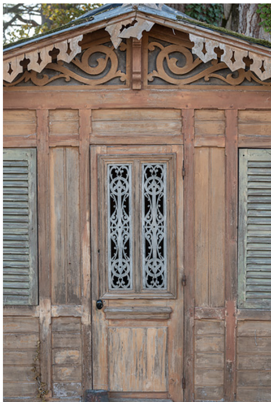
Décor en bois ajouré (lambrequins, pignon et vantail). 58, Saint-Honoré-les-Bains, lieudit : écart de La Montagne
