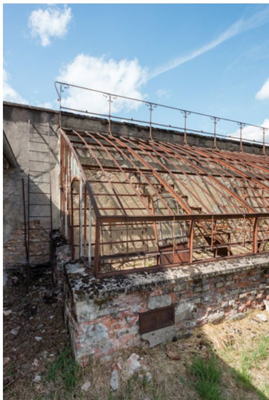
Détail de la structure métallique construite sur un muret en brique et adossée à un mur en calcaire.
