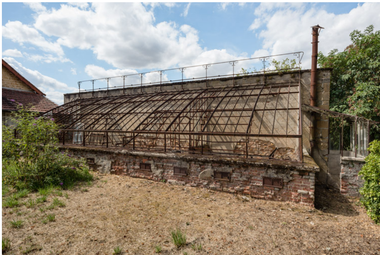
Vue d'ensemble depuis le sud-est avec l'emplacement de l'ancien système de chauffage à thermosiphon à droite. 58, Saint-Honoré-les-Bains, 8 avenue de Rémilly
