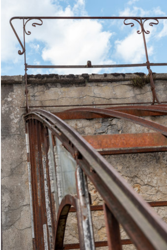
Détail de la structure métallique et du garde-corps de la galerie du mur. 58, Saint-Honoré-les-Bains, 8 avenue de Rémyilly
