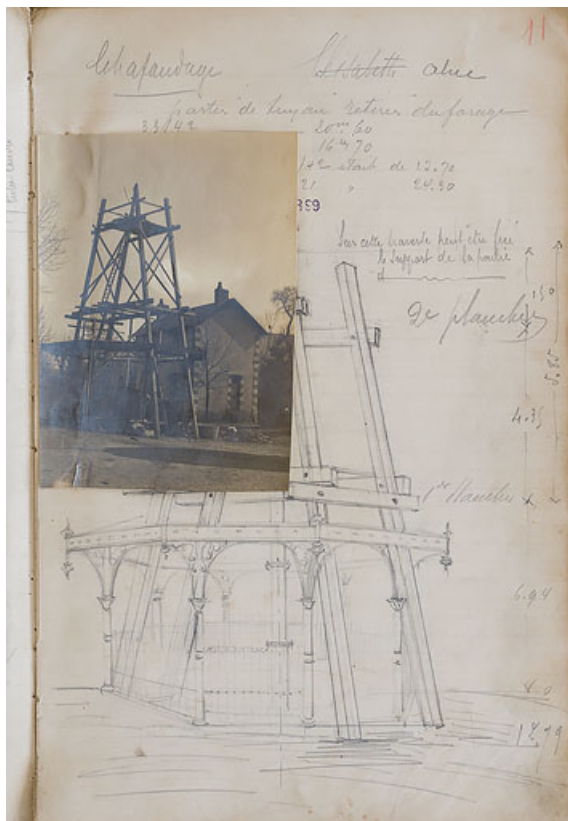
Premier kiosque au-dessus de la source Alice lors du forage de 1899.
