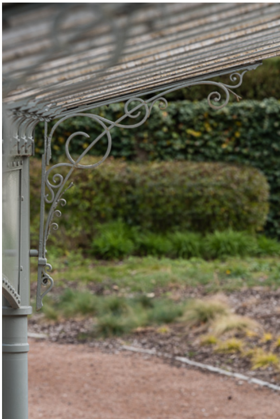
Buvette "reconstruite" à son emplacement actuel, détail de la structure d'origine. 58, Pougues-les-Eaux avenue de Paris
