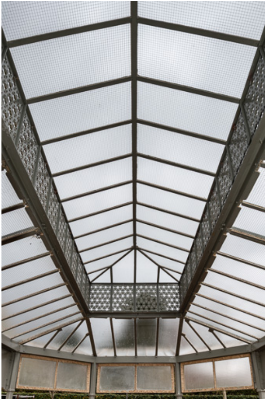
Buvette "reconstruite" à son emplacement actuel, vue intérieure. 58, Pougues-les-Eaux avenue de Paris
